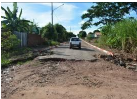
Figura 34 - Início de erosão em via não pavimentada com declividade acentuada
