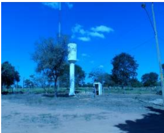
Figura 20 – Caixa d'água localizada junto a igreja.
