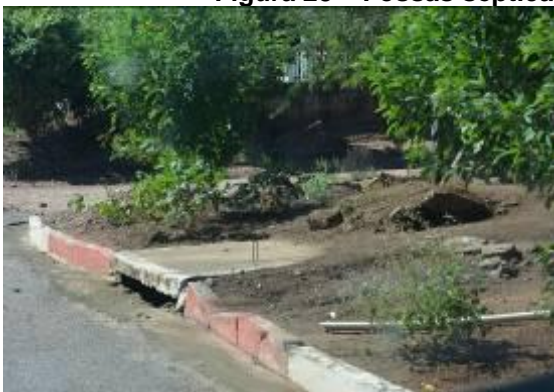
Figura 29 – Canalização de águas cinzas para boca de lobo.
