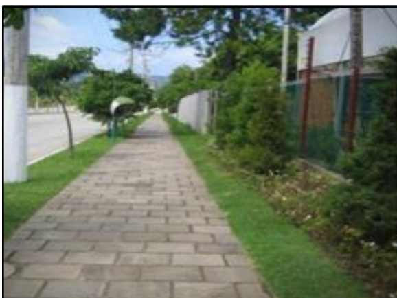
Figura 93. Vala de retenção ao longo da rua
