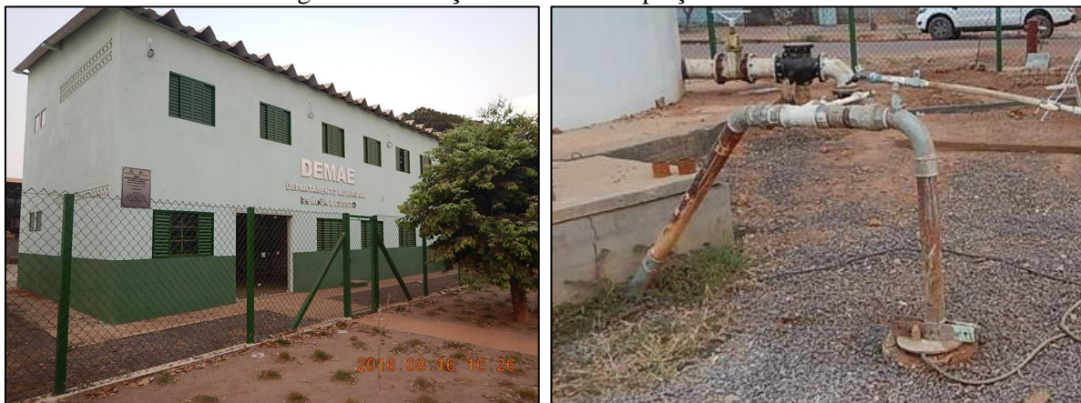
Figura 8. Instalações da área de captação do PT-01
