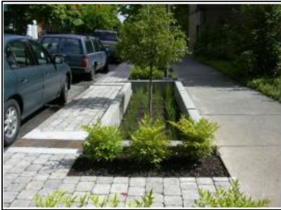
Figura 91. Trincheira de infiltração no passeio
