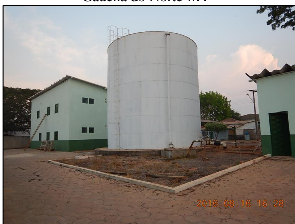
Figura 11. Reservatório metálico apoiado localizado na área de captação do PT-01, em Gaúcha do Norte-MT
