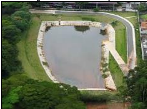
Figura 95. Bacia de detenção
