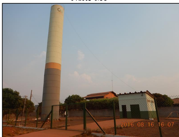
Figura 12. Reservatório elevado localizado na área de captação do PT-02, em Gaúcha do Norte-MT
