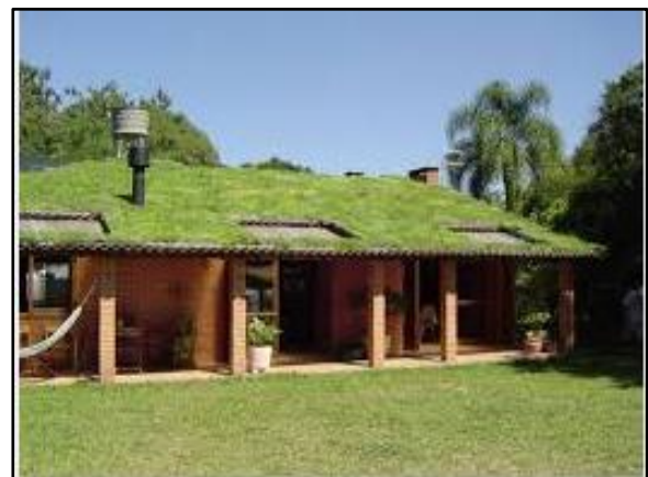
Figura 86. Telhado verde com plantas
