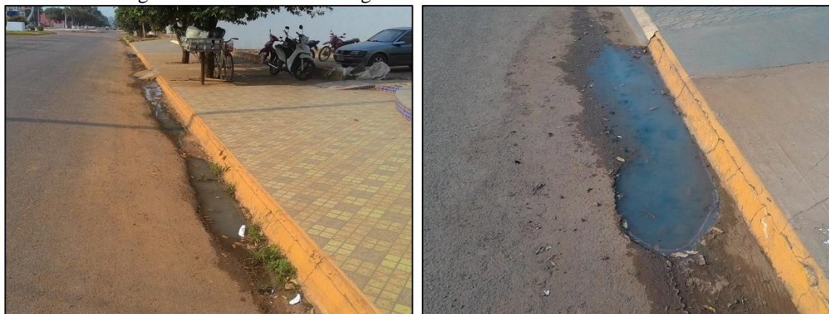
Figura 17. Escoamento de esgoto a céu aberto em Gaúcha do Norte-MT
