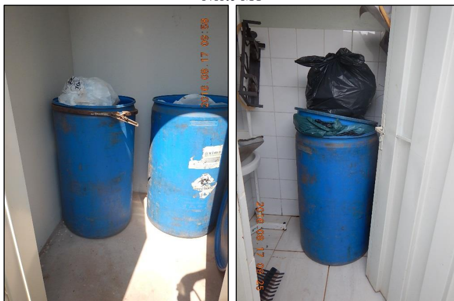
Figura 49. Armazenamento de RSS no interior do abrigo das unidades básicas de saúde de Gaúcha do Norte-MT
