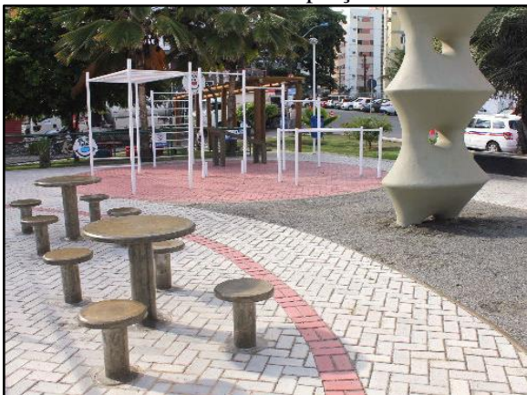
Figura 87. Pavimento poroso – piso intertravado instalado em praça
