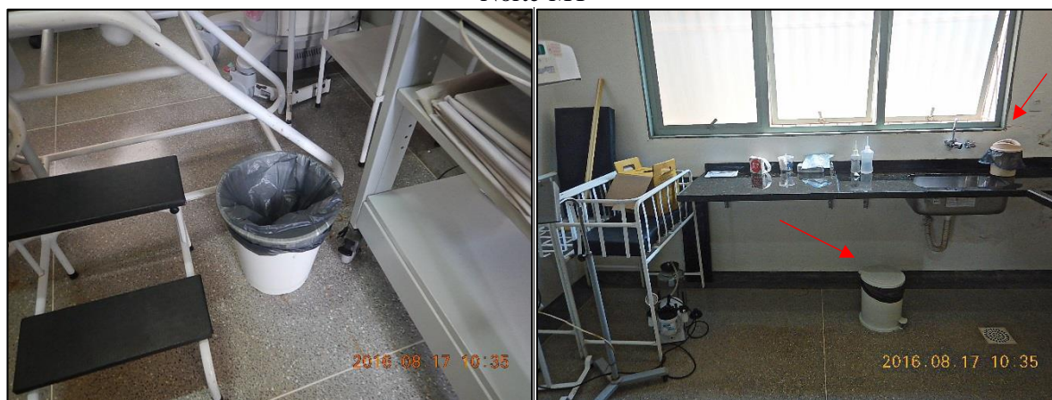
Figura 47. Acondicionamento de resíduos sólidos do Grupo D no Hospital Municipal de Gaúcha do Norte-MT
