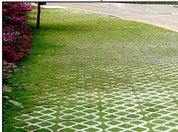
Figura 88. Pavimento poroso – concregrama instalado em passeio
