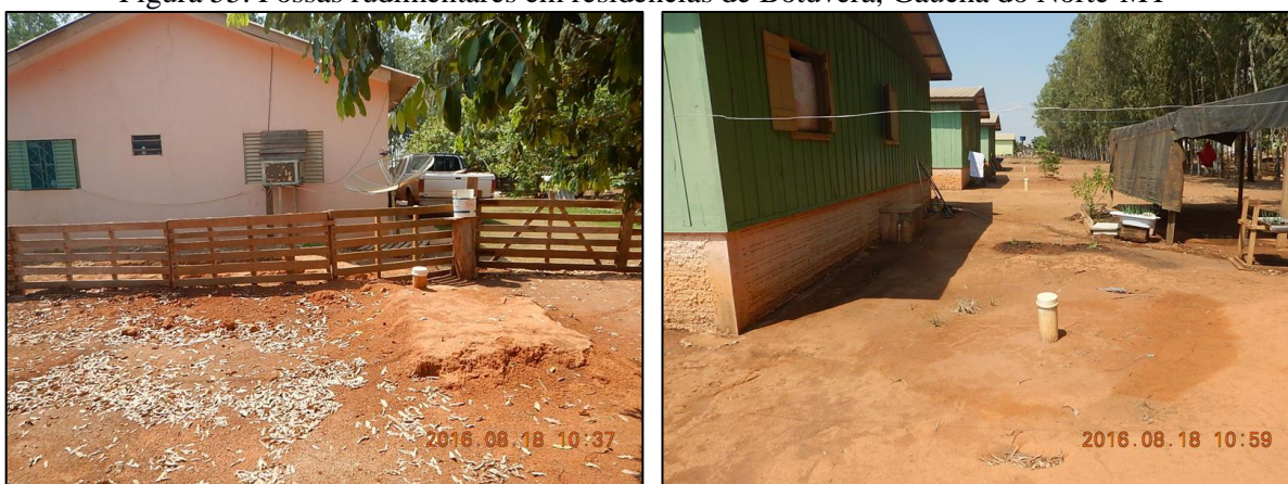
Figura 55. Fossas rudimentares em residências de Botuverá, Gaúcha do Norte-MT
