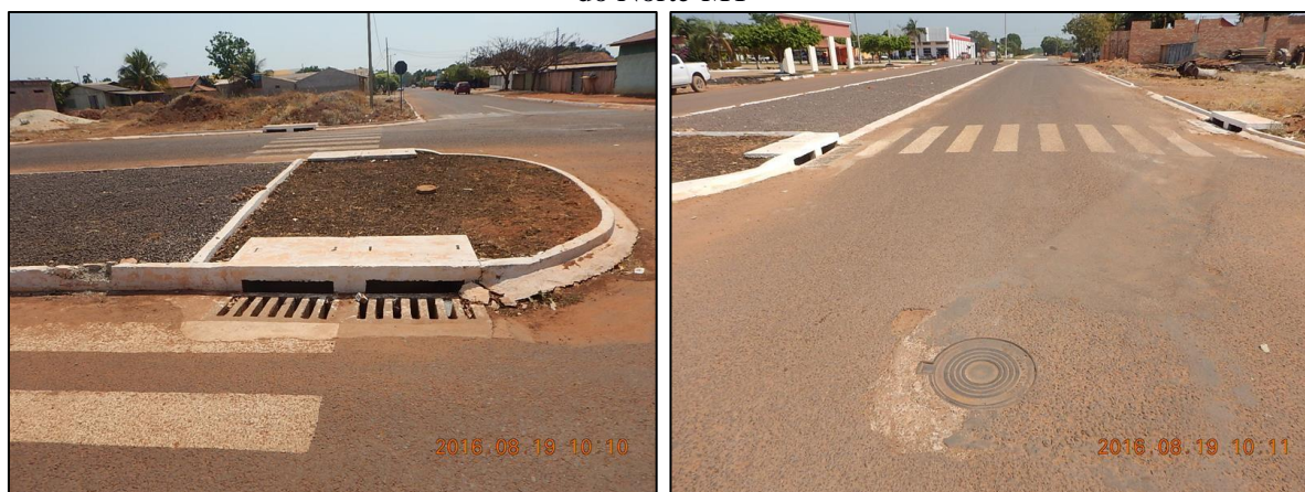
Figura 20. Modelo de dispositivos de microdrenagem observados na Avenida 13 de Julho, em Gaúcha do Norte-MT
