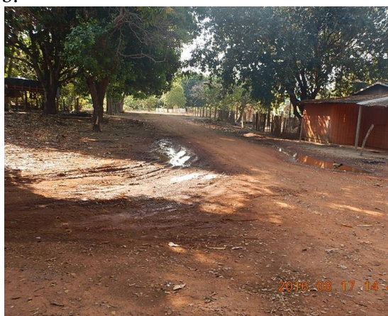
Figura 62. Erosão nas margens de um barranco (a) e formação de poças d'água em via não pavimentada (b), Nova Aliança, Gaúcha do Norte-MT
