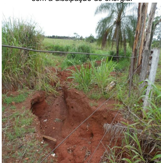
Figura 50 – Erosão em área de chácara em Monte Castelo.
