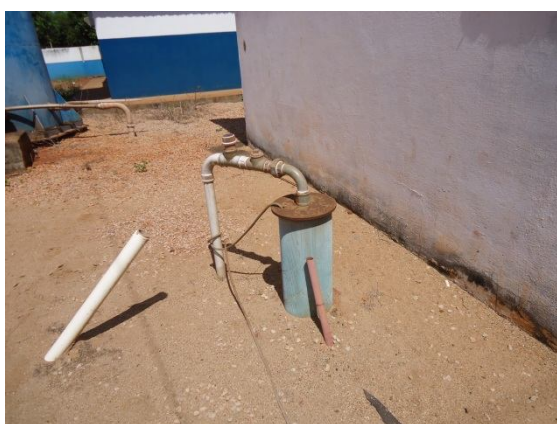
Figura 24 – Poço nº 5 Monte Castelo
