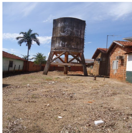
Figura 29 – Reservatório área urbana (desativado)
