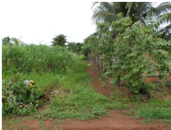
Figura 42 – Canal natural na Quadra 50 com lotes de divisa
