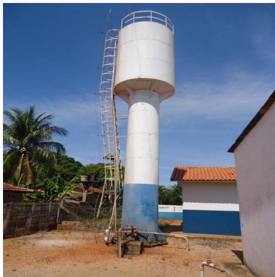
Figura 27 – Reservatório Monte Castelo
