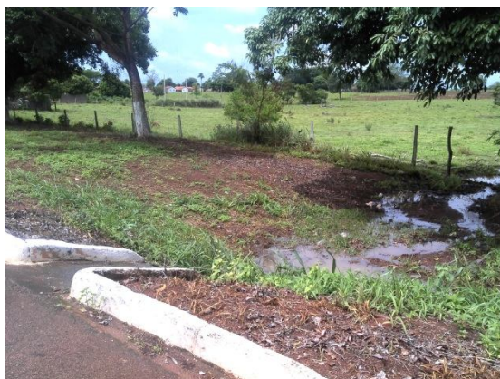
Figura 40 – Destino final após encaminhamento da boca de lobo.
