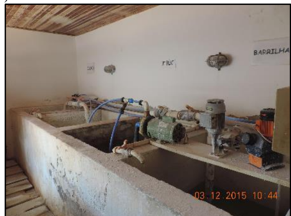
Figura 20. Tanques de preparo das soluções de sulfato de alumínio, polímero e hipoclorito de cálcio (A), tanque de cal (B) e tanque do flúor (C) (A)
