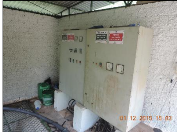
Figura 10. Abrigo do sistema de bombeamento (A), quadro de comando do conjunto motobomba (B) abrigo e contêiner do combustível (C)
