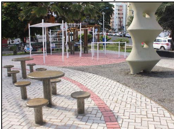
Figura 92. Pavimento poroso – piso intertravado instalado em praça
