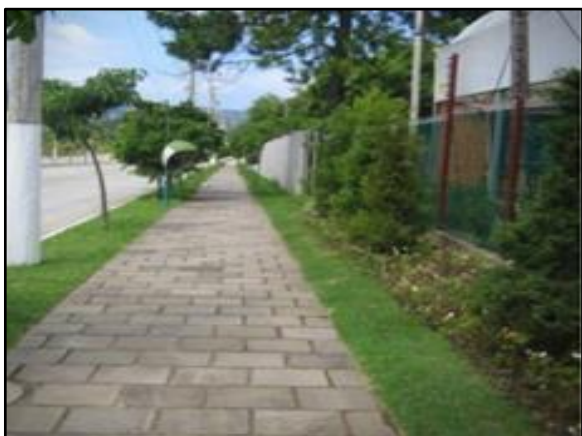
Figura 98. Vala de retenção ao longo da rua
