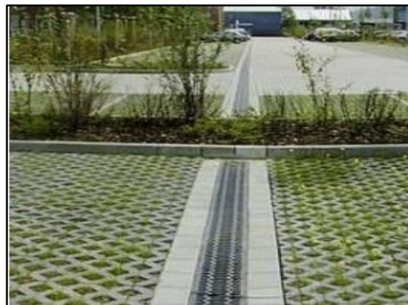
Figura 97. Trincheira de infiltração no estacionamento
