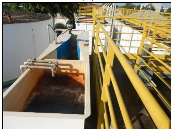
Figura 15. Aplicação da solução de sulfato de alumínio na ETA 1 (A) e ETA 2 (B)
