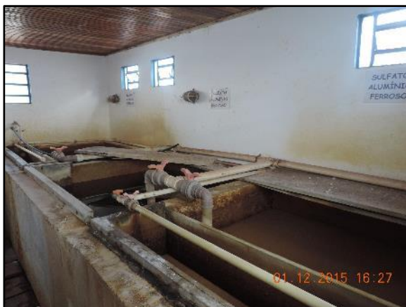
Figura 20. Tanques de preparo das soluções de sulfato de alumínio, polímero e hipoclorito de cálcio (A), tanque de cal (B) e tanque do flúor (C) (A)
