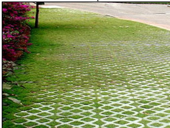
Figura 93. Pavimento poroso – concregrama instalado em passeio
