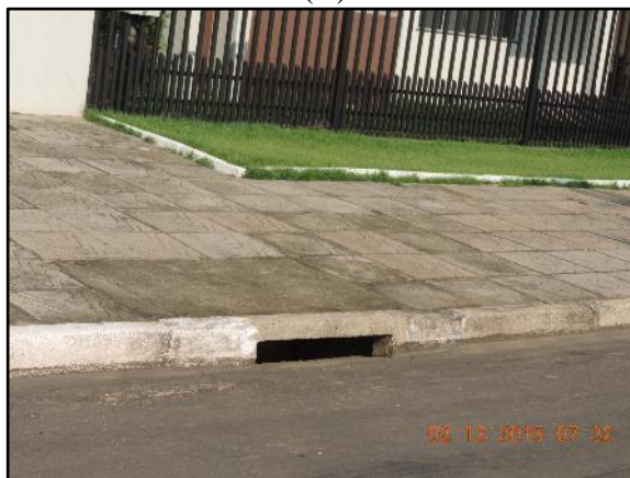
Figura 46. Dispositivos de microdrenagem existentes no núcleo urbano de Guarantã do Norte, meio-fio e sarjeta (A), boca de lobo (B), poço de visita (C)
