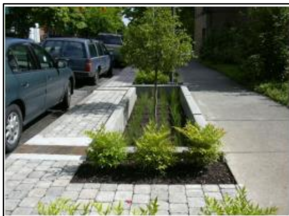
Figura 96. Trincheira de infiltração no passeio
