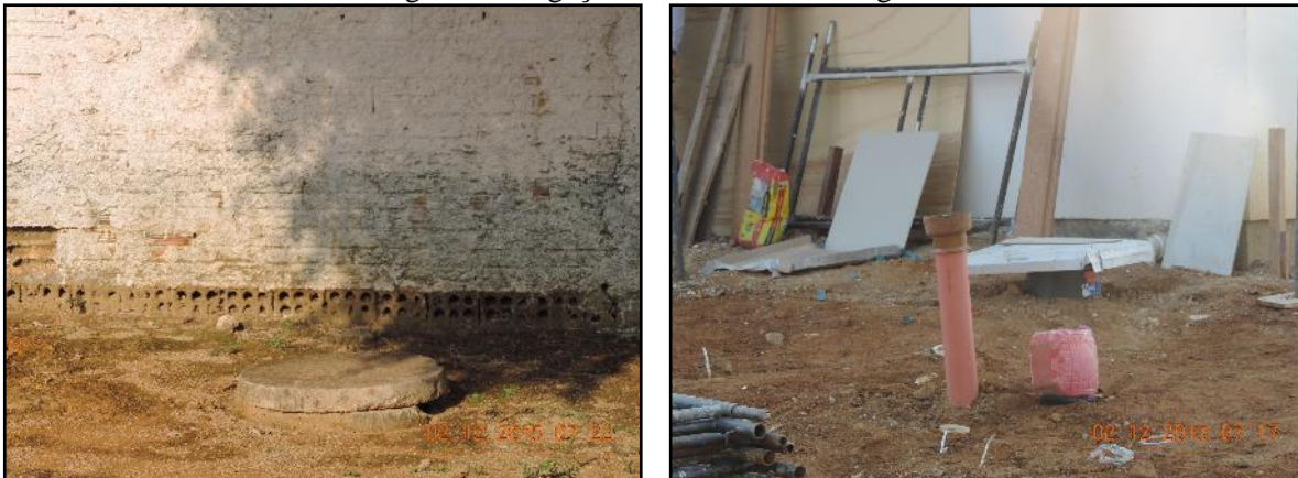
Figura 34. Ligações domiciliares de esgoto
