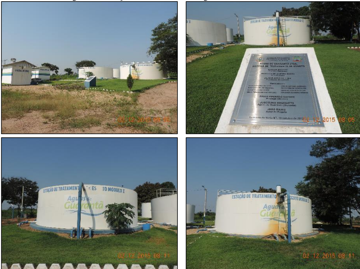
Figura 36. Estação de tratamento de esgoto de Guarantã do Norte
