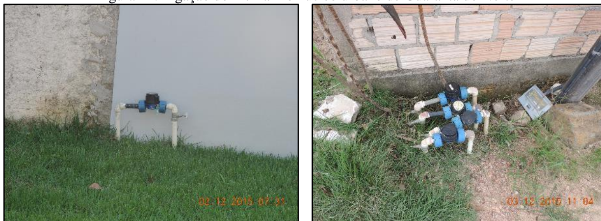
Figura 24. Ligação domiciliar no núcleo urbano de Guarantã do Norte
