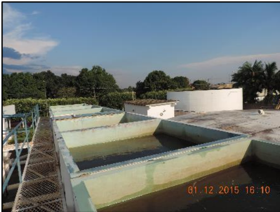
Figura 18. Filtros de múltiplas camadas com fluxo descendentes: ETA-1 (A) e ETA-2 (B)
