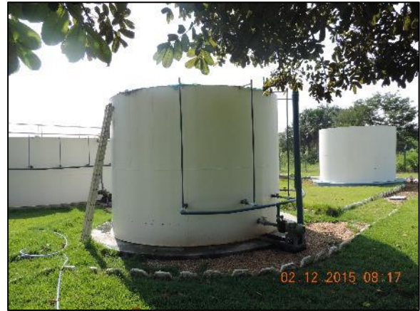
Figura 37. Flotador (A) e reator aerado (B) da ETE Central (A)
