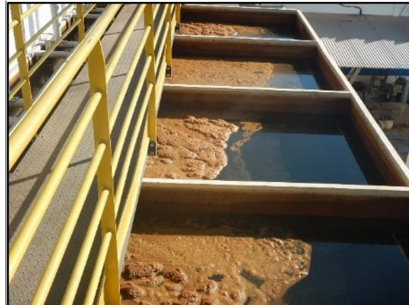
Figura 18. Filtros de múltiplas camadas com fluxo descendentes: ETA-1 (A) e ETA-2 (B)
