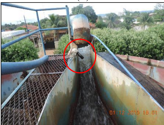
Figura 15. Aplicação da solução de sulfato de alumínio na ETA 1 (A) e ETA 2 (B)
