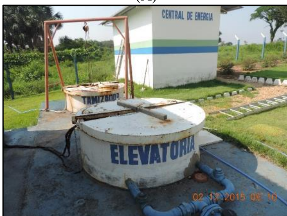
Figura 35. Estação elevatória de esgoto (A), poço preliminar com cesto (B) e poço de sucção (C)
