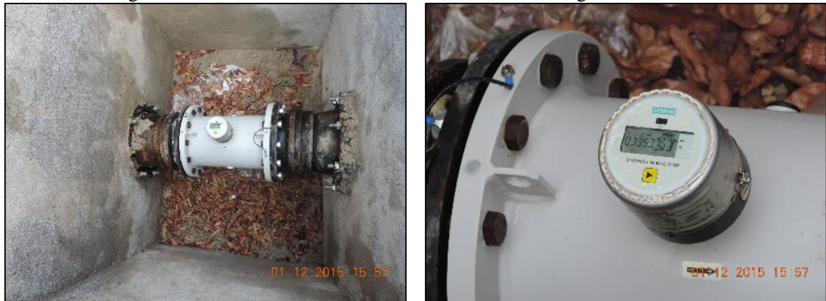
Figura 11. Macromedidor instalado na área da ETA da Águas de Guarantã
