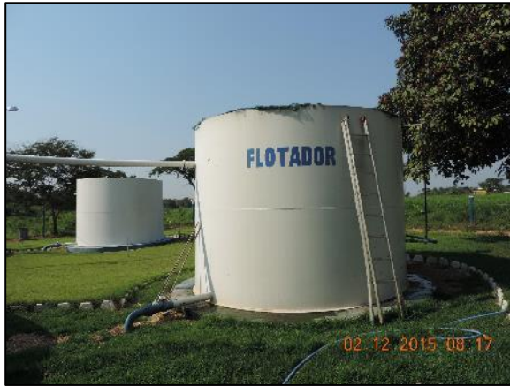
Figura 37. Flotador (A) e reator aerado (B) da ETE Central (A)
