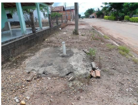
Figura 35 – sumidouros na calçada
