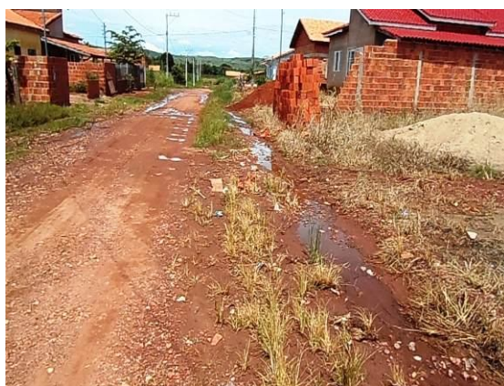
Figura 45 – Rua com lençol freático aflorante
