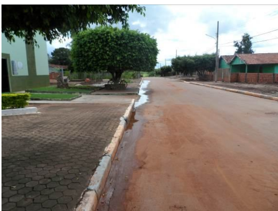
Figura 46 – Escoamento oriundo de áreas com lençol aflorante
