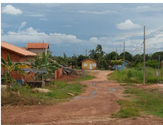
Figura 44 – Condição de via com lençol aflorante
