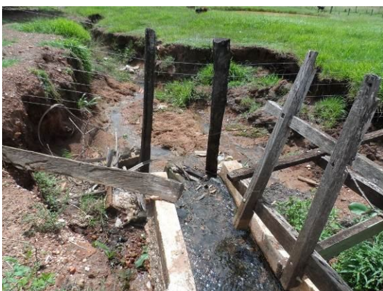
Figura 43 – Canal de drenagem sem dissipador
