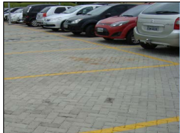
Figura 109. Pavimento poroso instalado em estacionamento
