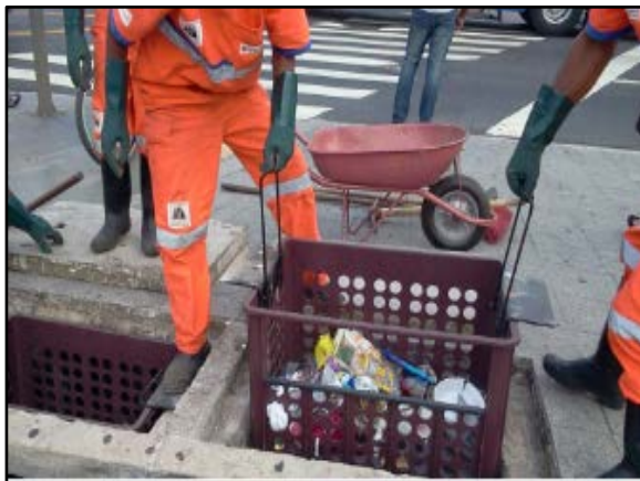
Figura 102. Cesta acoplada à boca do bueiro
