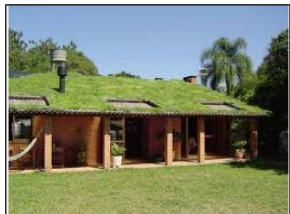
Figura 105. Telhado verde com plantas
