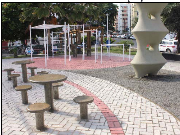
Figura 106. Pavimento poroso – piso intertravado instalado em praça
