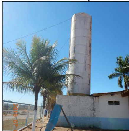
Figura 23. Reservatório com capacidade de 100 m 3
