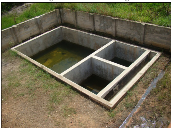
Figura 30. Leito de Secagem do Lodo da ETA e Casa de Química/Laboratório
