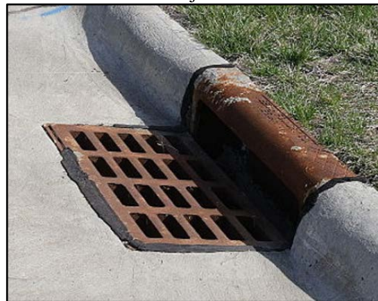
Figura 103. Boca de lobo com gradeamento na sarjeta
