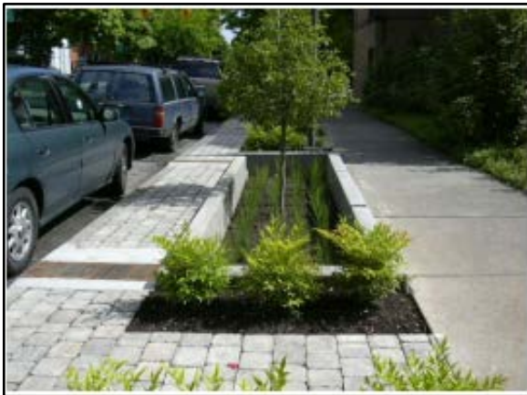
Figura 110. Trincheira de infiltração no passeio
