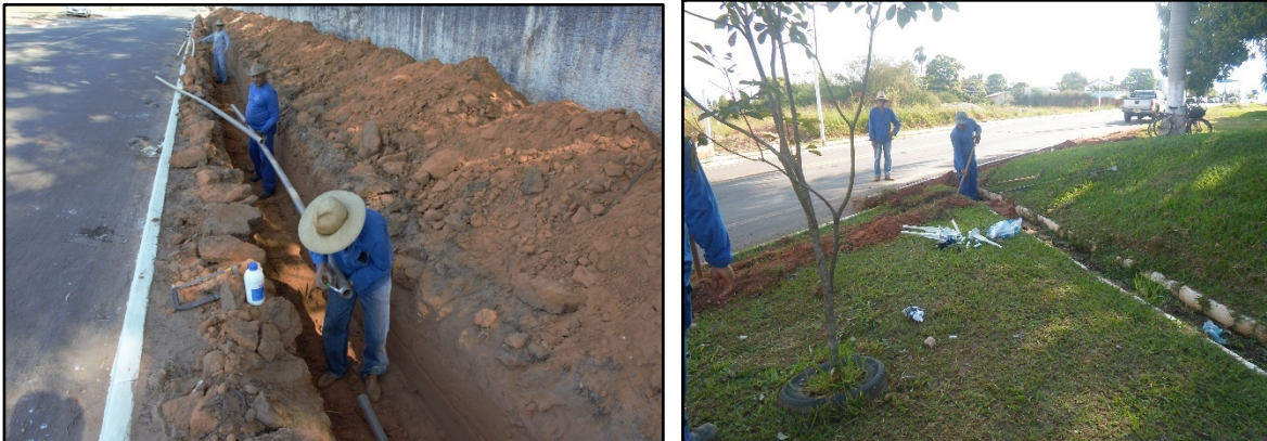
Figura 31. Ampliação da rede de distribuição de água
