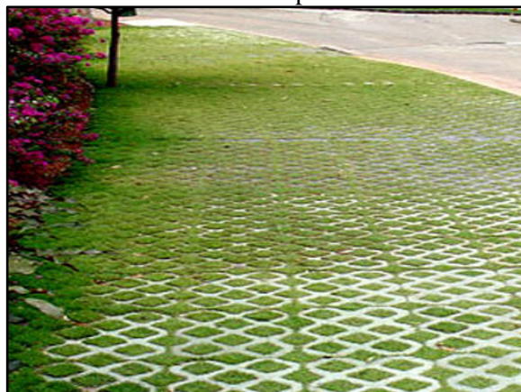
Figura 107. Pavimento poroso – concregrama instalado em passeio
