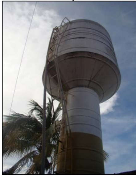
Figura 24. Reservatório elevado em taça metálico com capacidade de 30 m 3
