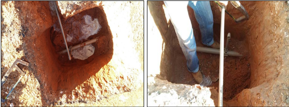
Figura 33. Execução de ligação predial
