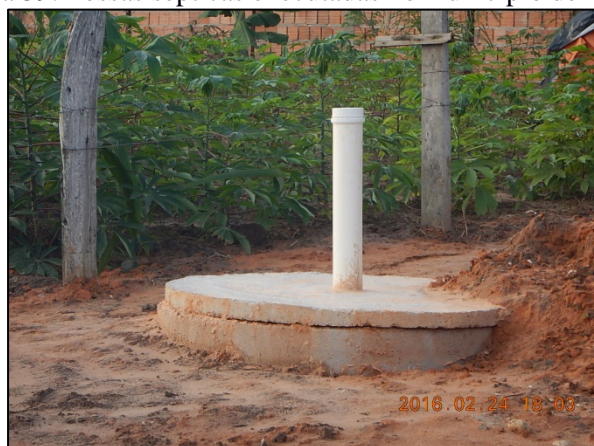
Figura 39. Fossas sépticas executadas no município de Itiquira
