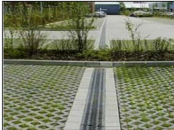
Figura 111. Trincheira de infiltração no estacionamento
