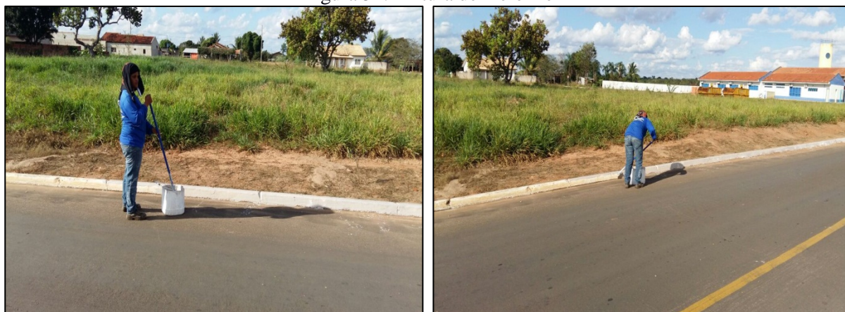
Figura 54. Pintura de meio-fio
