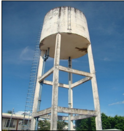
Figura 20. Reservatório elevado em concreto armado com capacidade de 150 m 3
