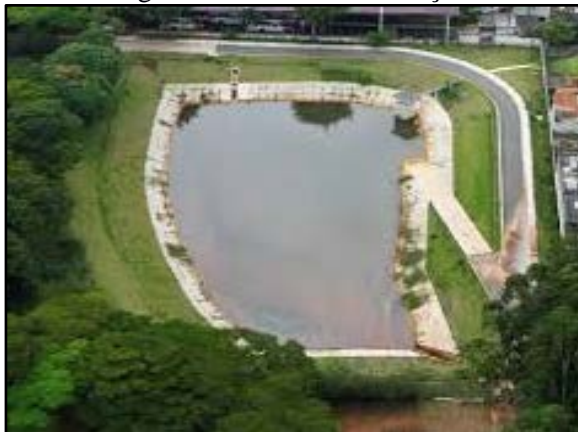
Figura 114. Bacia de detenção
