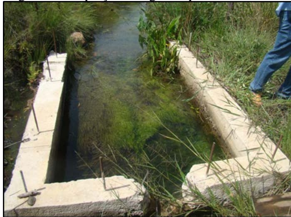
Figura 28. Captação de água Superficial em Mina
