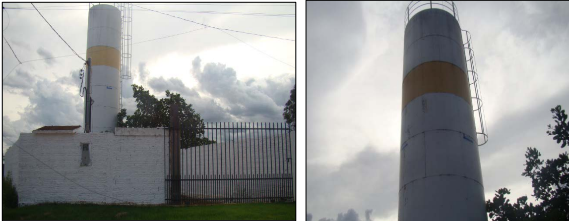
Figura 22. Reservatório elevado cilíndrico metálico com capacidade de 100 m 3
