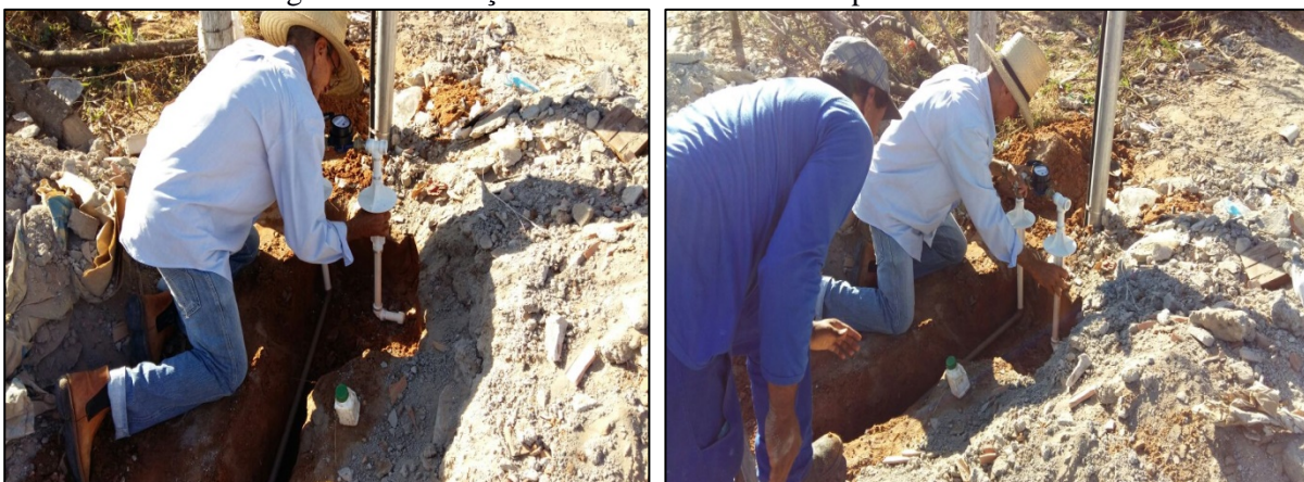
Figura 32. Instalação de hidrômetro em ramal predial em PVC
