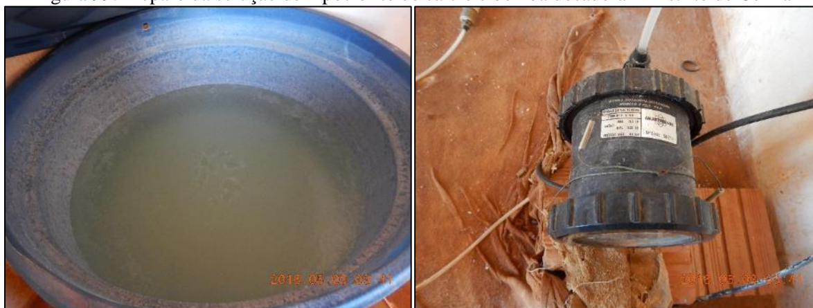
Figura 99. Preparo da solução de hipoclorito de cálcio e bomba dosadora – Distrito de Celma
