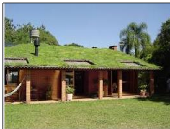
Figura 128. Telhado verde com plantas
