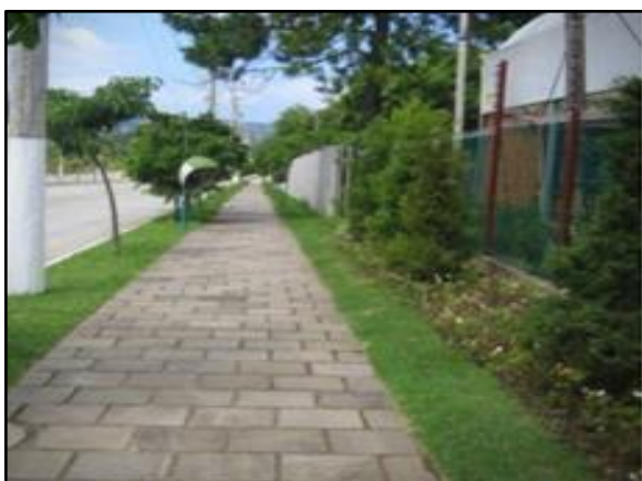
Figura 135. Vala de detenção ao longo da rua
