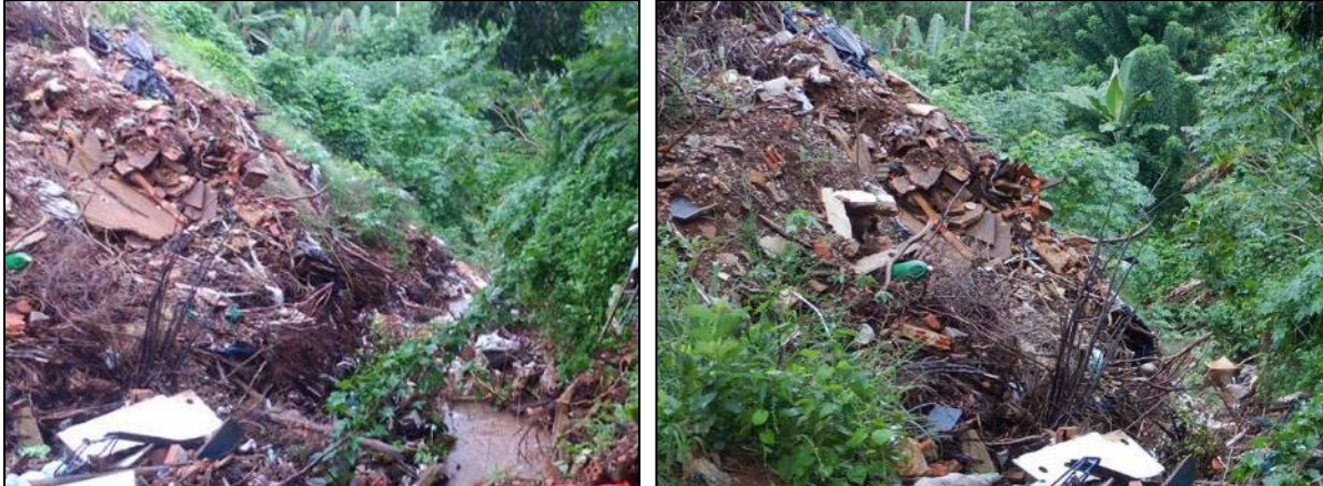
Figura 89. Disposição de resíduos de construção e demolição no bolsão de lixo B-08, em Jaciara
