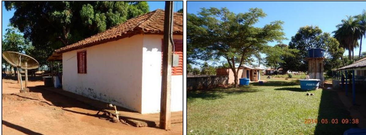
Figura 100. Ligação domiciliar de água hidrometrada e reservatórios domiciliares para armazenamento de água no distrito de Celma
