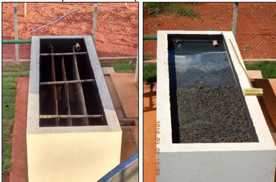
Figura 34. Flocculador do tipo chicana antes e após o início do funcionamento da ETE, em Jaciara
