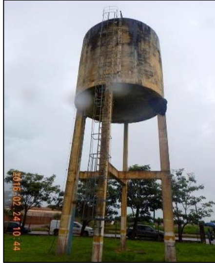
Figura 18. Reservatório elevado de concreto não utilizado pelo DAE de Jaciara
