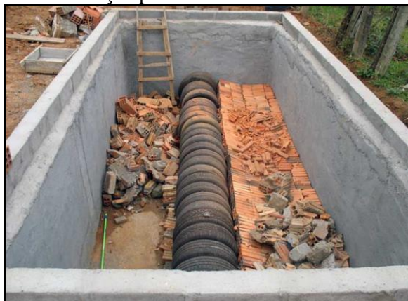
Figura 121. Método do círculo de bananeiras em execução para tratamento individual
