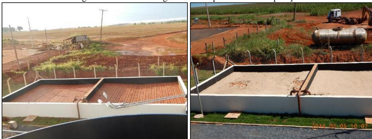
Figura 37. Leito de secagem antes e após o início da operação
