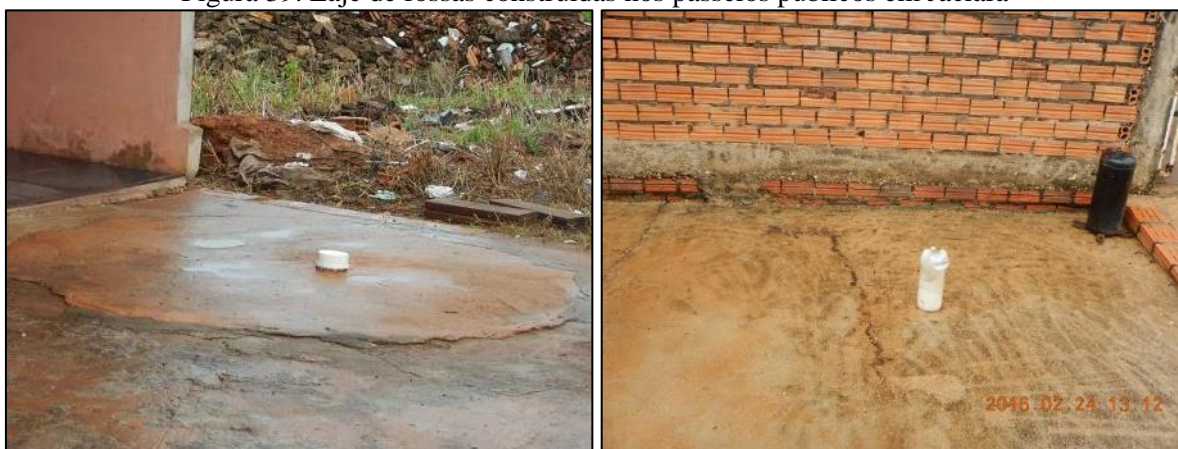
Figura 39. Laje de fossas construídas nos passeios públicos em Jaciara
