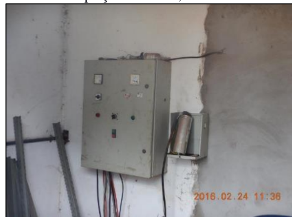
Figura 11. Abrigo do quadro de comando da bomba da captação do PT 02, em Jaciara
