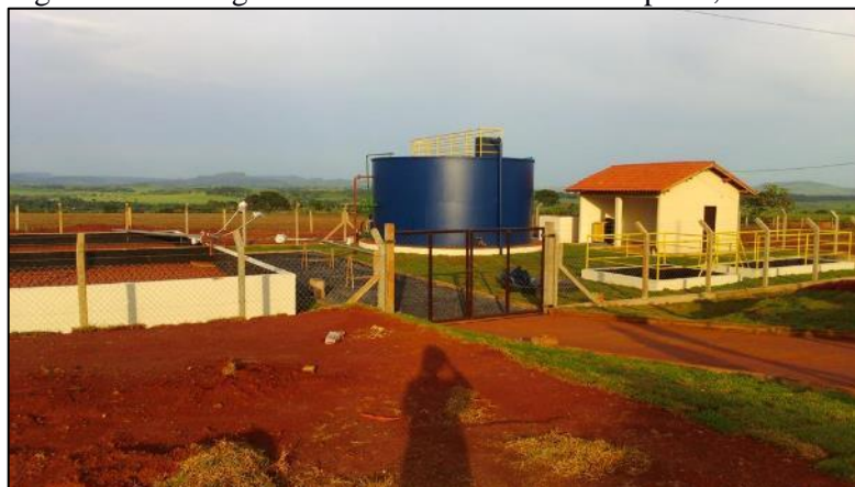
Figura 28. Visão geral da ETE do bairro Jd. Aeroporto, em Jaciara
