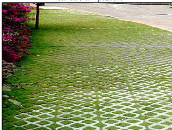
Figura 130. Pavimento poroso – concregrama instalado em passeio
