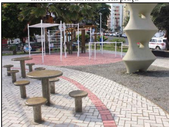
Figura 129. Pavimento poroso – piso intertravado instalado em praça
