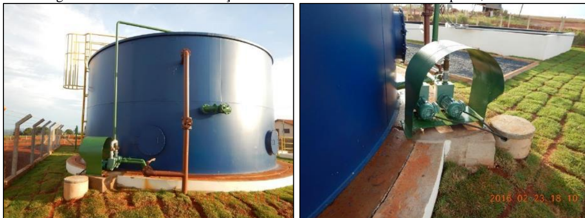
Figura 36. Sistema de recirculação do lodo da ETE do bairro Jd. Aeroporto, em Jaciara
