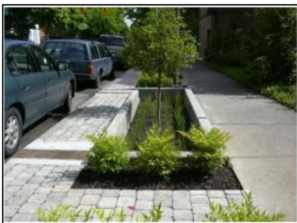
Figura 133. Trincheira de infiltração no passeio
