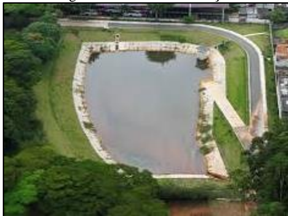
Figura 137. Bacia de detenção
