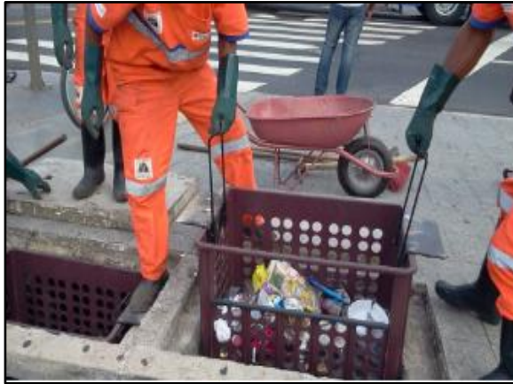
Figura 125. Cesta acoplada à boca do bueiro
