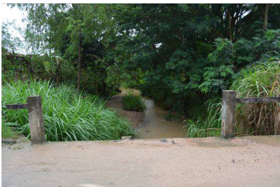
Figura 56– Canalização em seção aberta do Córrego da Saúde
