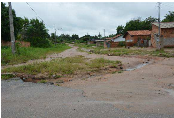
Figura 64- Erosão em via não pavimentada causada pelo lançamento de águas pluviais sem a dissipação de energia.
