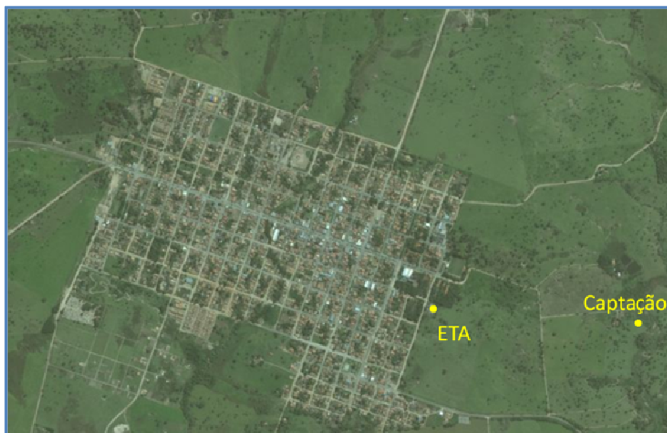
Figura 35: Estação de Tratamento de Água de Jauru (FONTE: ÁGUAS DE JAURU)
