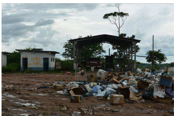
Figura 74 – Galpão e instalações abandonadas.
