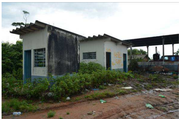
Figura 70 – Guarita de entrada do lixão
