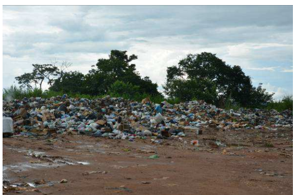
Figura 72 – Resíduos dispostos sem cobertura.
