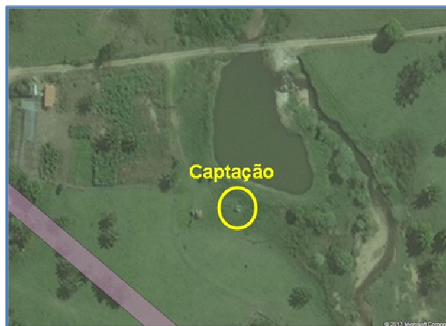
Figura 4: Ponto de Captação de Água – Jauru – MT (fonte: Águas de Jauru)
