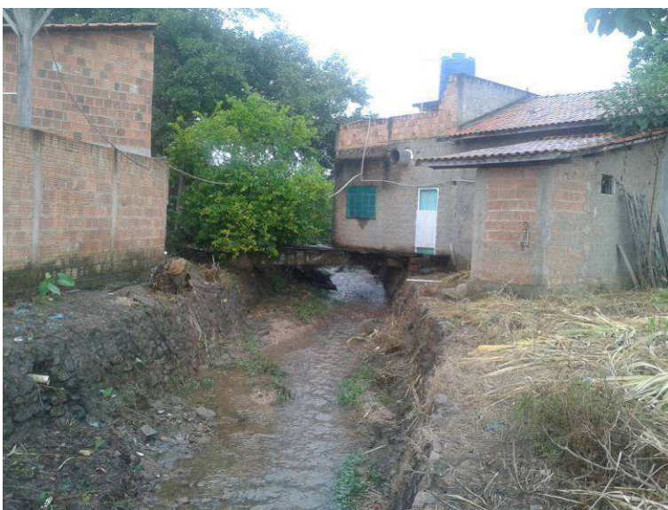
Figura 58 – residência sobre o leito do córrego
