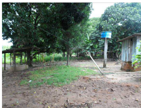
Figura 27 – Poço utilizado para abastecimento a jusante de fossa rudimentar.
