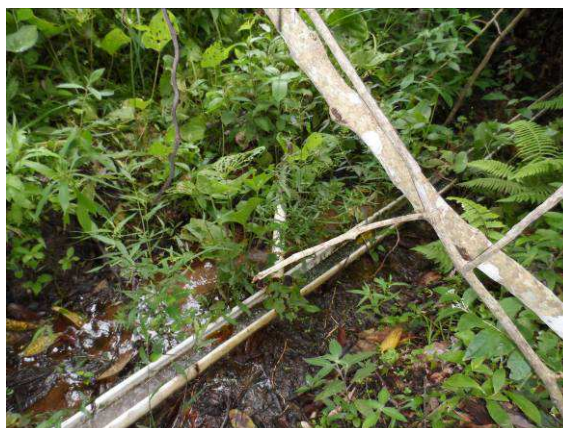
Figura 31 – sistema de condução por gravidade para abastecimento.
