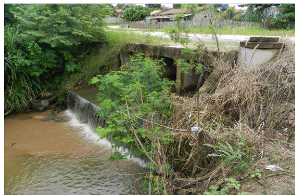
Figura 57 – Ponte e Bueiro celular no córrego da Saúde
