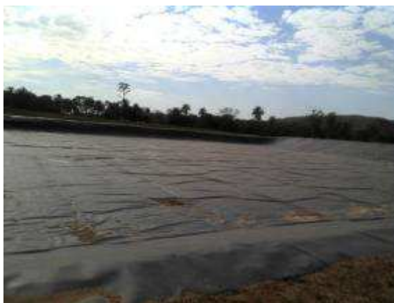
Figura 76 – Vala impermeabilizada do aterro sanitário consorciado.
