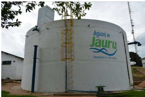
Figura 11: Vista Reservatório ETA RAP -01
