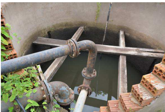
Figura 32 – Poço de Sucção para adutora.
