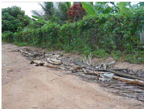
Figura 60 – Deposição de resíduos para amortização da erosão por moradores.
