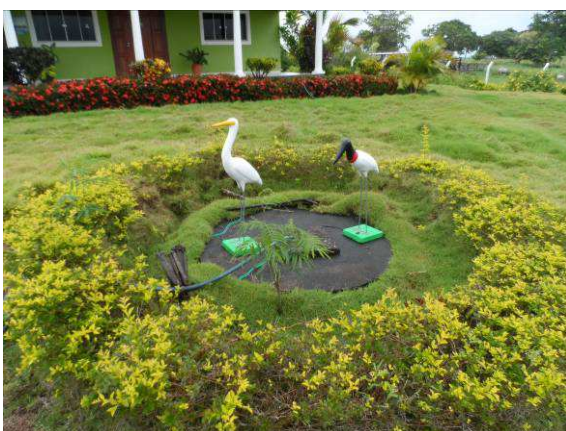
Figura 26 – Poço tubular para abastecimento.
