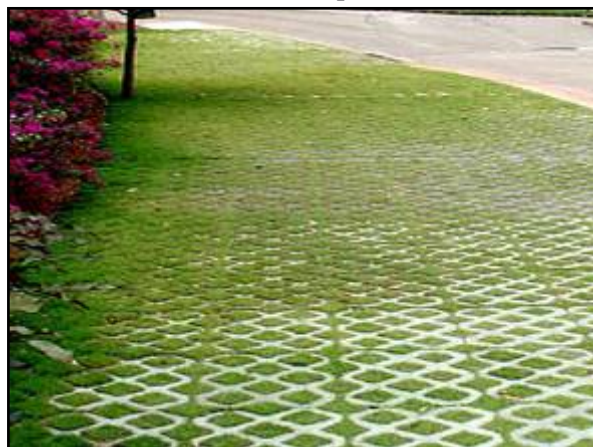
Figura 148. Pavimento poroso – concregrama instalado em passeio
