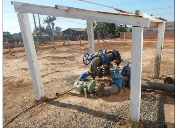
Figura 85. Vista da bomba de recalque de distribuição, Paranorte, Juara-MT
