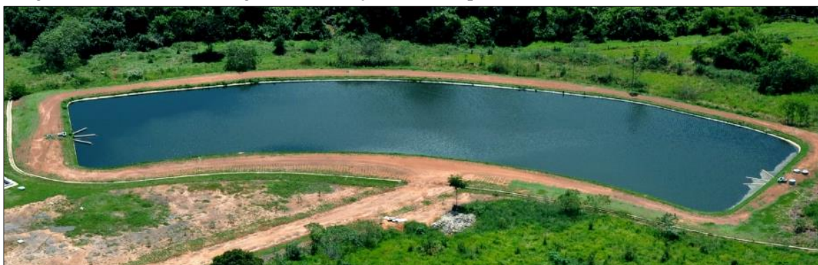
Figura 31. Vista aérea da lagoa de maturação utilizada para tratamento terciário na ETE de Juara
