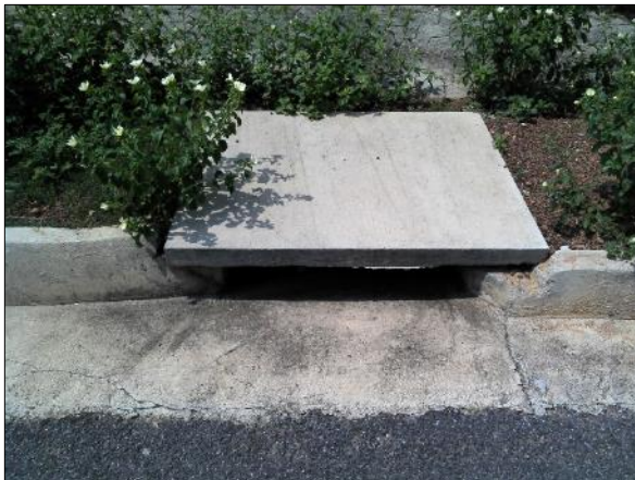
Figura 39. Boca de lobo na rua Sorocaba apresenta bom estado de conservação
