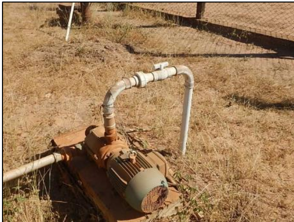
Figura 69. Bomba de eixo horizontal (a), reservatório elevado (R2), Águas Claras, Juara-MT
