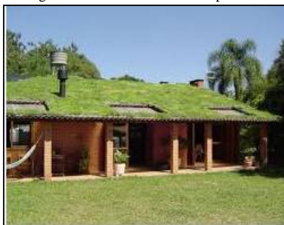
Figura 146. Telhado verde com plantas
