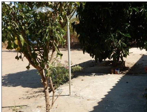
Figura 118. Vista exterior de fossa sem suspiro e coberta com lona (a) e vista exterior de fossa com suspiro (b), Água Boa, Juara-MT
