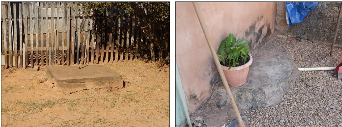
Figura 71. Vista exterior de fossa com suspiro (a) e fossa sem suspiro (b), Águas Claras, Juara-MT
