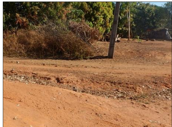
Figura 111. Via não pavimentada (a) e processo erosivos (b), Catuaí, Juara-MT
