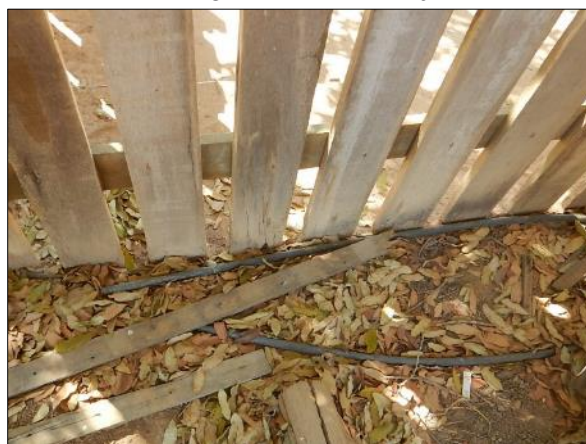
Figura 127. Rede de mangueira PEAD, Projeto Casulo, Juara-MT
