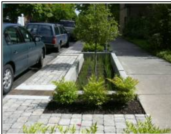
Figura 151. Trincheira de infiltração no passeio
