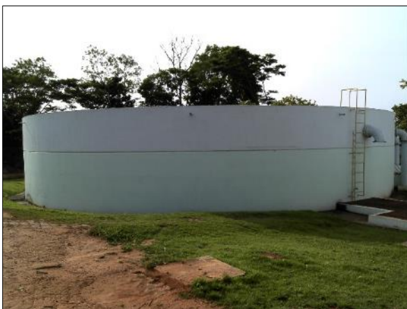
Figura 23. Vista do Reservatório RP 1 em concreto armado
