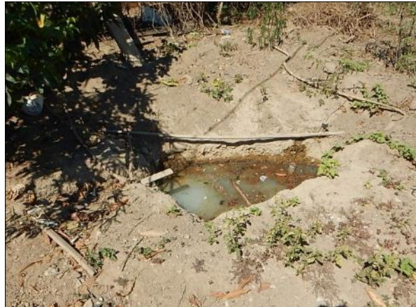
Figura 119. Disposição de efluente de pia e tanque a céu aberto, Água Boa, Juara-MT
