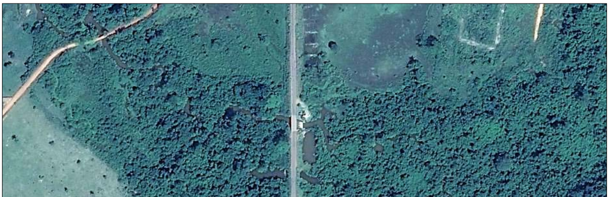
Figura 7. Vista aérea do local de captação no córrego Alcebiádes em Juara-MT
