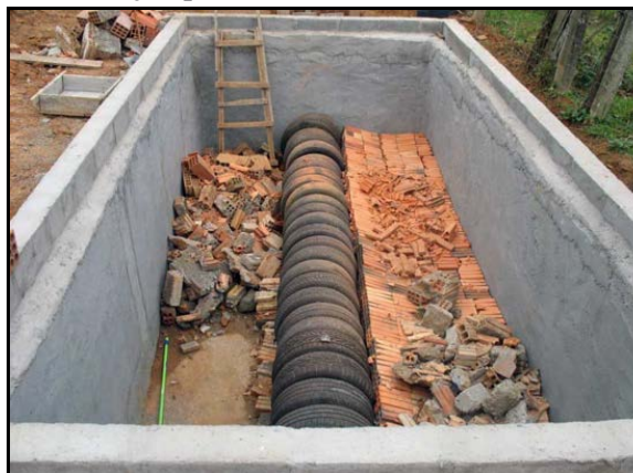
Figura 140. Método do círculo de bananeiras em execução para tratamento individual
