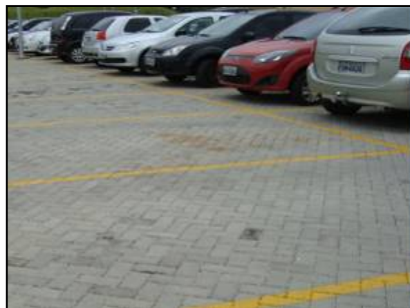
Figura 150. Pavimento poroso instalado em estacionamento
