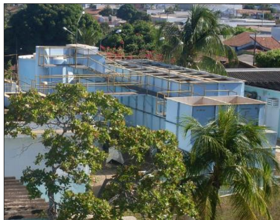
Figura 13. Vista da ETA metálica
