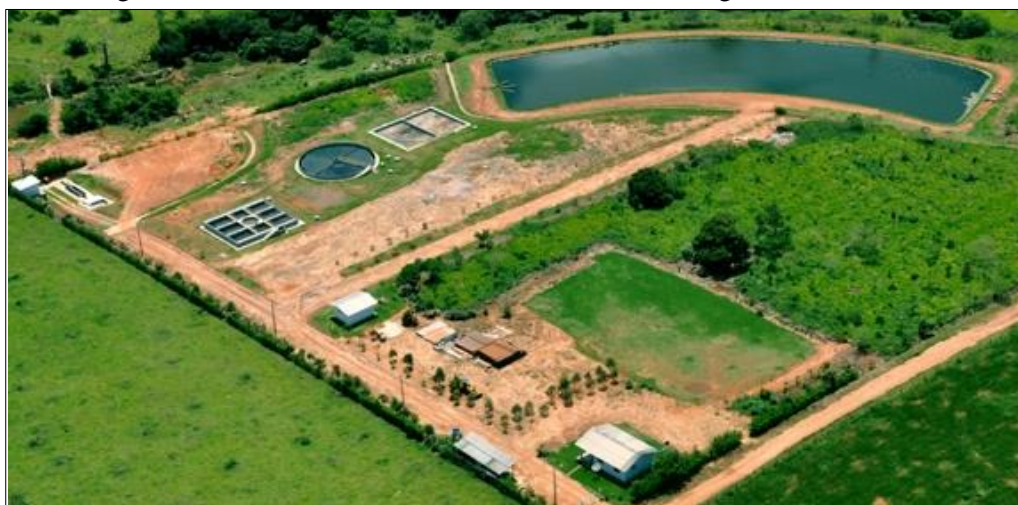
Figura 26. Vista aérea do sistema de tratamento de esgoto de Juara - MT
