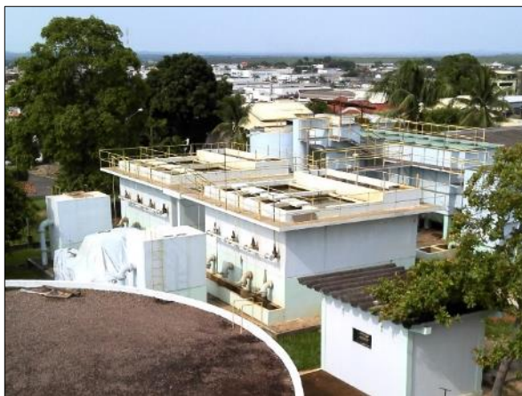
Figura 12. Vista das 2 ETAs de Concreto
