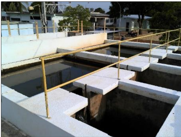
Figura 17. Vista da dos decantadores das ETAs de Concreto
