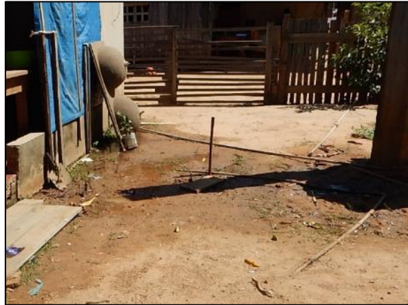
Figura 86. Vista exterior de fossa coberta com lona e terra (a) e fossa com suspiro (b), Paranorte, Juara-MT
