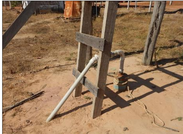
Figura 79. Vista da boca do poço tubular e cavalete P1, Paranorte, Juara-MT
