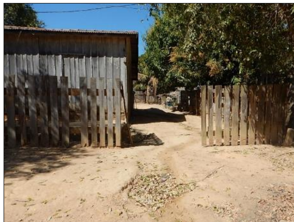
Figura 130. Disposição de efluente de pia e tanque a céu aberto, Projeto Casulo, Juara-MT
