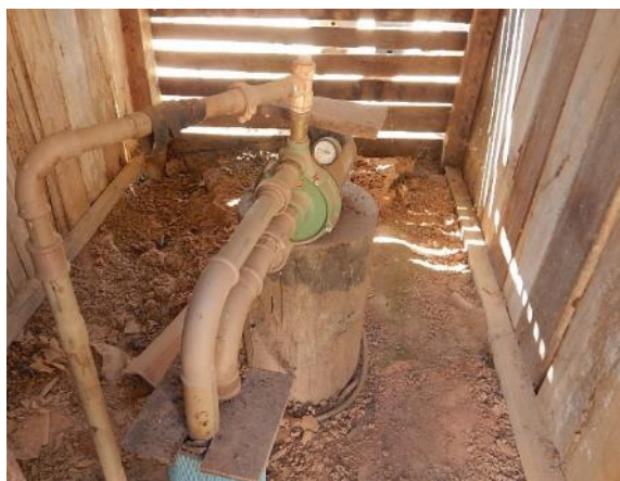
Figura 126. Vista da boa do poço tubular desativado e bomba de eixo horizontal, Projeto Casulo, Juara-MT
