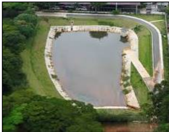
Figura 155. Bacia de detenção
