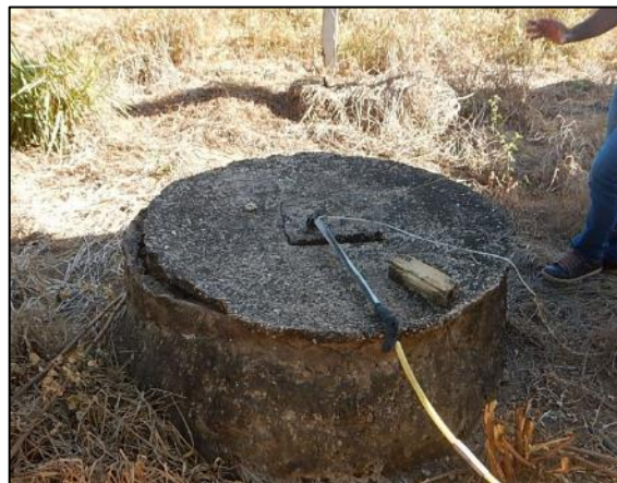
Figura 133. Poço Cacimba em área rural, Jaú, Juara-MT
