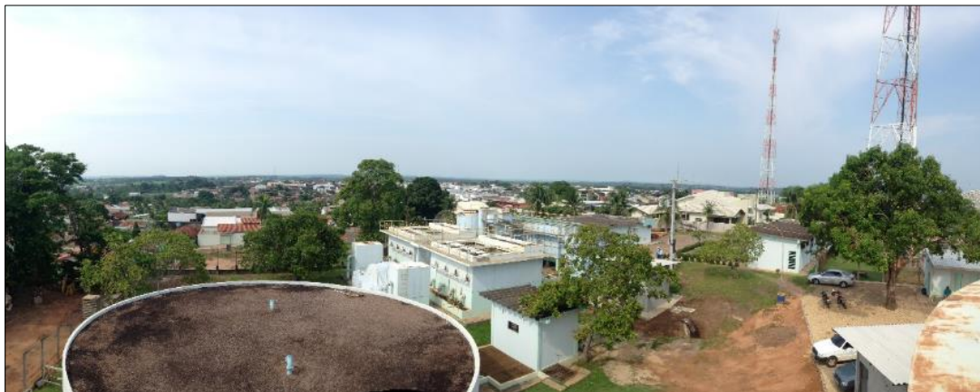
Figura 6. Vista panorâmica das estações de tratamento de água e reservatório da concessionária de água de Juara - MT
