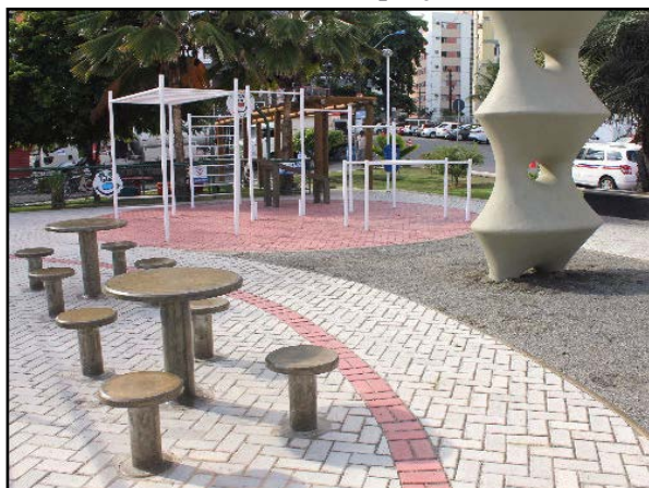
Figura 147. Pavimento poroso – piso intertravado instalado em praça
