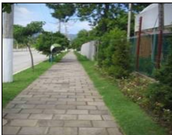
Figura 153. Vala de detenção ao longo da rua
