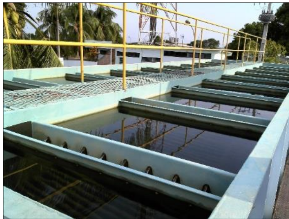
Figura 18. Vista do decantador da ETA metálica
