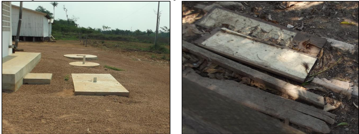
Figura 69. Vista exterior de fossa com suspiro (a e b), Vale do Amanhecer, Juruena-MT
