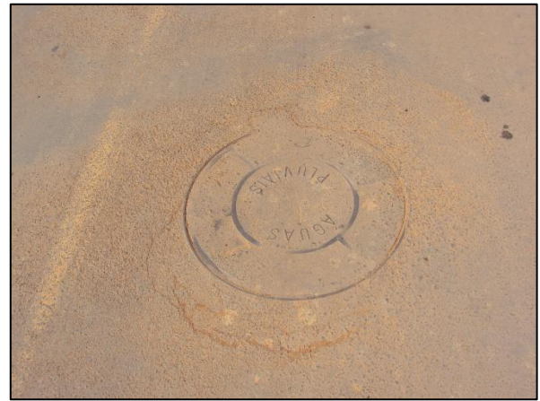
Figura 17. Boca de lobo dupla (a) e poço de visita (b), componentes da microdrenagem de Jurueña
