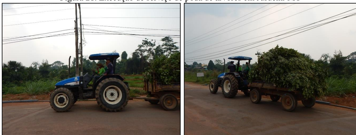
Figura 28. Execução de serviço de poda de árvores em Juruena-MT
