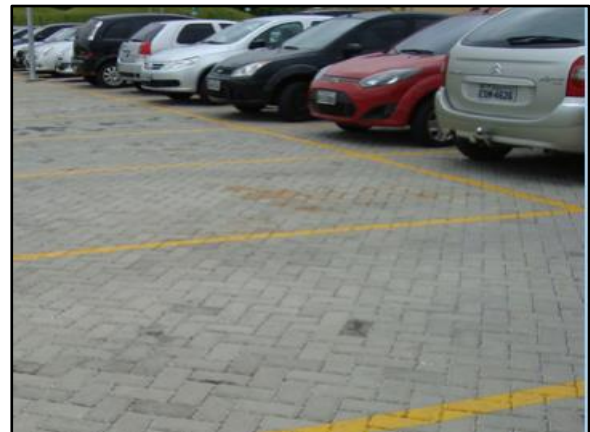
Figura 98. Pavimento poroso instalado em estacionamento
