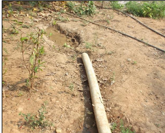
Figura 63. Disposição de efluente de pia e tanque a céu aberto, Santo Antônio, Juruena-MT.
