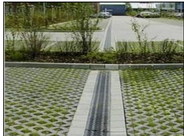
Figura 100. Trincheira de infiltração no estacionamento
