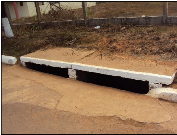
Figura 17. Boca de lobo dupla (a) e poço de visita (b), componentes da microdrenagem de Jurueña
