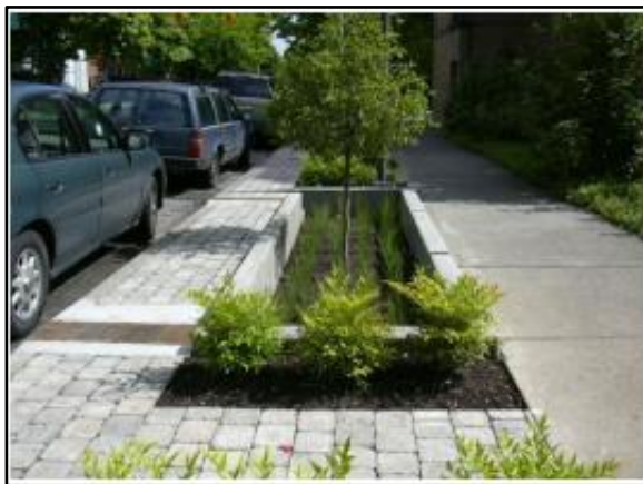
Figura 99. Trincheira de infiltração no passeio
