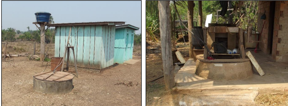
Figura 38. Vista exterior de poço freático (a e b), Somapar, Juruena-MT
