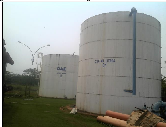
Figura 8. Reservatórios de água tratada em Jurueña-MT
