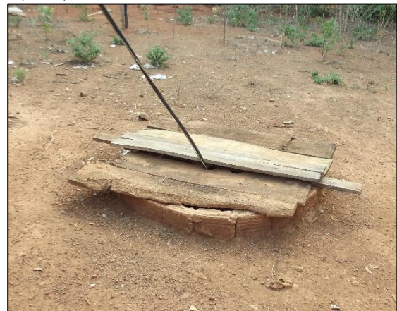
Figura 31. Vista da boca do poço freático (a e b), Chacareiros 2, Juruena-MT
