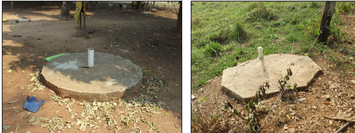
Figura 62. Vista exterior de fossa com suspiro (a e b), Santo Antônio , Juruena-MT
