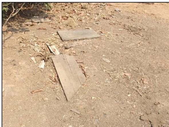
Figura 39. Vista exterior de fossa com cobertura de madeira, Somapar, Juruena-MT
