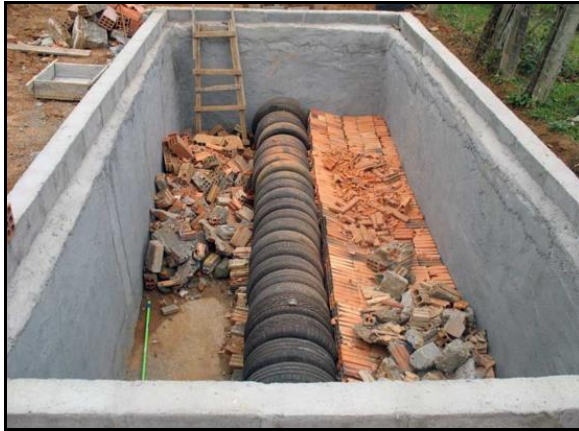
Figura 87. Método do círculo de bananeiras em execução para tratamento individual
