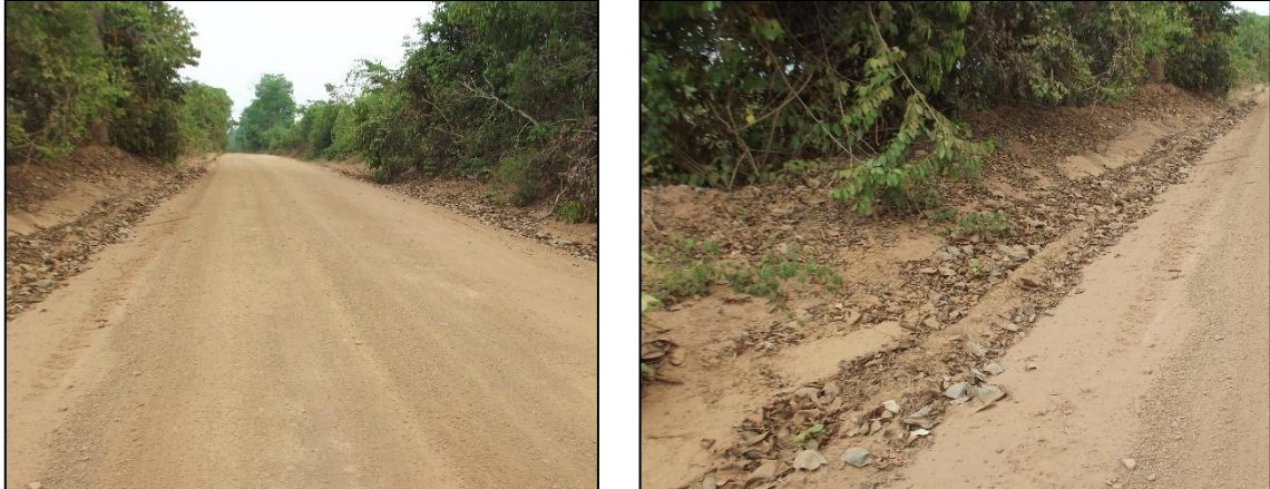
Figura 64. Via não pavimentada (a) e erosões em via não pavimentada, Santo Antônio, Jurueña-MT.
