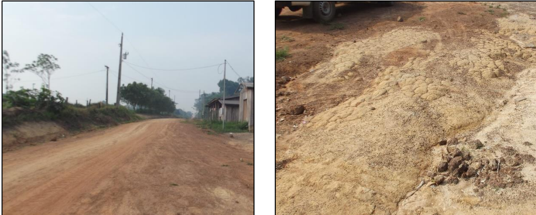
Figura 57. Via não pavimentada (a) e erosões em via não pavimentada, 13 de Maio, Juruena-MT
