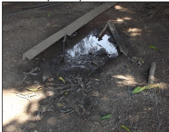
Figura 70. Disposição de efluente de pia e tanque a céu aberto, Vale do Amanhecer, Juruena-MT.
