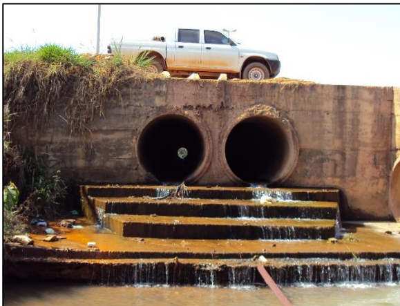
Figura 18. Bueiro duplo tubular de concreto seguido de dissipador de energia tipo degraus hidráulicos (a) e dissipador de energia tipo blocos (b) em Jurueña
