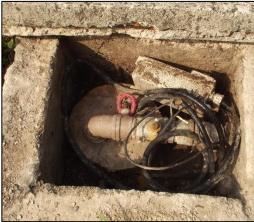
Figura 53. Vista da boca do poço tubular (a) e botão de acionamento (b), 13 de Maio, Juruena-MT
