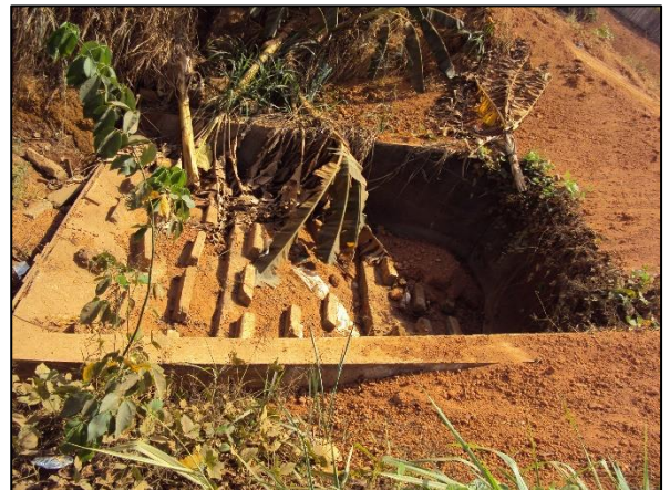
Figura 18. Bueiro duplo tubular de concreto seguido de dissipador de energia tipo degraus hidráulicos (a) e dissipador de energia tipo blocos (b) em Jurueña
