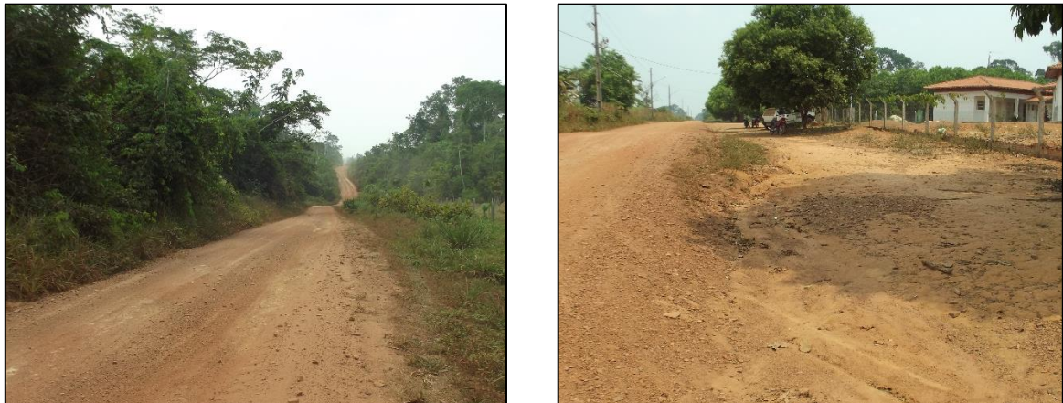
Figura 71. Via não pavimentada (a) e erosões em via não pavimentada, Vale do Amanhecer, Juruena-MT
