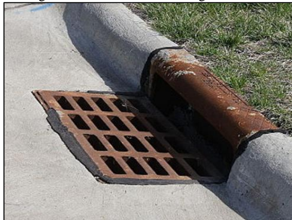
Figura 85. Boca de lobo com gradeamento
