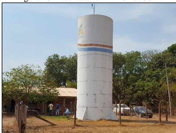
Figura 18. Reservatório RAP-01 de 90 m 3
