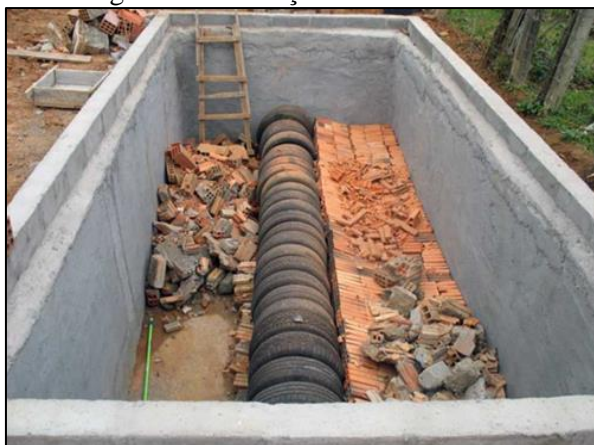
Figura 80. Execução fossa bananeira
