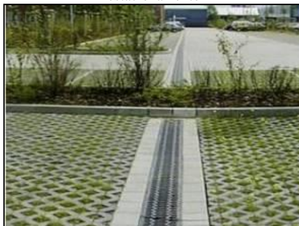
Figura 93. Trincheira de infiltração no estacionamento
