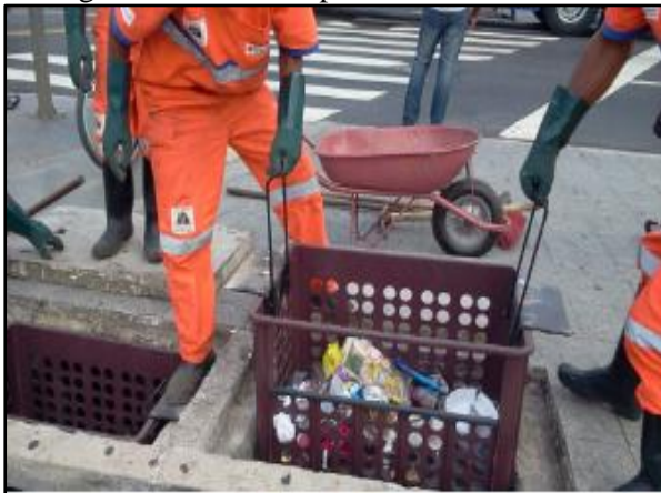
Figura 84. Cesta acoplada a boca do bueiro
