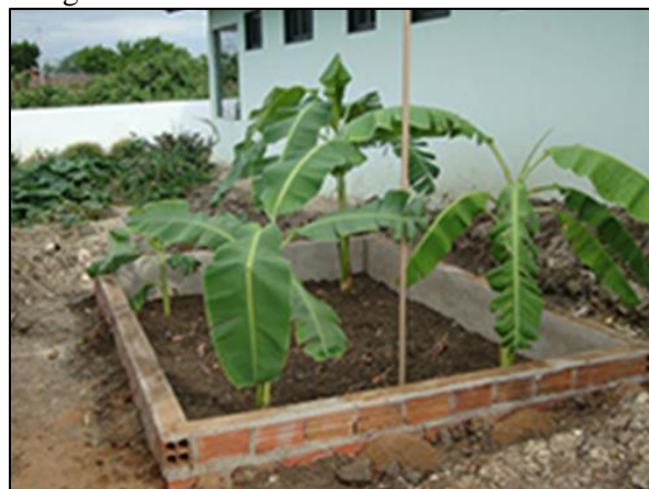
Figura 81. Fossa bananeira em funcionamento
