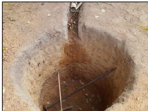
Figura 62. Fossa rudimentar na comunidade São Bento
