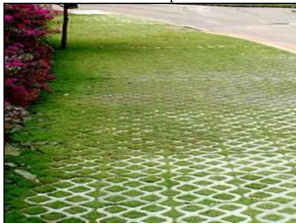
Figura 89. Pavimento poroso – concregrama instalado em passeio
