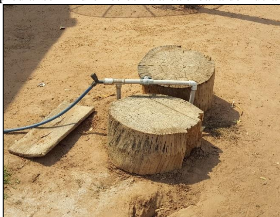
Figura 19. Cavaletes de entrada de uma ligação predial sem hidrômetros na área urbana de Luciara
