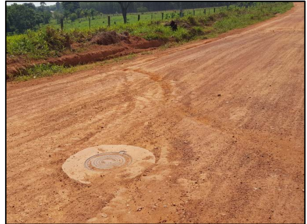
Figura 51. Galeria de águas pluviais executada na Av. Peninsular anterior a pavimentação
