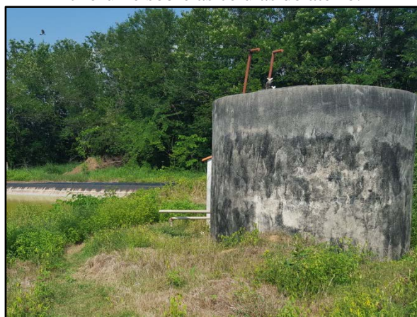
Figura 74. Tanque para sucção e recirculação do chorume sobre as células do aterro.
