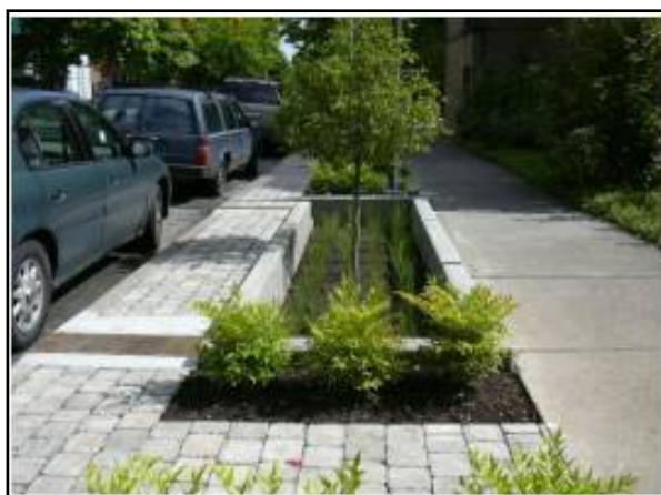
Figura 164. Trincheira de infiltração no passeio
