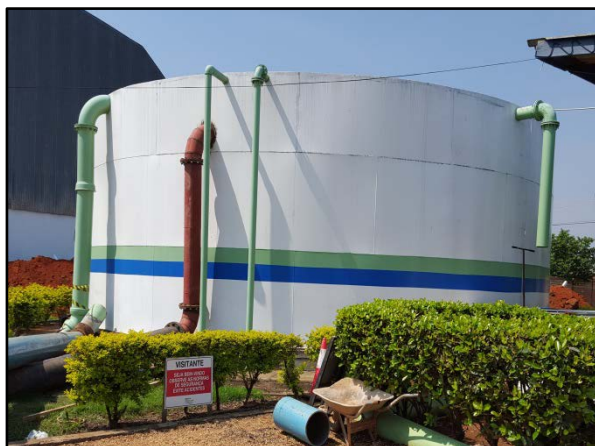
Figura 34. Reservatório RAP-1 de 500,0 m 3 na área da ETA
