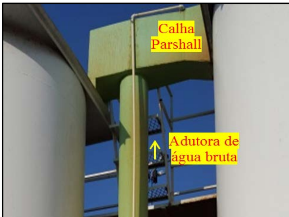
Figura 25. Entrada da água bruta na calha Parshall
