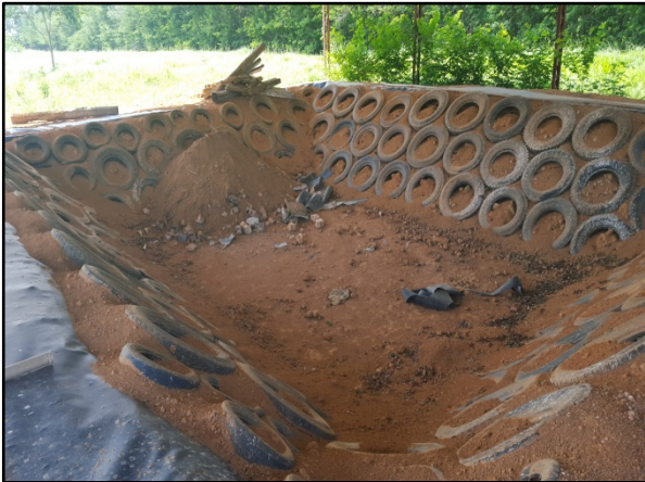
Figura 75. Vala impermeabilizada para recebimento de resíduos do serviço de saúde de Matupá-MT
