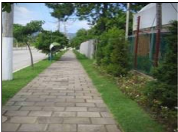
Figura 166. Vala de detenção ao longo da rua
