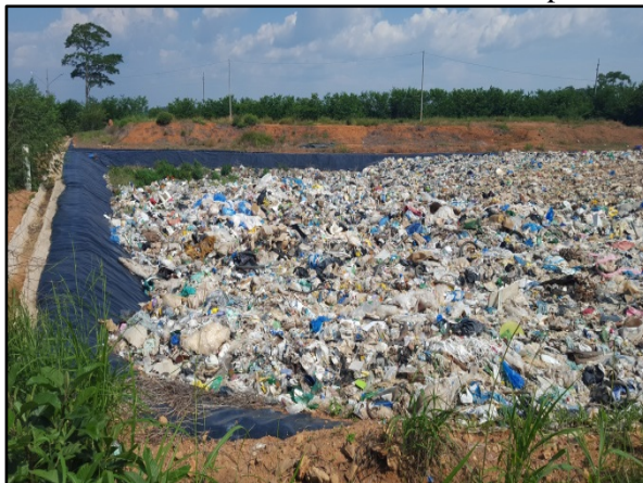
Figura 68. Resíduos sólidos comuns dispostos sobre a manta sintética no aterro de Matupá-MT
