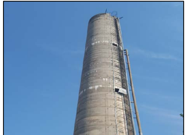
Figura 11. Reservatório de concreto apoiado inativo
