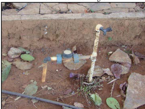
Figura 115. Hidrômetro em uma ligação predial no distrito Alto Alegre
