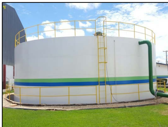
Figura 35. Reservatório RAP-2 de 1.000,0 m 3 na área da ETA
