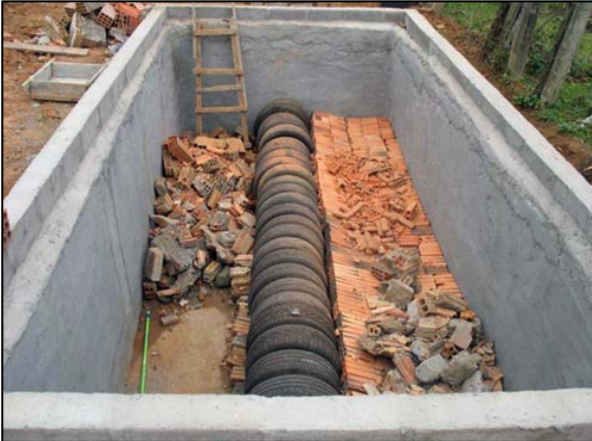
Figura 152. Execução fossa bananeira
