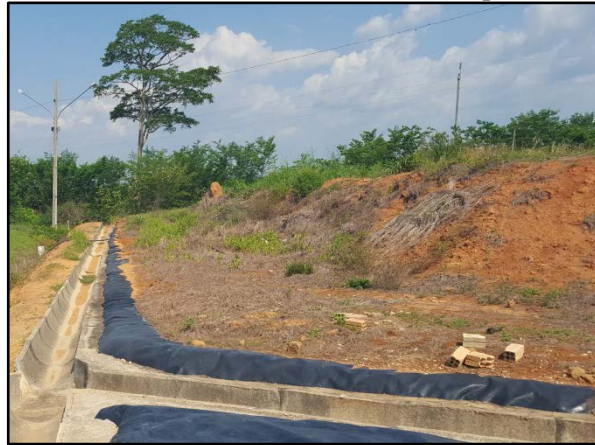
Figura 71. Cobertura final sobre a célula concluída no aterro sanitário de Matupá-MT
