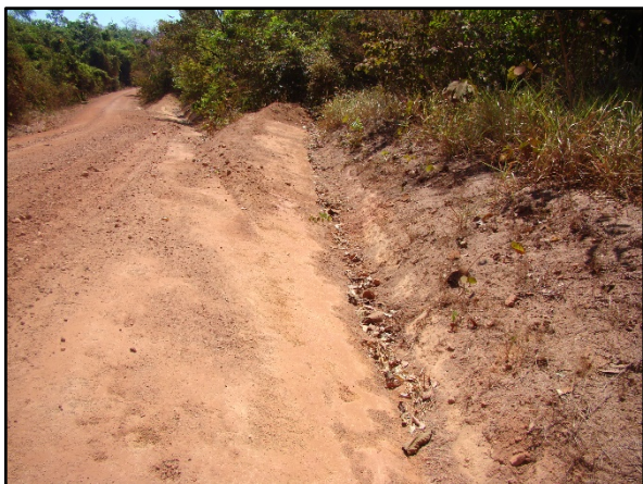
Figura 130. Dispositivos de drenagem executados na estrada vicinal de acesso à comunidade Santo Antônio
