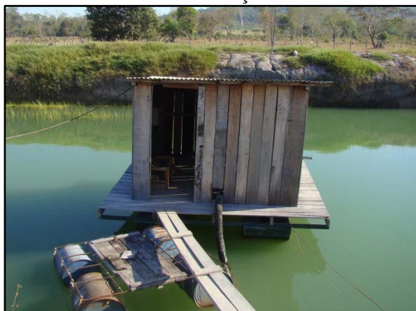
Figura 117. Abrigo da captação sobre balsa flutuante no açude
