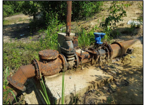
Figura 20. Válvula de retenção, registro de gaveta para descarga, ventosa e redução na adutora de água bruta
