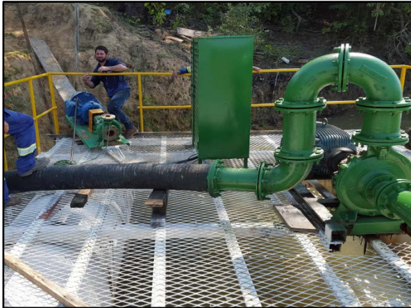
Figura 19. Conexão entre tubulação de ferro fundido e mangote flexível na captação
