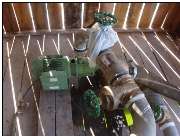
Figura 118. Conjunto motobomba de captação da Comunidade de Santo Antônio
