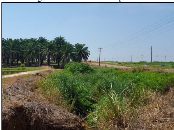
Figura 54. Erosão formada entre a BR-163 e o lago na Zona de Preservação 001
