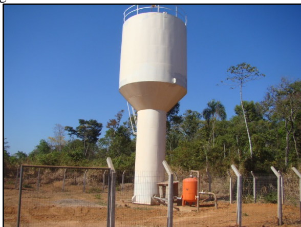
Figura 124. Reservatório da comunidade Santo Antônio
