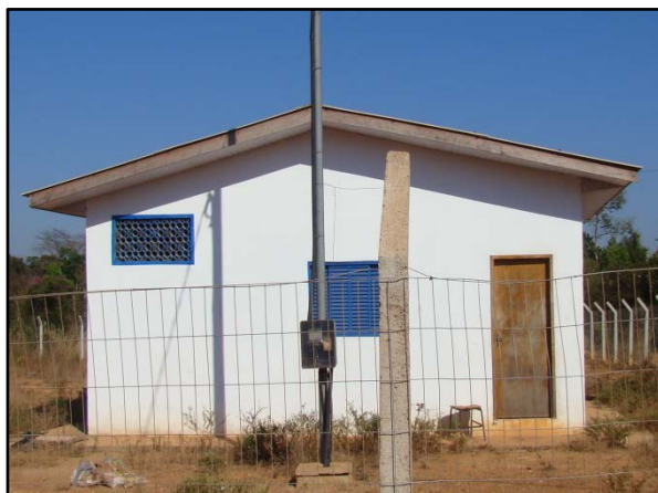
Figura 122. Casa de química inoperante na comunidade Santo Antônio
