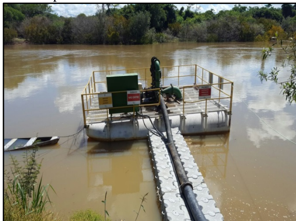
Figura 14. Balsa com grade na captação superficial no rio Peixoto de Azevedo
