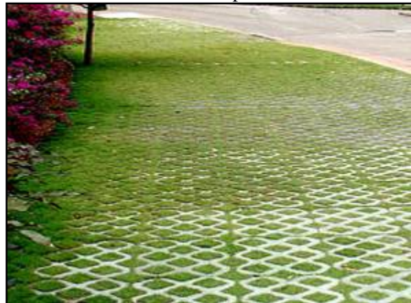
Figura 161. Pavimento poroso – concregrama instalado em passeio
