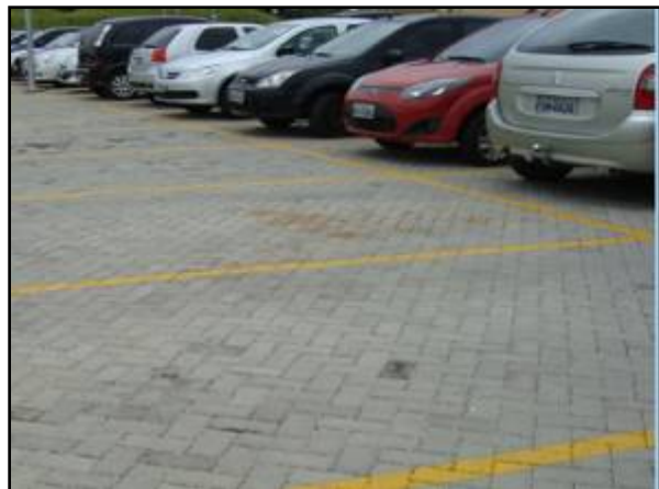
Figura 163. Pavimento poroso instalado em estacionamento
