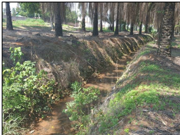
Figura 52. Canal de drenagem paralelo à Av. Irmã Adélis
