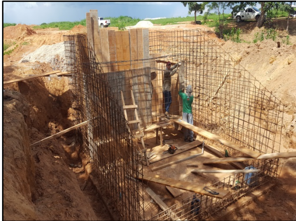
Figura 50. Dissipador de energia em construção no bairro ZC1-002
