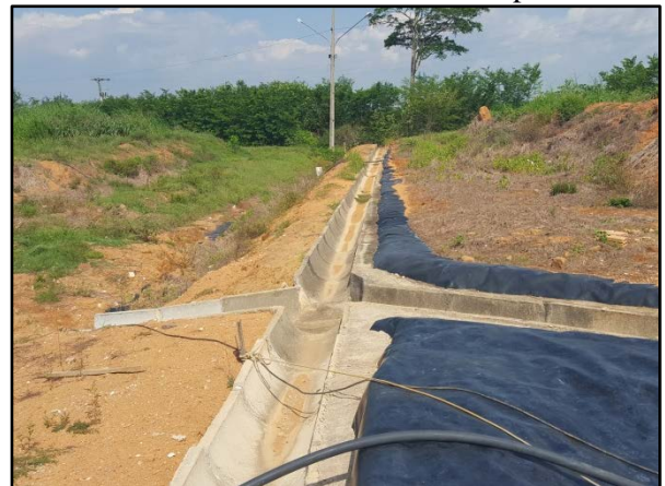
Figura 69. Canaletas executadas ao redor das células do aterro sanitário de Matupá-MT
