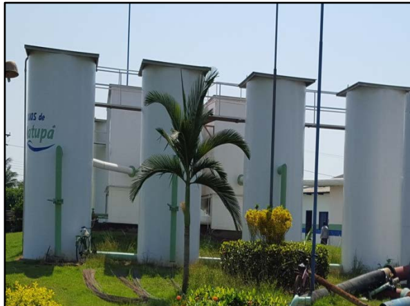
Figura 29. Filtros de múltiplas camadas com fluxo descendentes
