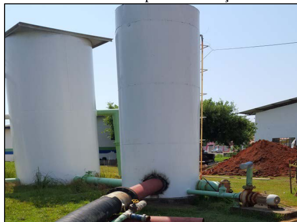
Figura 31. Câmara de contato para desinfecção na área da ETA
