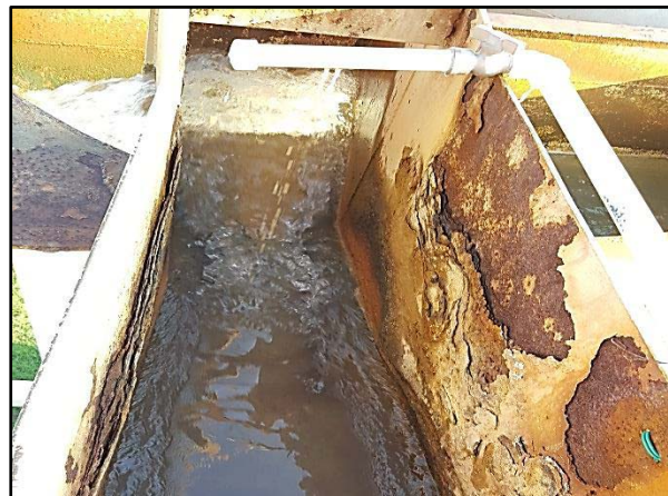
Figura 26. Aplicação da solução de sulfato de alumínio na calha Parshall
