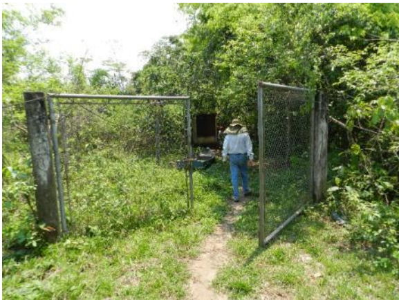
Figura 81 – Entrada da captação
