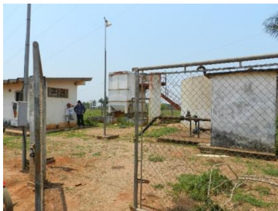
Figura 92 – Vista geral da ETA
