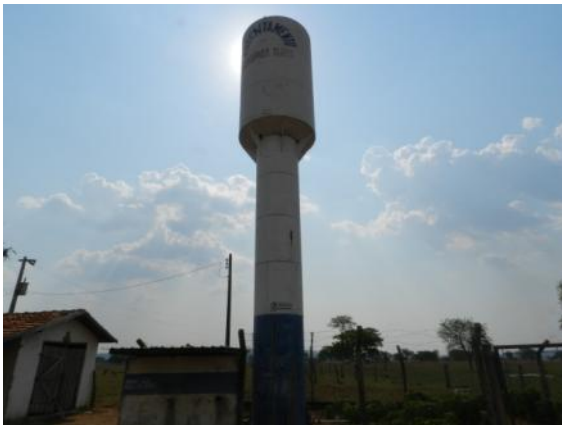
Figura 69 – reservatório 60m 3
