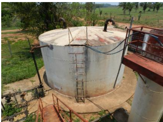
Figura 91 – Reservatório de 30m 3
