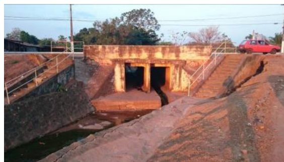
Figura 110 – descida d'água junto a sargeta.
