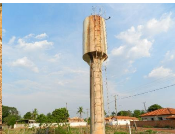
Figura 53 – Reservatório 8m 3
