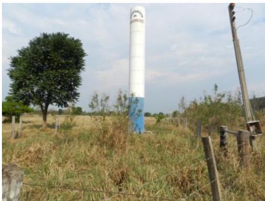
Figura 71– reservatório 60m³
