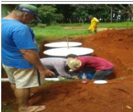
Figura 103 – Instalação da biofossa zona rural
