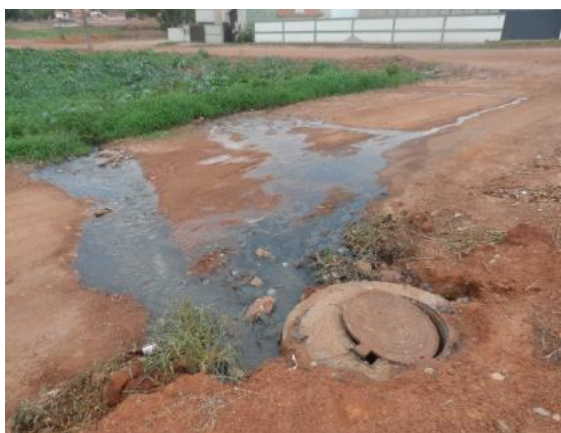
Figura 99 – PV danificado na estrutura
