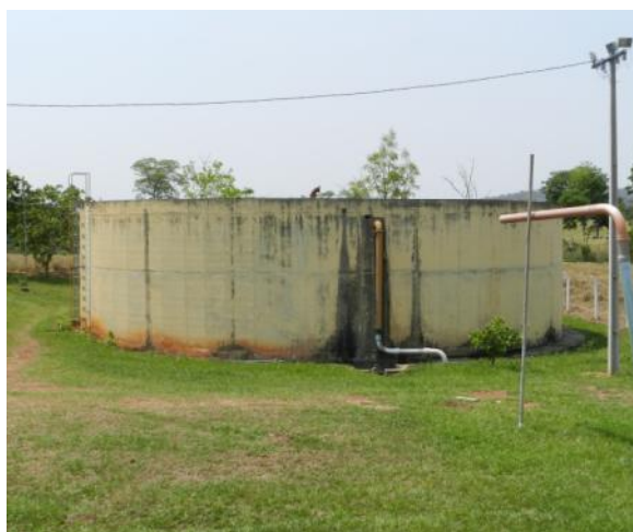
Figura 48 – Reservatório 1 (ETA) - concreto apoiado.
