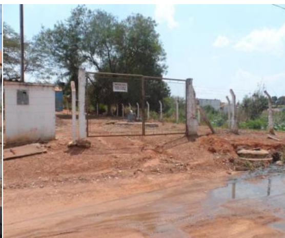
Figura 96 – Elevatória 12 de Outubro
