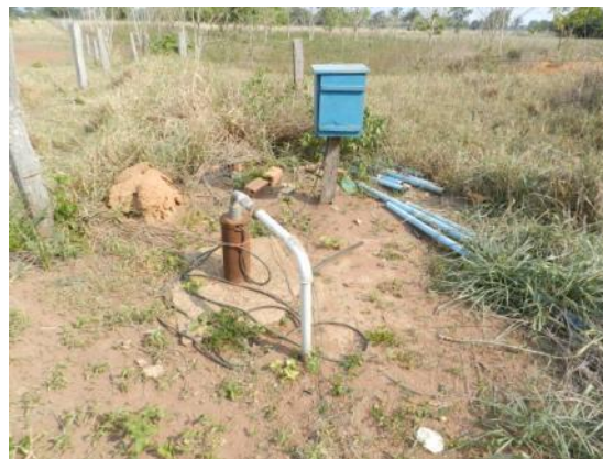
Figura 72 – poço tubular
