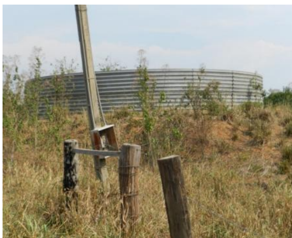
Figura 73 – reservatório utilizado para irrigação e dessedentação de animais
