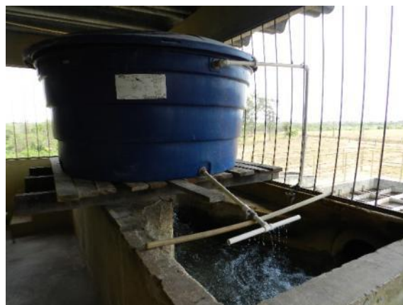
Figura 47 – Dosador de sulfato de alumínio
