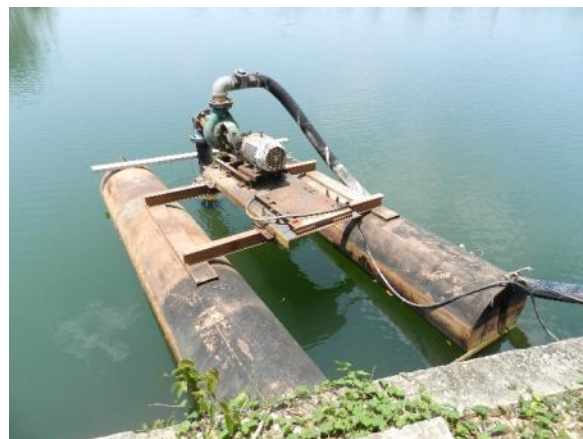
Figura 36– Bombeamento Represa do SIGLA
