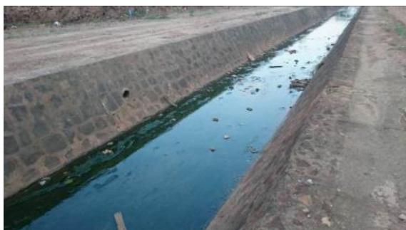
Figura 109 – Canalização do Córrego André.
