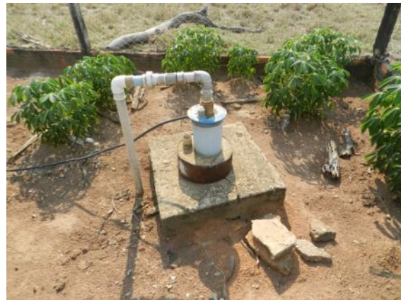
Figura 70 – poço tubular
