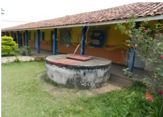
Figura 56 – Cisterna da escola
