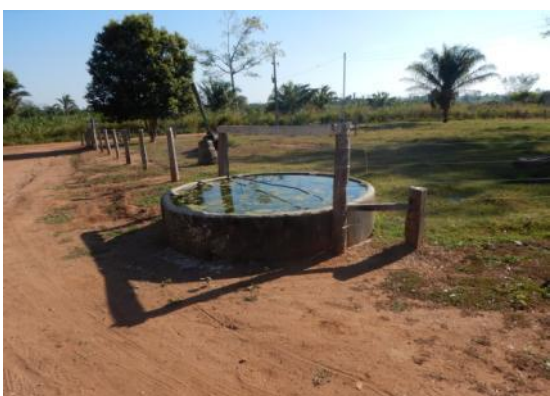
Figura 64 – Poço 1 e reservatório 1, ao lado da igreja católica
