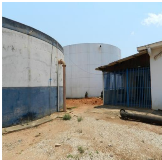
Figura 51 – Reservatórios localizados na Praça São Paulo
