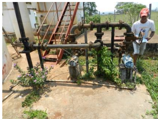
Figura 88 – Pressurizadora desativada
