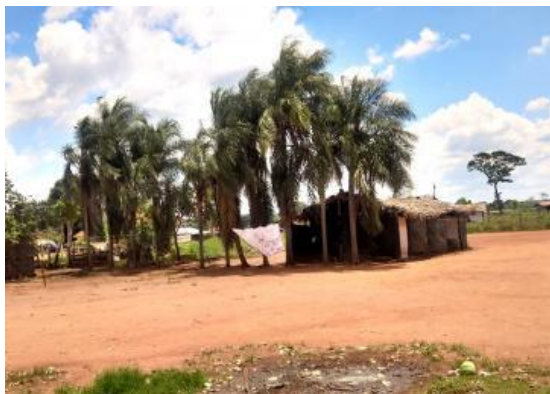
Figura 58 – Condições precárias de moradia
