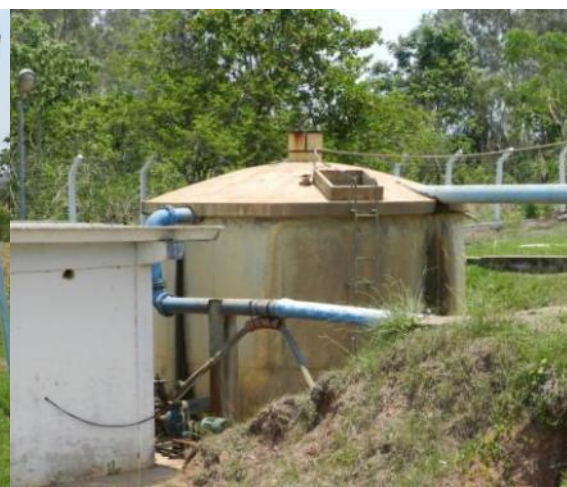
Figura 49 – Reservatório 250m 3 (ETA) - concreto apoiado
