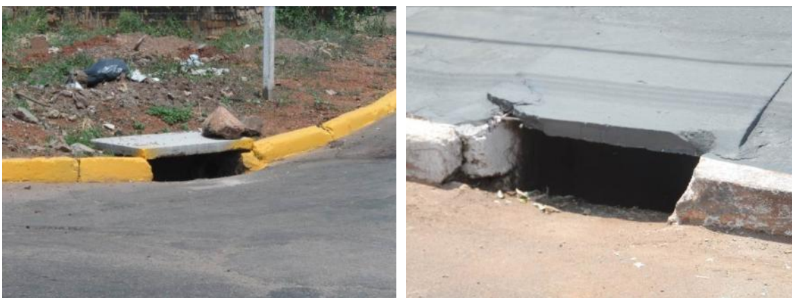
Figura 106 – Bocas de lobo.
