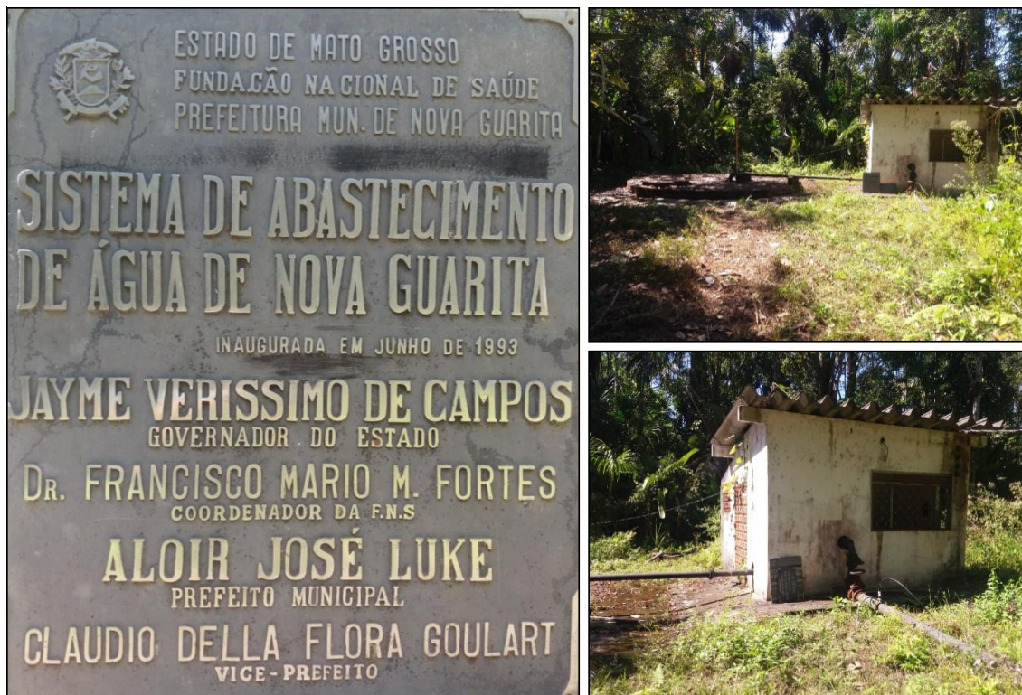
Figura 14: Ponto de captação de água antigo (Bolivar) Coordenadas Lat. 10°18'33,519" S Long. 55°23'14,819" O.
