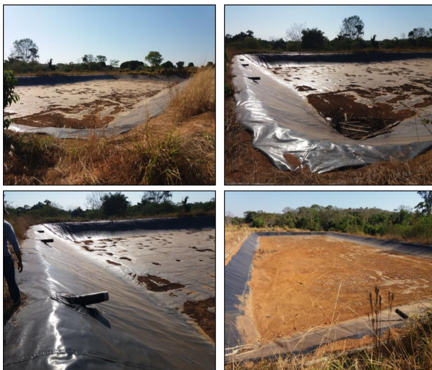
Figura 44: Lagoas de estabilização de Nova Guarita.
