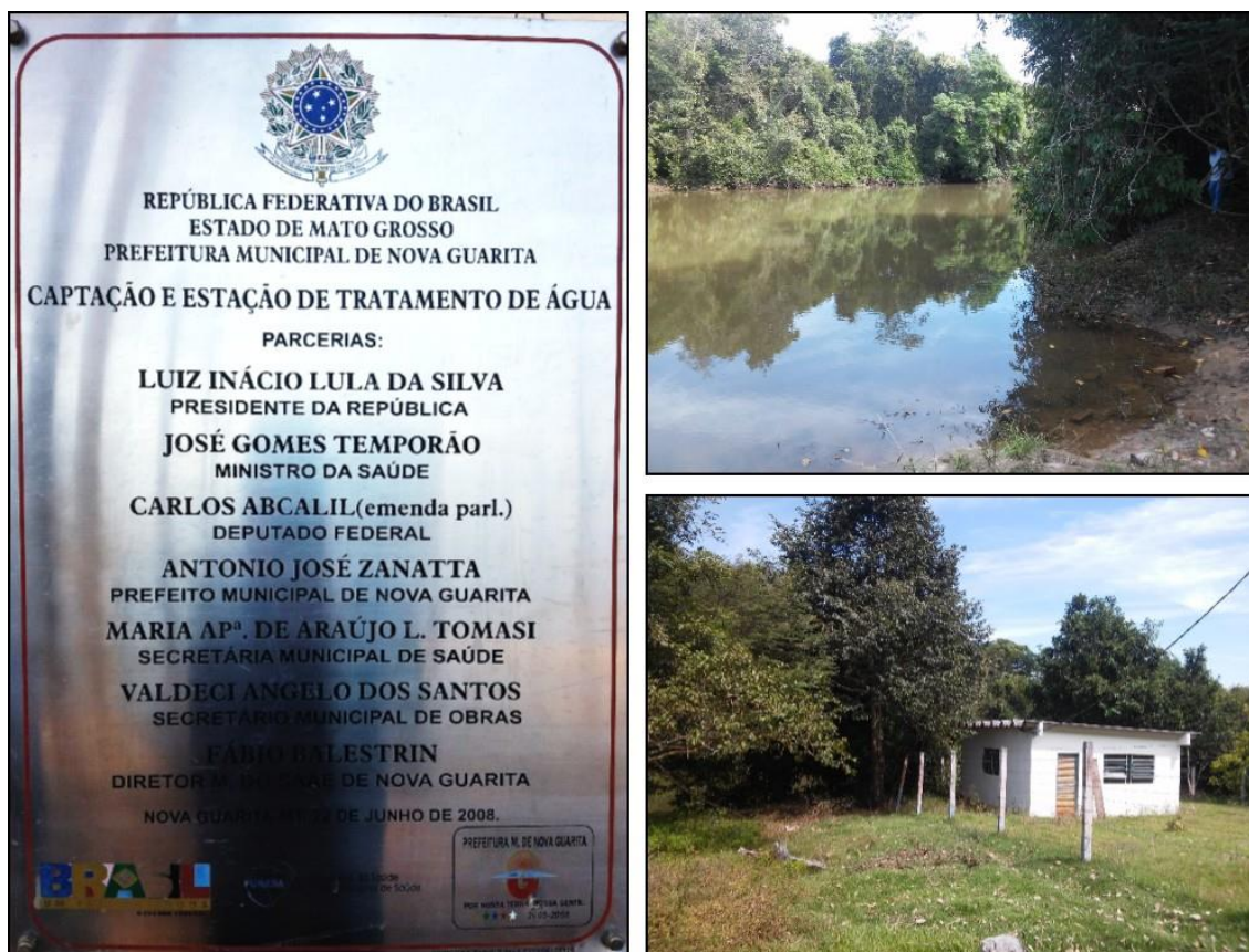
Figura 17: Ponto de captação novo. Coordenadas Lat. 10°20'15,30" S Long. 55°27'18,54" O.
