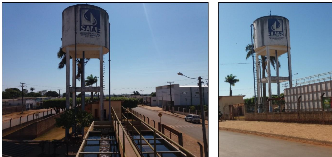
Figura 30: Reservatório de água tratada. Capacidade de armazenamento de 100 m 3 .
