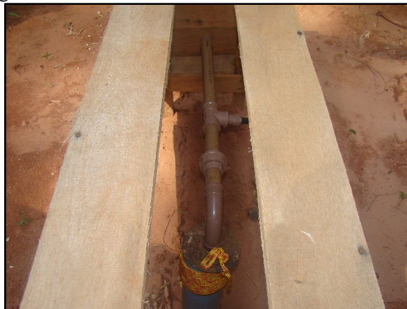
Figura 16. Estrutura do PT 08 da escola Wilson Ribeiro
