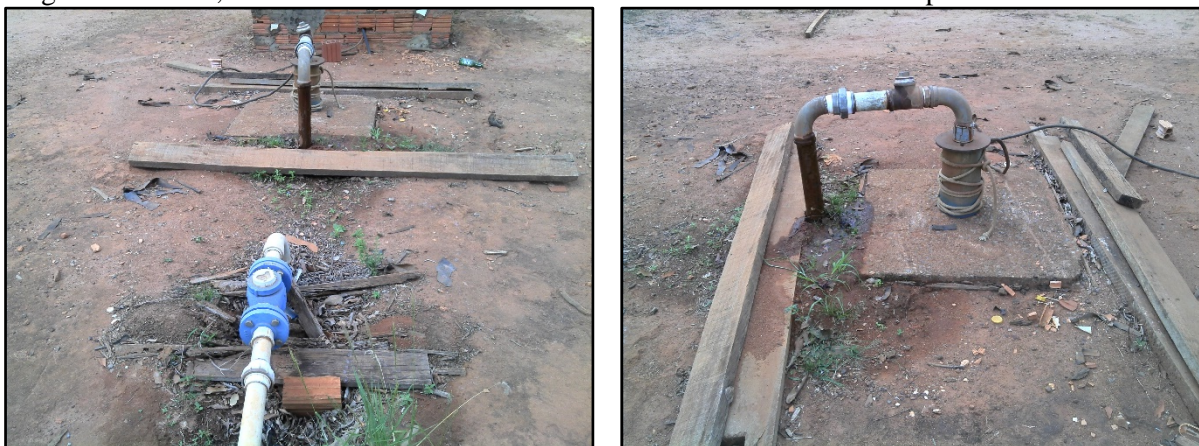
Figura 59. PT 01, localizado no fundo da Escola Estadual do Distrito com dispositivo macromedidor
