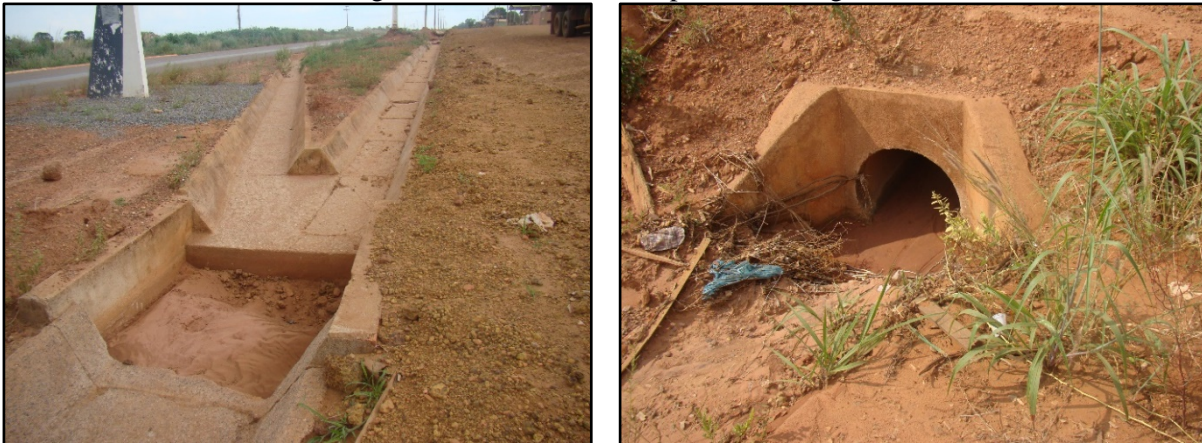
Figura 35. Escadaria e dissipador de energia
