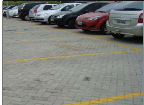
Figura 92. Pavimento poroso instalado em estacionamento
