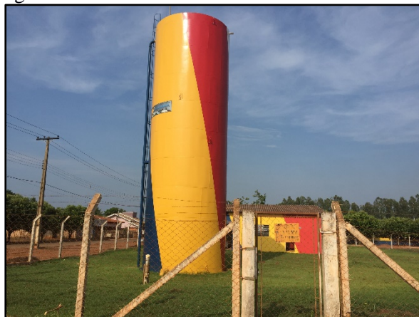
Figura 23. Reservatório elevado metálico de 100 m 3
