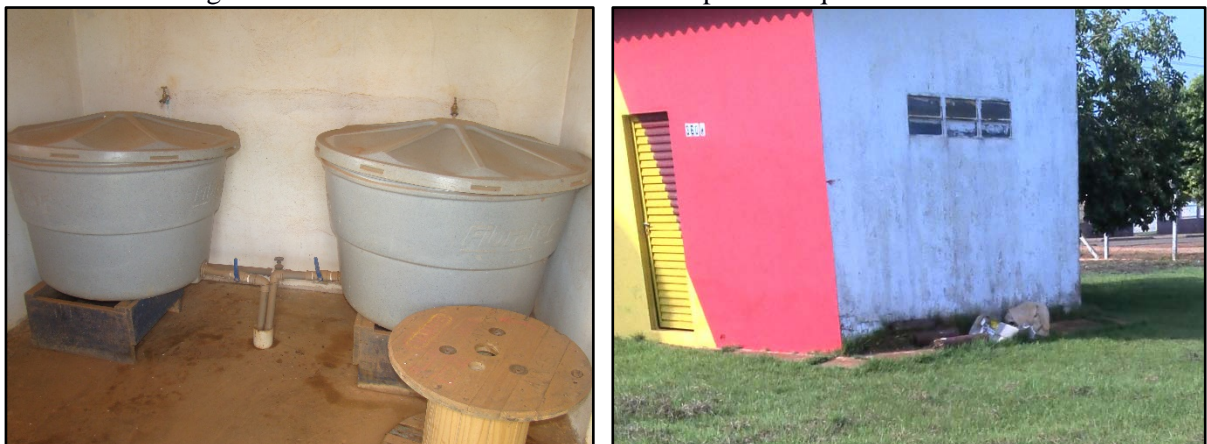
Figura 21. Estrutura de alvenaria da casa de produtos químicos do PT01
