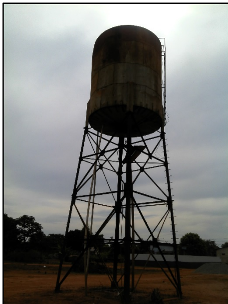
Figura 60. Reservatório elevado metálico de 15 m 3
