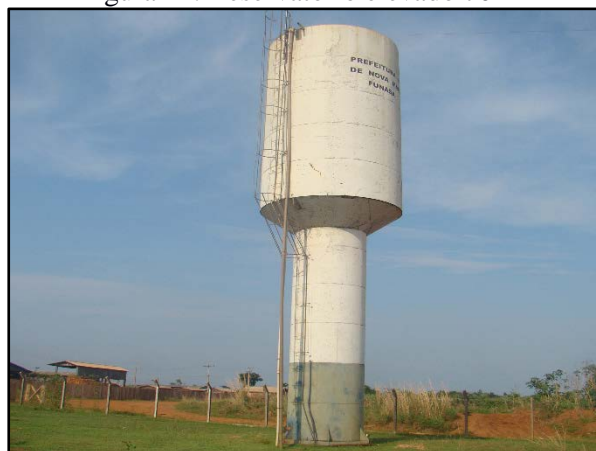
Figura 24. Reservatório elevado 70 m 3
