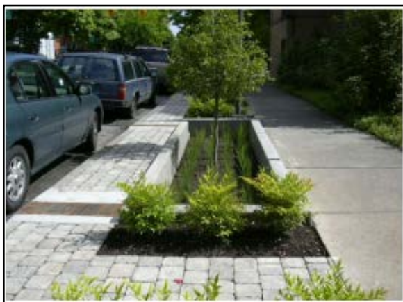
Figura 93. Trincheira de infiltração no passeio
