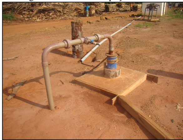
Figura 10. Estrutura do poço tubular 02
