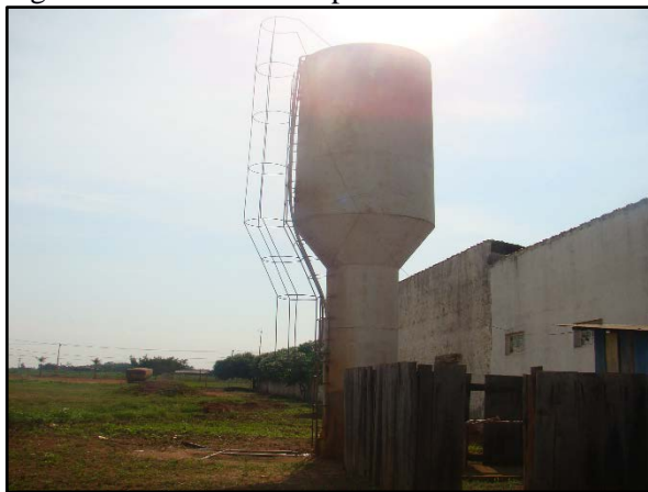
Figura 25. Reservatório apoiado metálico de 20 m 3
