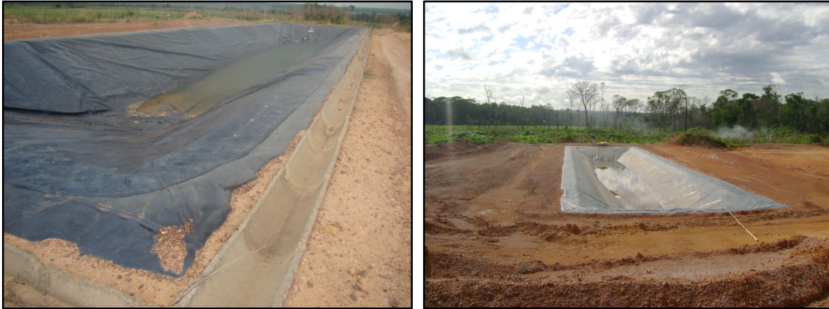
Figura 46. Situação Atual da Vala de resíduos comuns
