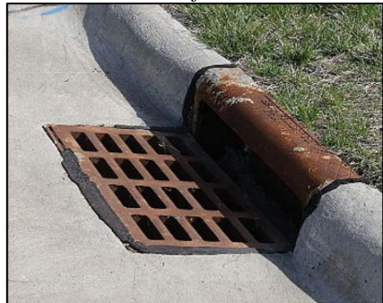
Figura 86. Boca de lobo com gradeamento na sarjeta
