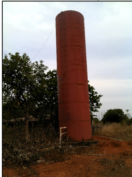
Figura 62. Reservatório elevado tipo torre de 20 m 3
