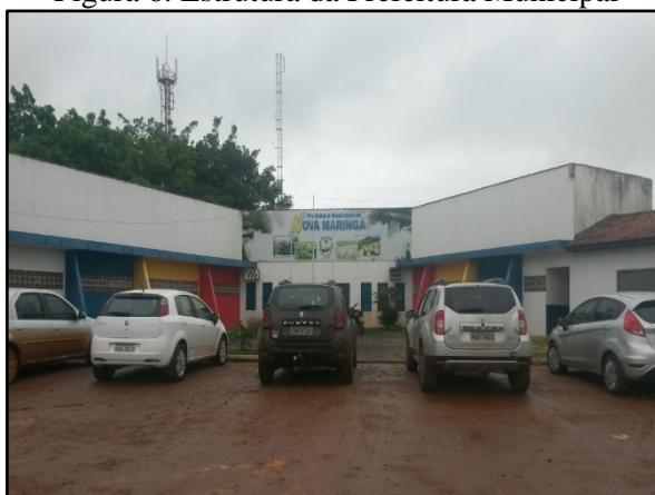
Figura 6. Estrutura da Prefeitura Municipal
