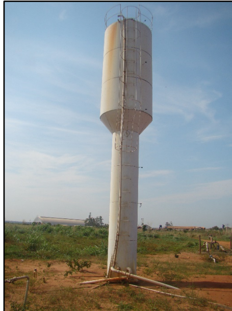
Figura 28. Reservatório elevado metálico de 15 m 3
