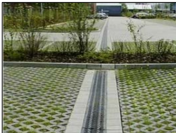
Figura 94. Trincheira de infiltração no estacionamento
