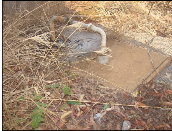
Figura 15. Estrutura do Poço Tubular 07
