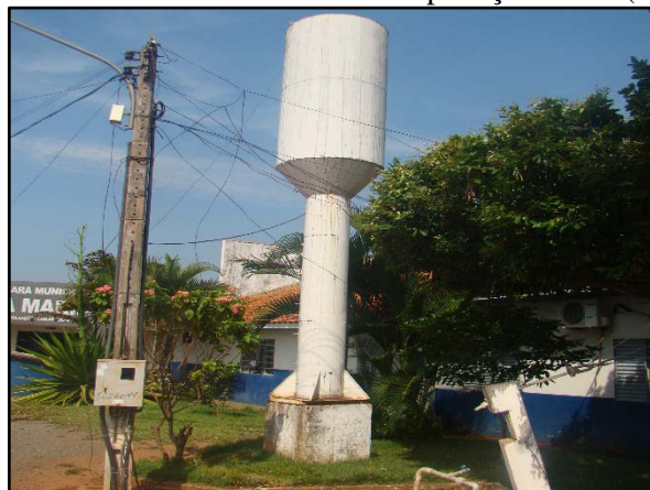
Figura 29. Reservatório 07 elevado tipo taça de 7m 3 (PT 11)
