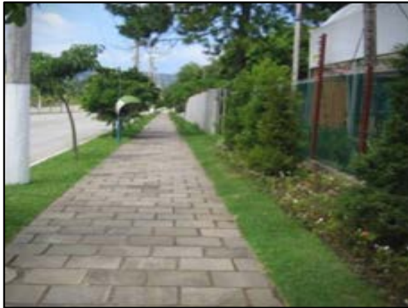
Figura 95. Vala de retenção ao longo da rua
