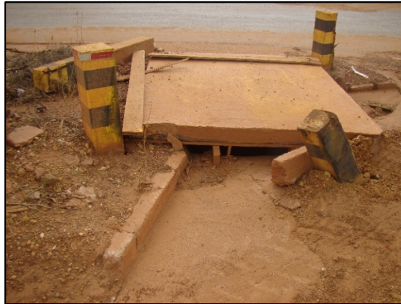
Figura 34. Boca de lobo na Av. Amos Bernardino Zanchet, Centro
