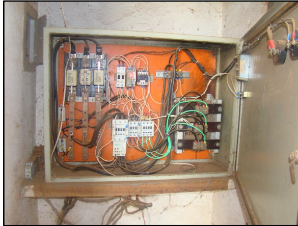
Figura 20. Quadro de comando instalado no PT 01 de acionamento manual
