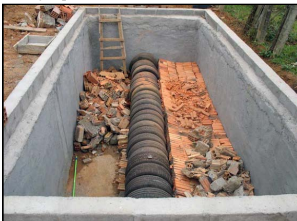
Figura 81. Método do círculo de bananeiras em execução para tratamento individual
