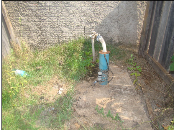
Figura 18. Estrutura atual do PT 10 Creche Rosa Camacho
