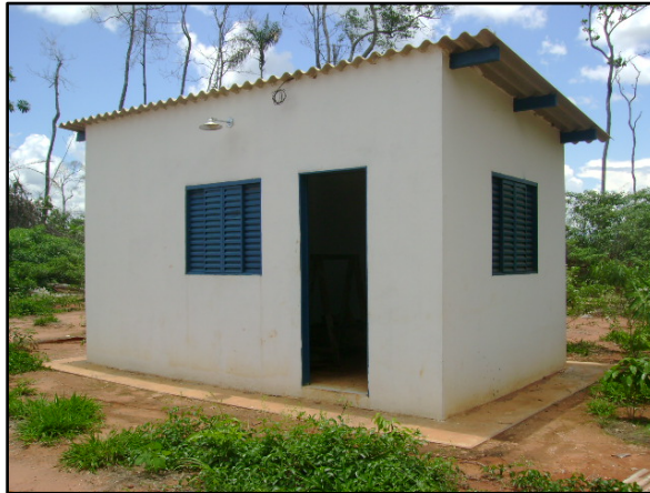
Figura 45. Guarita em alvenaria do Aterro Sanitário instalado
