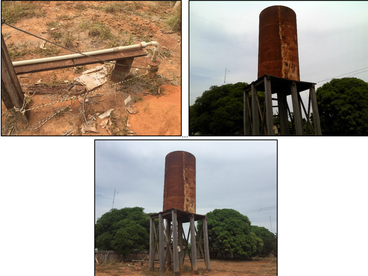
Figura 63. PT 03 com reservatório de 10 m 3 ao lado
