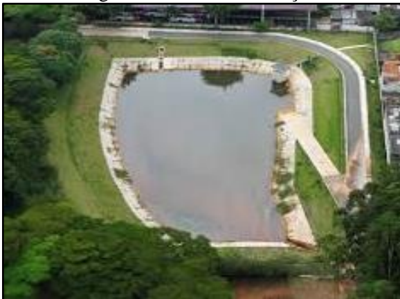
Figura 82. Bacia de detenção
