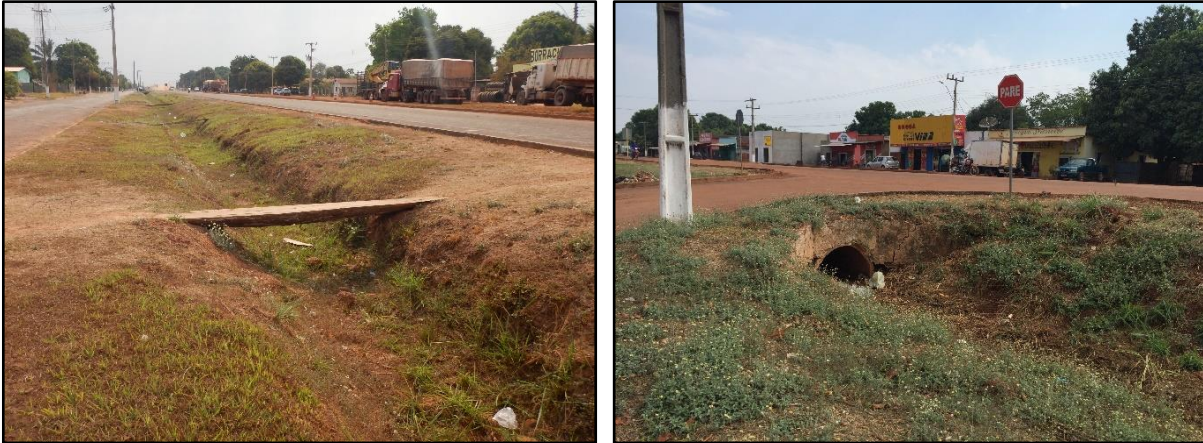
Figura 32. Canal escavado em Nova Nazaré
