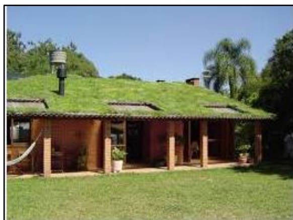
Figura 73. Telhado verde com plantas
