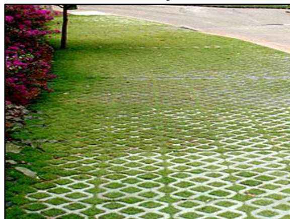
Figura 75. Pavimento poroso – concregrama instalado em passeio
