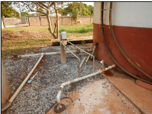
Figura 10. a) PT-01 b) PT-02 com dispositivo de macromedição
