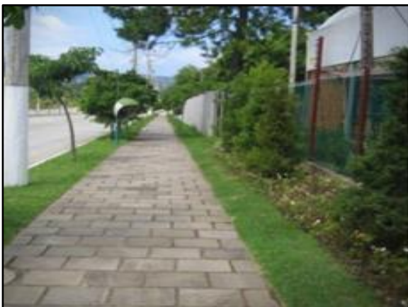
Figura 80. Vala de detenção ao longo da rua
