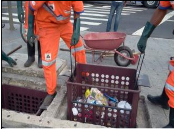
Figura 70. Cesta acoplada à boca do bueiro
