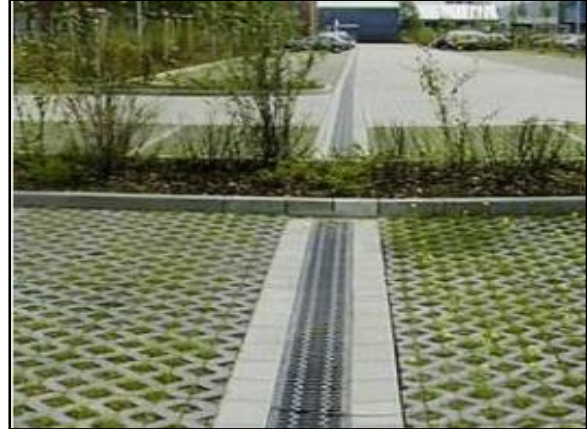
Figura 79. Trincheira de infiltração no estacionamento
