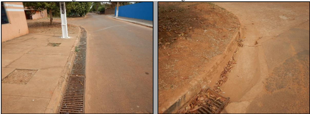
Figura 34. Dispositivos de microdrenagem de Nova Nazaré
