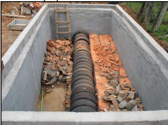
Figura 66. Método do círculo de bananeiras em execução para tratamento individual
