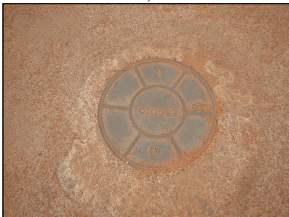
Figura 26. Poços de visita da rede coletora de esgoto (a); fossa instalada na calçada (b)
