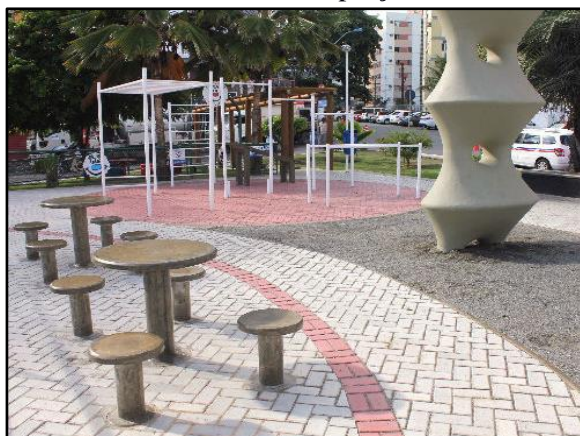
Figura 74. Pavimento poroso – piso intertravado instalado em praça
