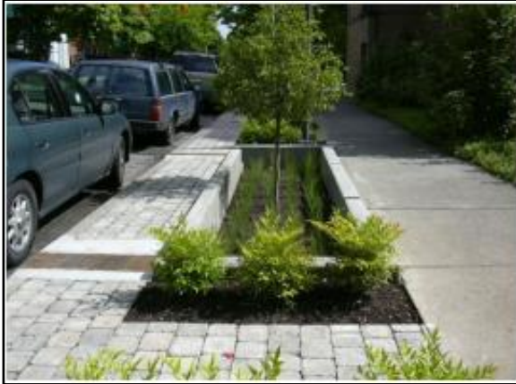
Figura 78. Trincheira de infiltração no passeio
