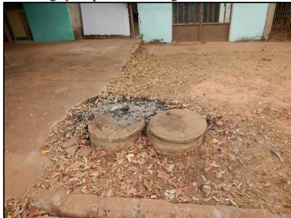
Figura 27. Ligações prediais de esgoto em Nova Nazaré-MT
