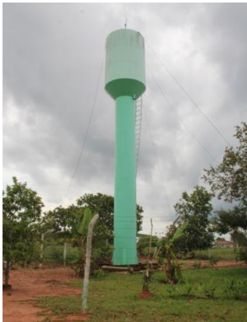
Figura 80: Reservatório Santo Antônio.
