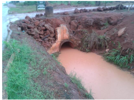
Figuras 102 a 107: Imagens de bueiros, da descarga e do canal a céu aberto existentes nas margens da BR-242.
