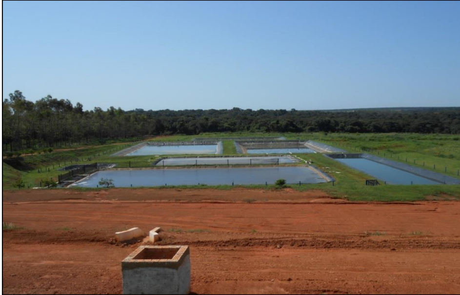
Figura 126: Imagem das lagoas de tratamento do chorume.
