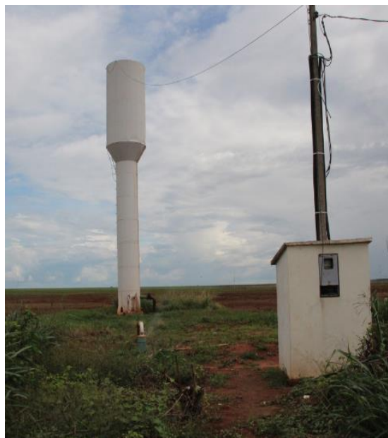
Figura 83: Reservatório II Água Limpa.
