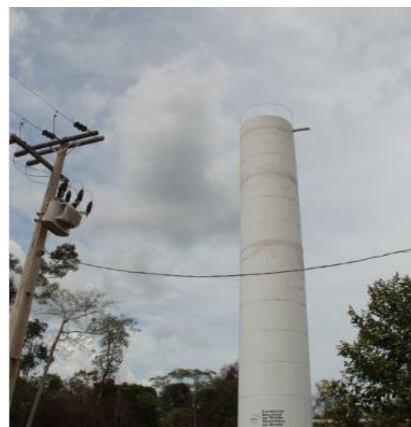
Figura 77: Reservatório Entre Rios.
