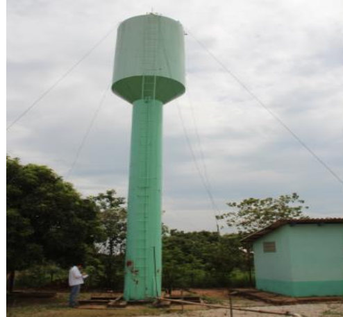
Figura 79: Reservatório Novo Mato Grosso.
