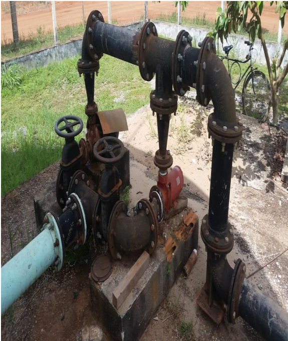
Figura 64: Poço I - Sede do município.
