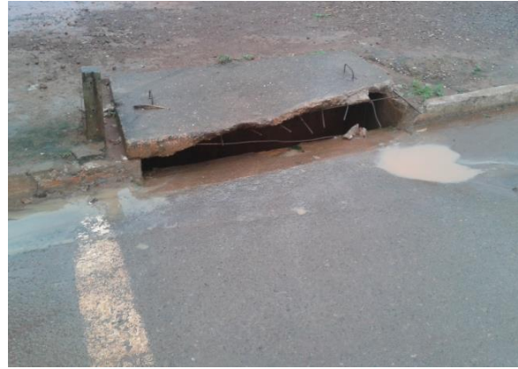
Figuras 100 e 101: Imagens de bocas de lobo simples executadas nas Ruas e Avenidas da cidade.
