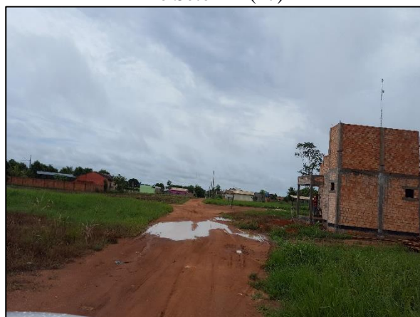
Figura 45. Ponto de alagamento na rua Pequizeiro no Setor III (17)
