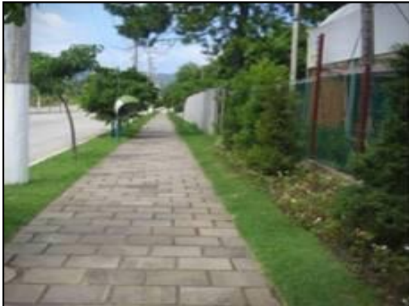
Figura 114. Vala de detenção ao longo da rua
