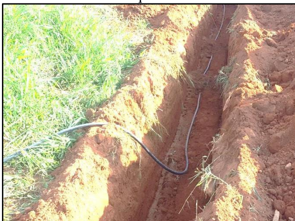
Figura 20. Extensão da rede de distribuição de PEAD de 25 mm em implantação na Rua Jequitibá
