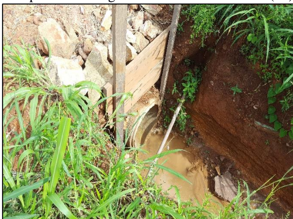
Figura 42. Desague da galeria pluvial sem dissipador de energia na Trav. Alves da Silva (21)
