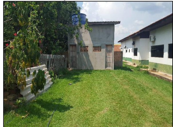
Figura 63. Fachada do abrigo de resíduos de serviço de saúde da USF
