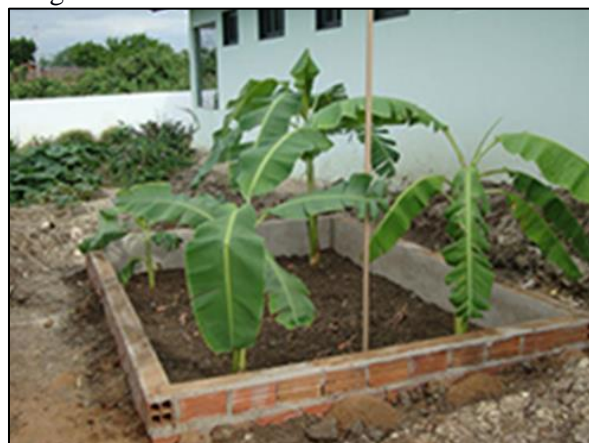
Figura 101. Fossa bananeira em funcionamento
