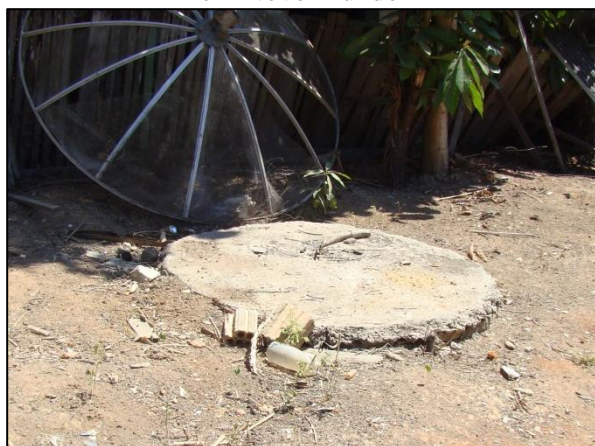
Figura 79. Fossa absorvente na comunidade Cinco Mil em Novo Mundo-MT
