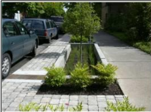
Figura 112. Trincheira de infiltração no passeio
