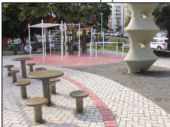
Figura 108. Pavimento poroso – piso intertravado instalado em praça
