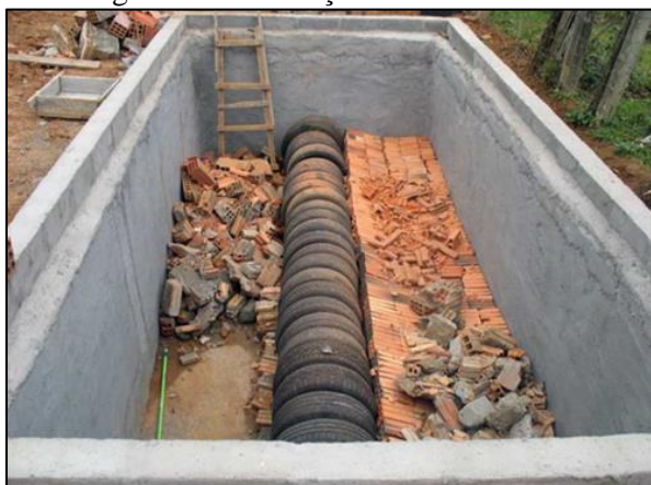
Figura 100. Execução fossa bananeira
