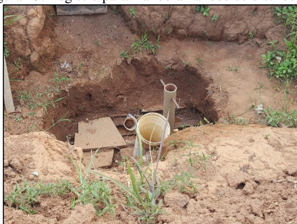
Figura 23. Registro para manobra na rede de distribuição
