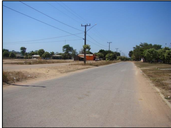
Figura 82. Vias pavimentadas sem dispositivos de drenagem na comunidade de Cinco Mil
