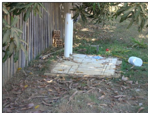
Figura 80. Fossa absorvente na comunidade Rochedo em Novo Mundo-MT
