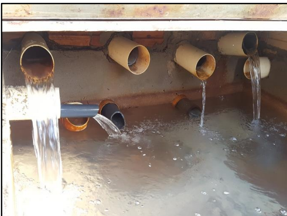
Figura 8. Água captada por tubulações drenantes na mina em Novo Mundo
