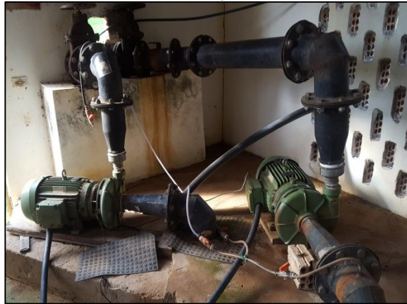
Figura 13. Conjuntos motobomba utilizados no recalque da água do poço de derivação para o reservatório de distribuição em Novo Mundo
