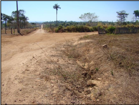
Figura 81. Estrada não pavimentada sem dispositivos de drenagem na comunidade Rochedo
