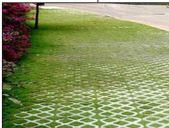
Figura 109. Pavimento poroso – concregrama instalado em passeio
