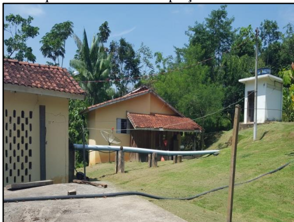
Figura 14. Casa de bombas, residência do operador e casa de química na área de captação de Novo Mundo
