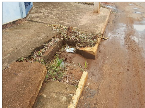
Figura 37. Boca de lobo sem tampa e assoreada na Av. Ayrton Senna (15)
