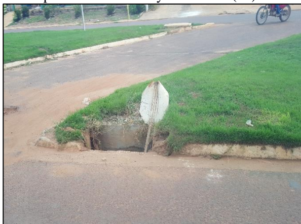
Figura 36. Boca de lobo sem tampa e com uma placa de “Pare” para alertar os motoristas e pedestres na Av. Ayrton Senna (13)
