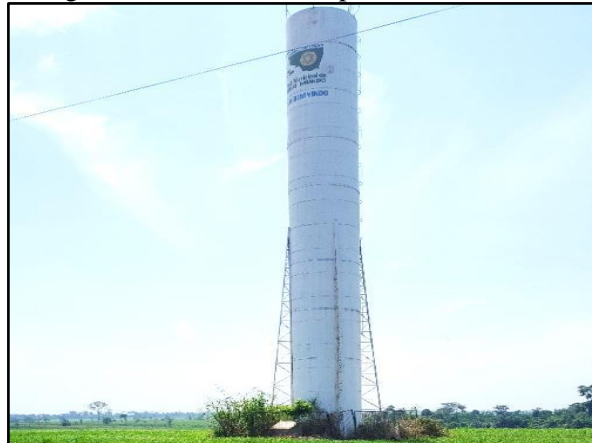
Figura 18. Reservatório apoiado de 145,0 m 3
