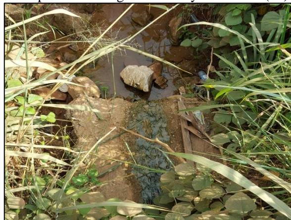
Figura 43. Desague da galeria pluvial sem dissipador de energia na Av. Ayrton Senna (19)
