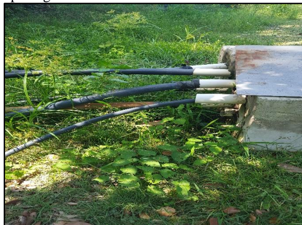
Figura 9. Chegada das tubulações na caixa de passagem dos drenos instalados na área da mina
