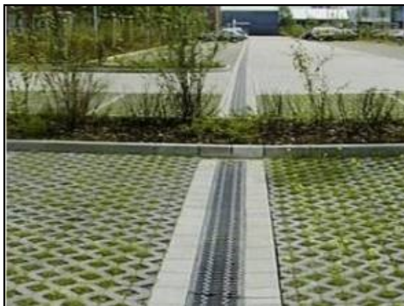
Figura 131. Trincheira de infiltração no estacionamento
