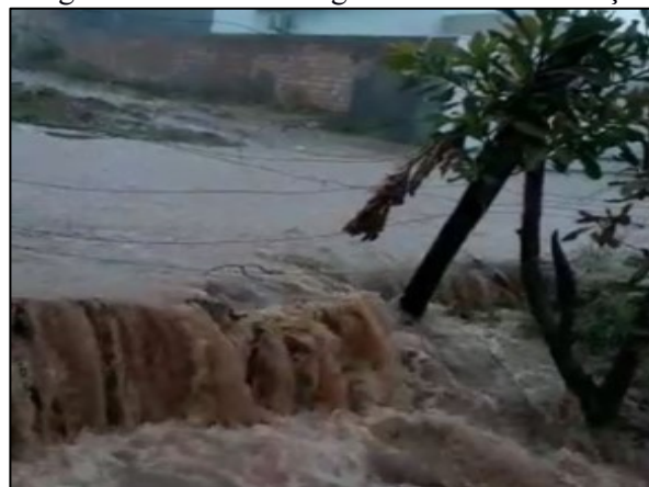
Figura 60. Ponto de alagamento na Rua França
