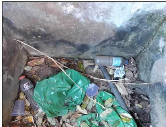
Figura 57. Caixa coletora em rua não pavimentada
