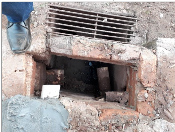
Figura 51. Vários lançamentos de esgoto na caixa coletora de boca de lobo, no centro
