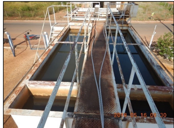
Figura 28. Decantador de alta taxa tipo colmeia
