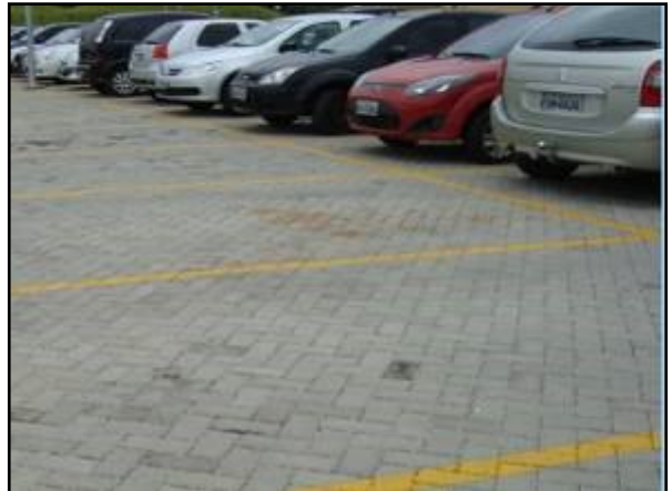
Figura 129. Pavimento poroso instalado em estacionamento
