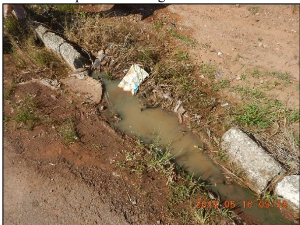
Figura 49. Despejo de águas na Rua Índia próximo ao lago artificial
