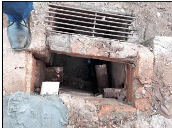
Figura 59.: Lançamento de esgoto doméstico em caixa coletora de boca de lobo - centro
