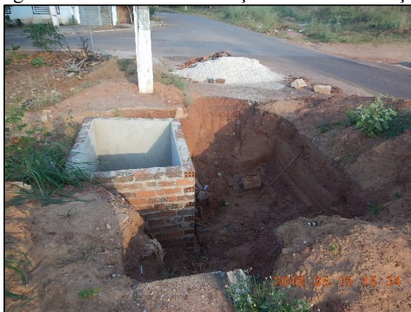
Figura 43. Booster em instalação na linha de adução
