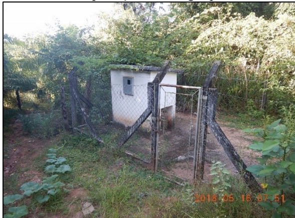
Figura 17. Portão e cerca de proteção do abrigo quadro comando da captação
