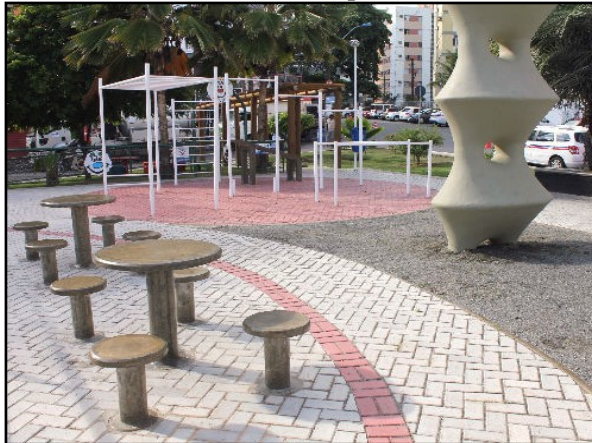
Figura 126. Pavimento poroso – piso intertravado instalado em praça
