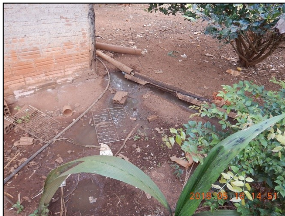
Figura 100. Esgoto de cozinha sendo lançado a céu aberto em uma residência no Assentamento Brilhante
