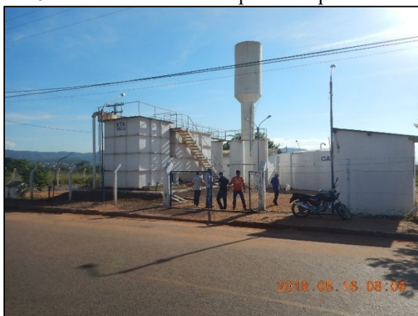
Figura 25. ETA metálica com capacidade para tratar 15 L/s
