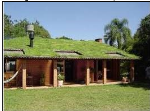
Figura 125. Telhado verde com plantas
