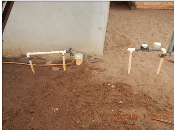
Figura 37. Ligação domiciliar com e sem hidrômetro
