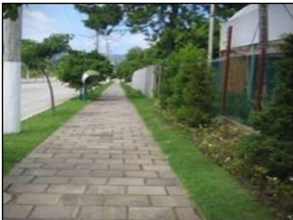
Figura 132. Vala de detenção ao longo da rua
