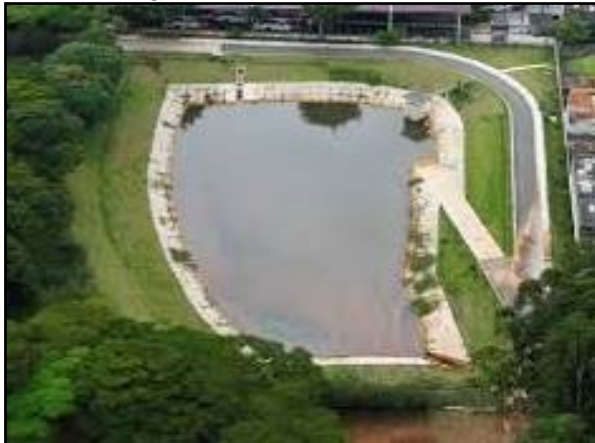
Figura 134. Bacia de detenção
