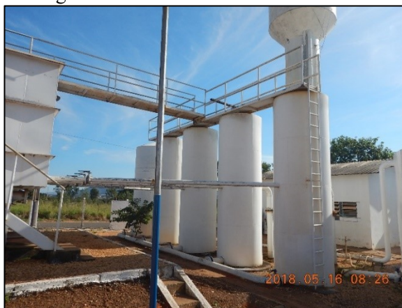
Figura 29. Filtros de fluxo descendentes
