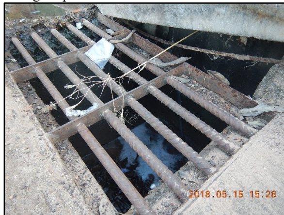
Figura 52. Lançamento de efluente nas galerias de águas pluvias no Loteamento Maria Luzia
