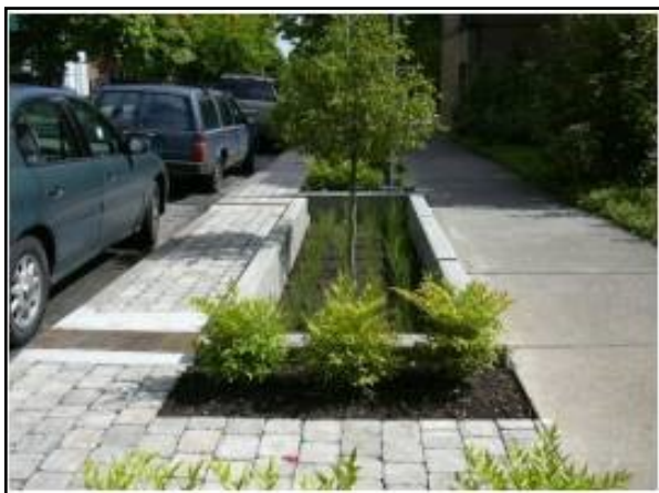
Figura 130. Trincheira de infiltração no passeio
