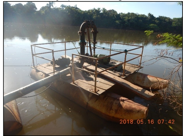
Figura 16. Barrilete e conjunto motobomba de captação no rio Araguaia
