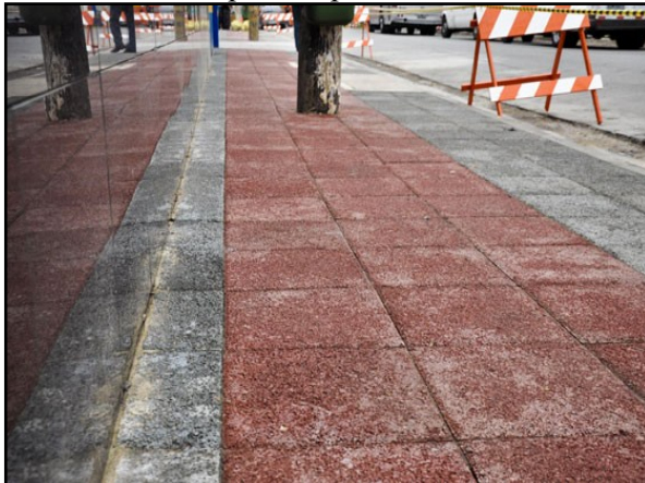
Figura 128. Pavimento poroso instalado em passeio público
