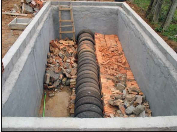
Figura 118. Execução fossa bananeira
