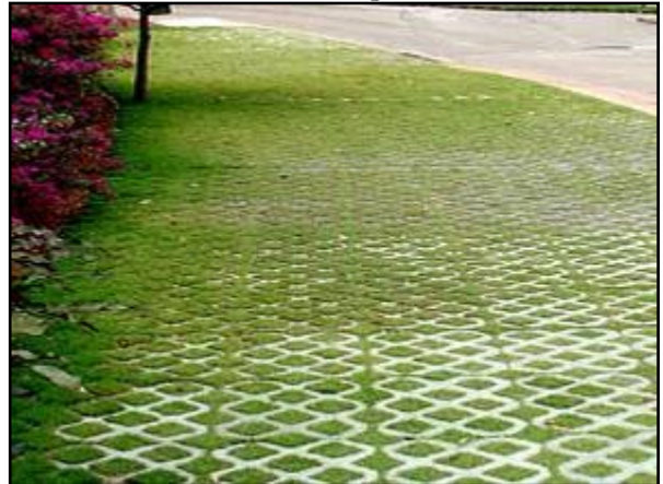
Figura 127. Pavimento poroso – concregrama instalado em passeio
