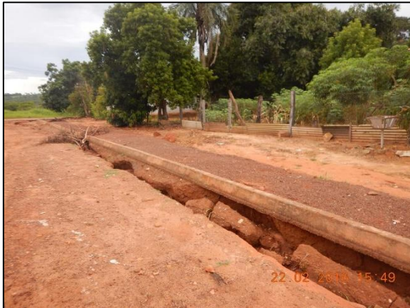
Figura 33. Processo erosivo acentuado com formação de ravinas no trecho compreendendo a Rua Tiradentes e a Rua Simião Martins, em Ponte Branca
