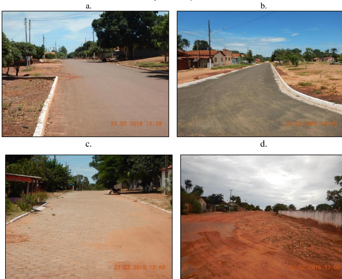
Figura 29. Via pavimentada com meio-fio (a) meio-fio e sarjeta (b), via com pavimento permeável e meio-fio (c) e via sem pavimentação (d), em Ponte Branca
