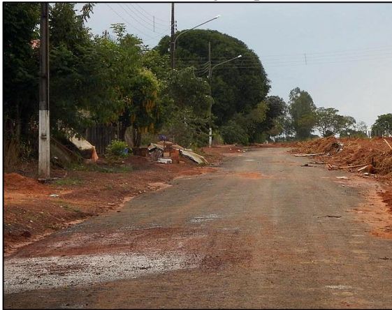
Figura 32. Formação de sulcos na lateral da Rua Santos Dumont (a) e Rua Presidente Vargas (b) devido ao escoamento de águas pluviais em trechos sem dispositivos de drenagem, em Ponte Branca
