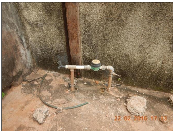
Figura 17. Ligações prediais hidrometradas (a) e não hidrometradas (b) no núcleo urbano
