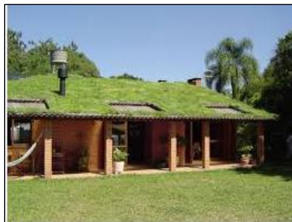
Figura 82. Telhado verde com plantas
