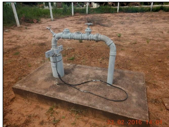
Figura 8. Poços tubulares profundos que compõem o SAA da sede urbana de Ponte Branca PT-01 (ativo) PT-02 (ativo)
