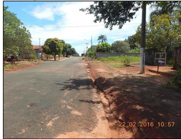
Figura 32. Formação de sulcos na lateral da Rua Santos Dumont (a) e Rua Presidente Vargas (b) devido ao escoamento de águas pluviais em trechos sem dispositivos de drenagem, em Ponte Branca
