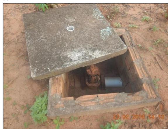
Figura 16. Registros de manobra do SAA de Ponte Branca na saída do reservatório (a) e na rede de distribuição, localizado na mesma área do reservatório (b)
