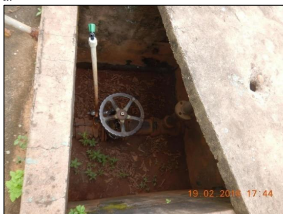
Figura 16. Registros de manobra do SAA de Ponte Branca na saída do reservatório (a) e na rede de distribuição, localizado na mesma área do reservatório (b)
