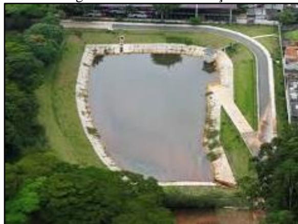
Figura 91. Bacia de detenção
