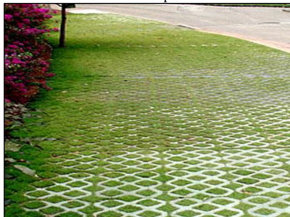
Figura 84. Pavimento poroso – concregrama instalado em passeio
