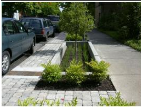
Figura 87. Trincheira de infiltração no passeio
