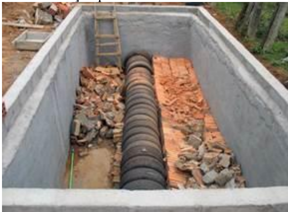
Figura 75. Método do círculo de bananeiras em execução para tratamento individual
