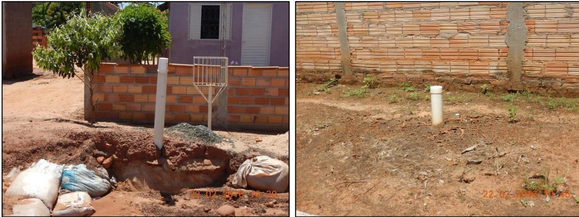
Figura 26. Vista dos suspiros de fossas existentes instaladas nas calçadas e passeios públicos do núcleo urbano de Ponte Branca
