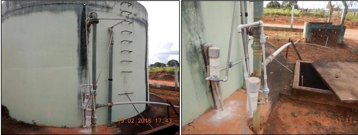
Figura 13. Sistema de cloração da água, clorador interligado à tubulação de entrada do reservatório apoiado (a) e armazenamento das pastilhas de cloro no abrigo de alvenaria (b), em Ponte Branca
