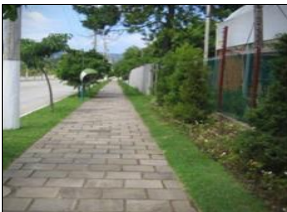
Figura 89. Vala de retenção ao longo da rua
