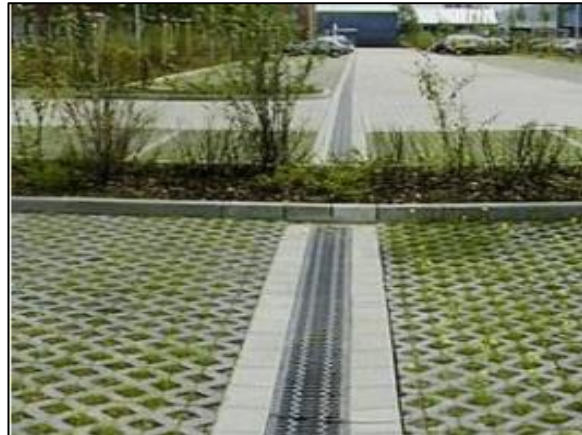
Figura 88. Trincheira de infiltração no estacionamento
