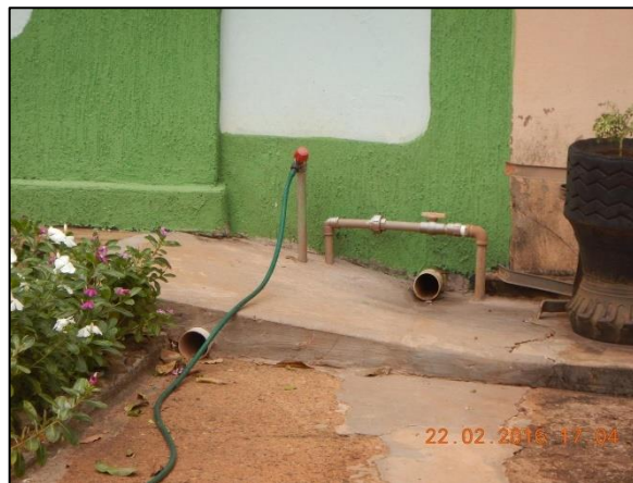
Figura 17. Ligações prediais hidrometradas (a) e não hidrometradas (b) no núcleo urbano
