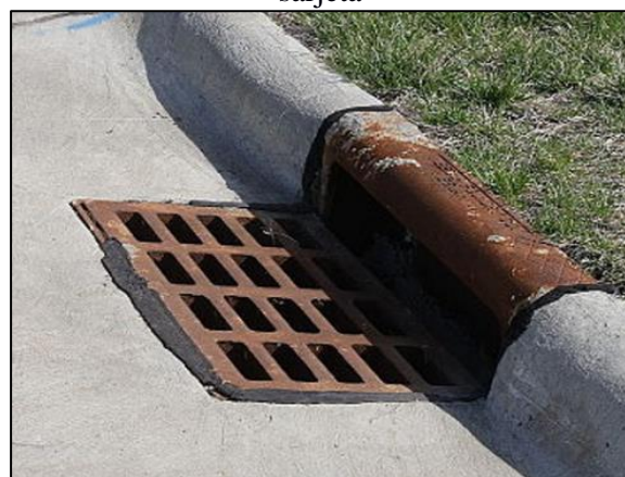
Figura 80. Boca de lobo com gradeamento na sarjeta
