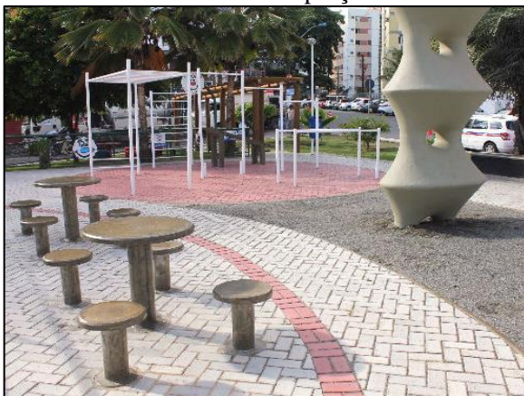
Figura 83. Pavimento poroso – piso intertravado instalado em praça
