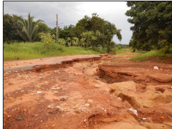
Figura 33. Processo erosivo acentuado com formação de ravinas no trecho compreendendo a Rua Tiradentes e a Rua Simião Martins, em Ponte Branca
