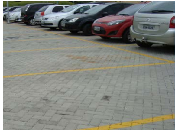
Figura 91. Pavimento poroso instalado em estacionamento
