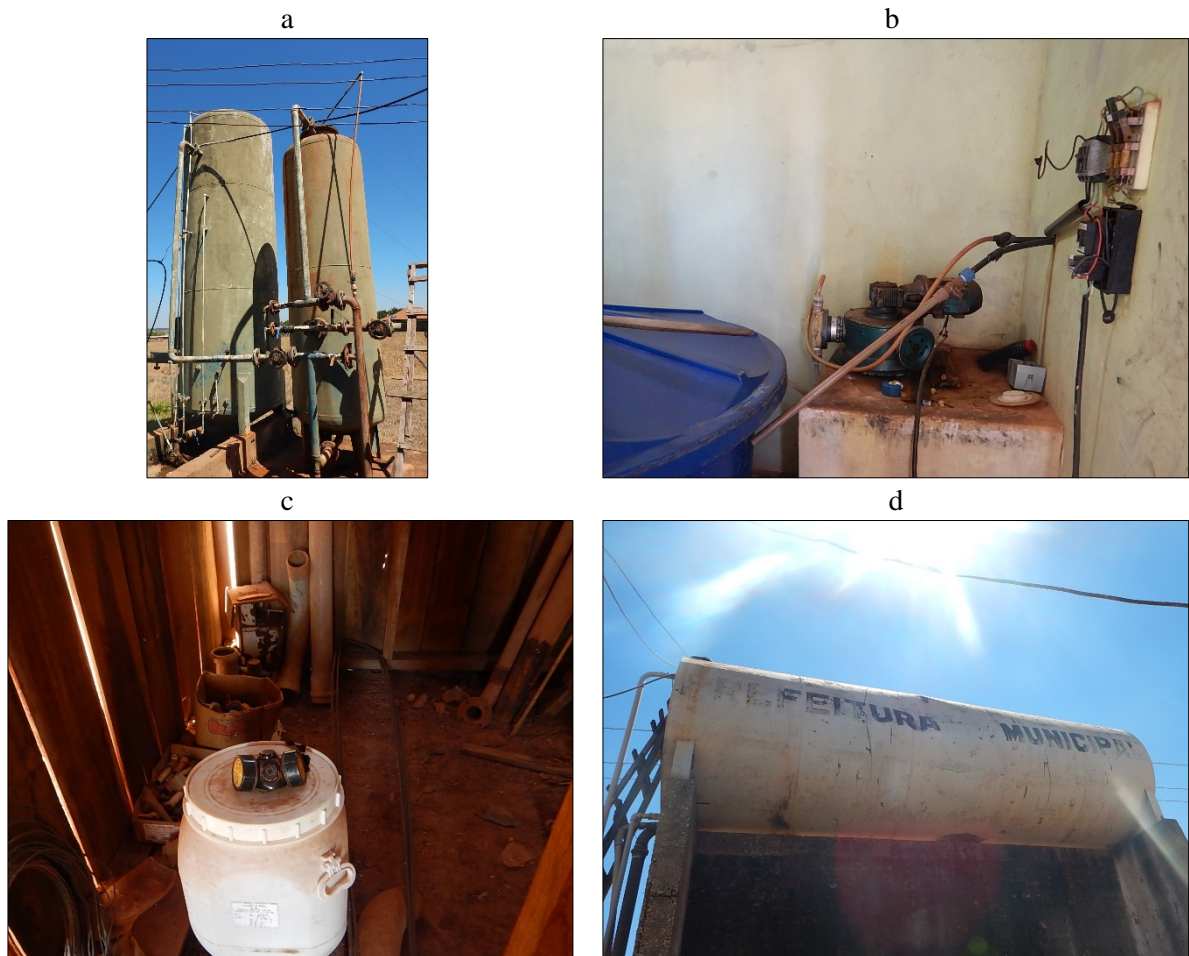
Figura 48. Filtros descendentes (a), dosador de cloro (b), tambor de cloro (d) e reservatório elevado (e), Gleba São João, Porto dos Gaúchos-MT
