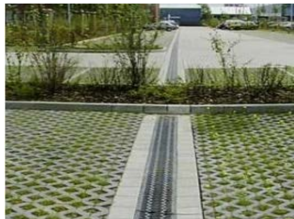
Figura 93. Trincheira de infiltração no estacionamento
