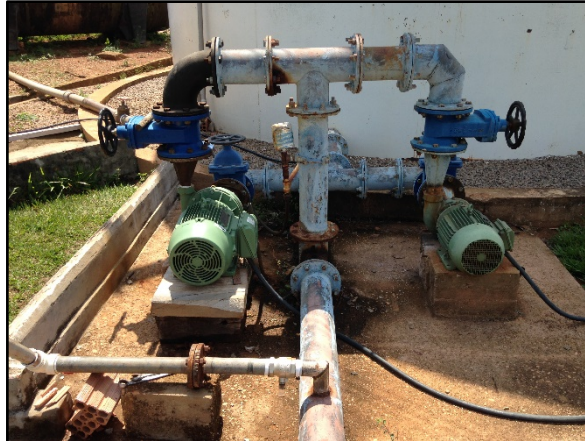
Figura 15. Conjunto motobomba na saída do reservatório, Porto dos Gaúchos-MT
