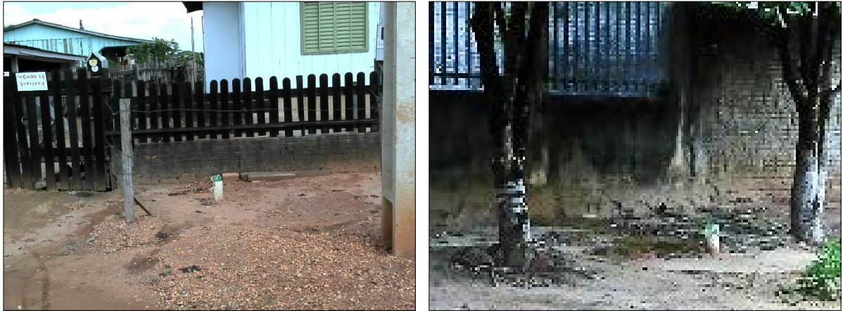
Figura 19. Fossas rudimentares implantadas na calçada na rua Rio de Janeiro
