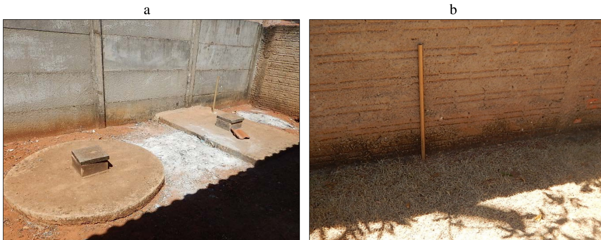
Figura 50. Fossa em construção (a) e vista exterior de fossa com suspiro, Gleba São João, Porto dos Gaúchos-MT
