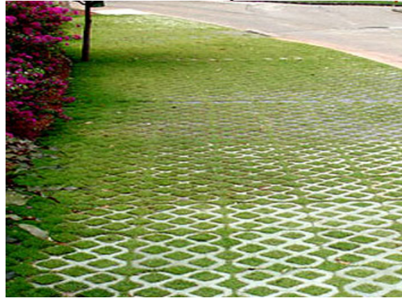
Figura 89. Pavimento poroso – concregrama instalado em passeio
