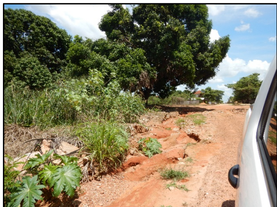
Figura 25. Erosão causada por águas pluviais, também na Av. Mato Grosso, Porto dos Gaúchos-MT
