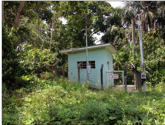
Figura 10. Abrigo do quadro de comando do conjunto motobomba
