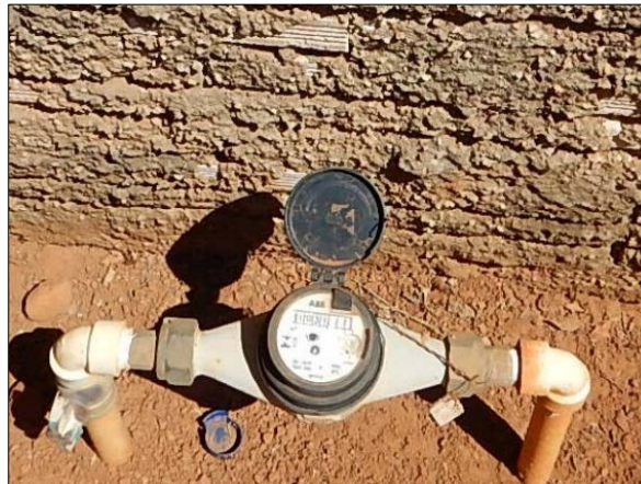
Figura 49. Cavalete com hidrômetro, Gleba São João, Porto dos Gaúchos-MT
