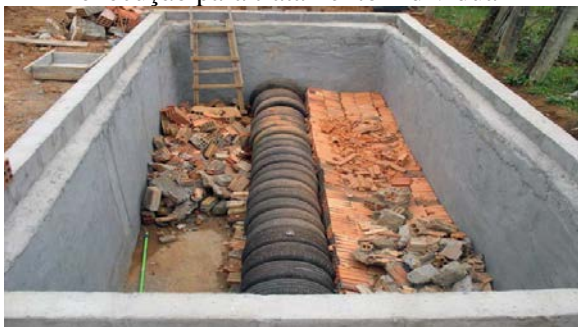
Figura 80. Método do círculo de bananeiras em execução para tratamento individual
