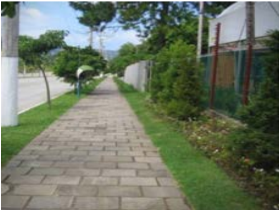
Figura 94. Vala de retenção ao longo da rua
