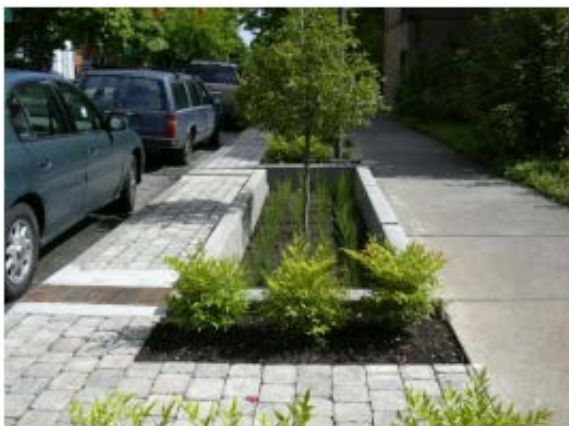
Figura 92. Trincheira de infiltração no passeio
