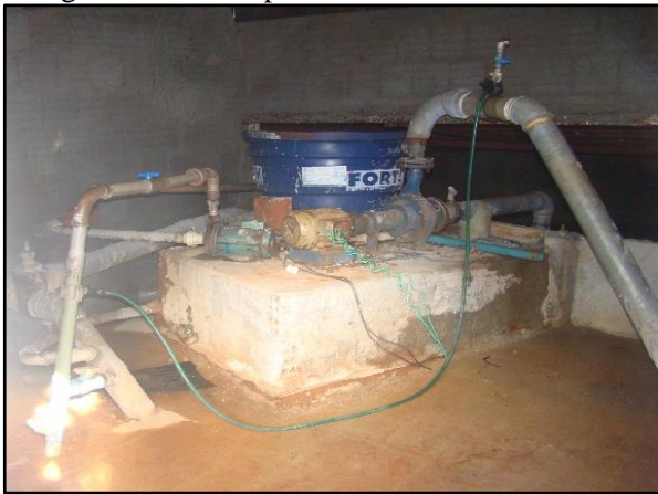
Figura 107. Conjunto motobomba de recalque da água da cisterna para o reservatório elevado
