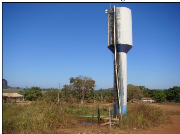
Figura 118. Reservatório tipo taça de 30 m 3 do distrito Johannesburgo
