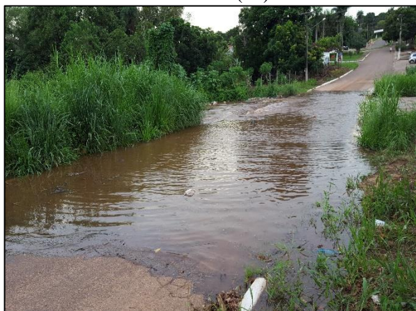
Figura 59. Ponte inundada na Av. Brasil sobre o Rio Areia (20)
