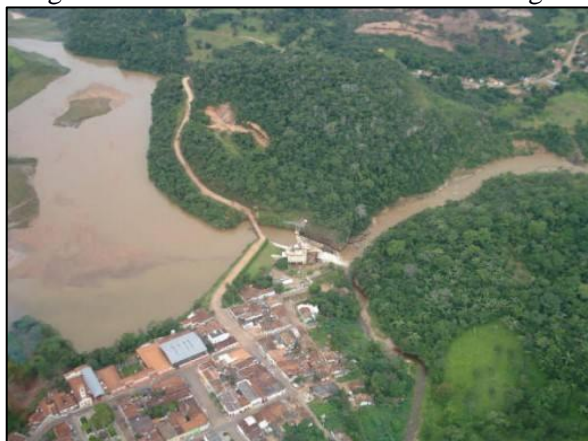
Figura 8. Hidrelétrica Governador José Fragelli
