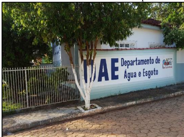
Figura 9. Fachada do escritório comercial e operacional do DAE
