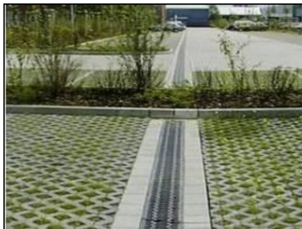
Figura 161. Trincheira de infiltração no estacionamento
