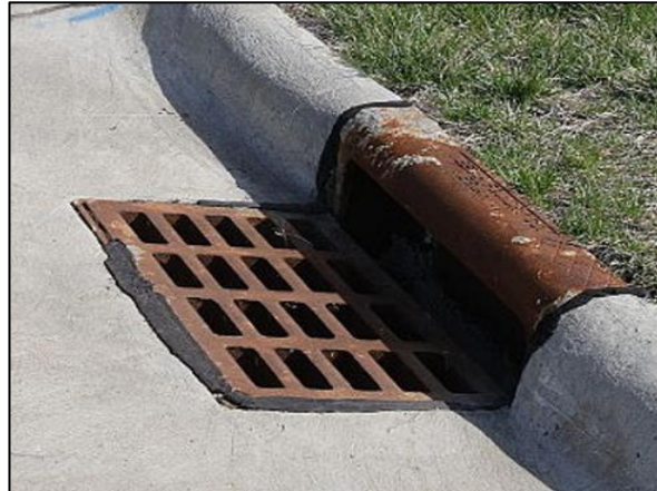
Figura 153. Boca de lobo com gradeamento
