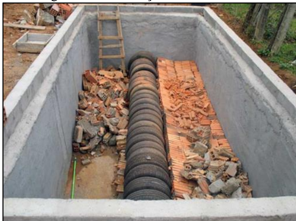
Figura 148. Execução fossa bananeira
