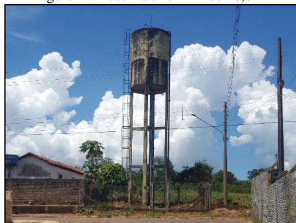
Figura 24. Reservatório REL de 40,0 m 3
