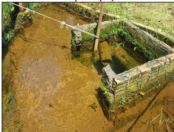
Figura 12. Mina utilizada para captação do SAA de Poxoréu
