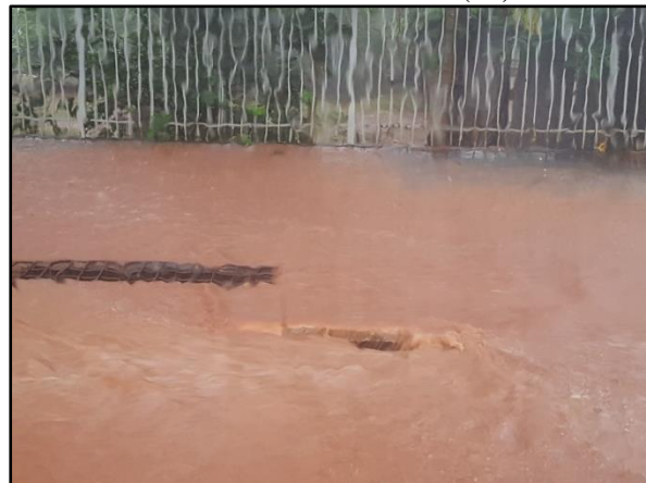
Figura 47. Boca de lobo afogada sem capacidade para drenar toda a contribuição superficial recebida, na Av. Brasília no bairro Jd. das Américas (14)
