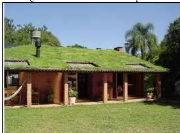
Figura 155. Telhado verde com plantas
