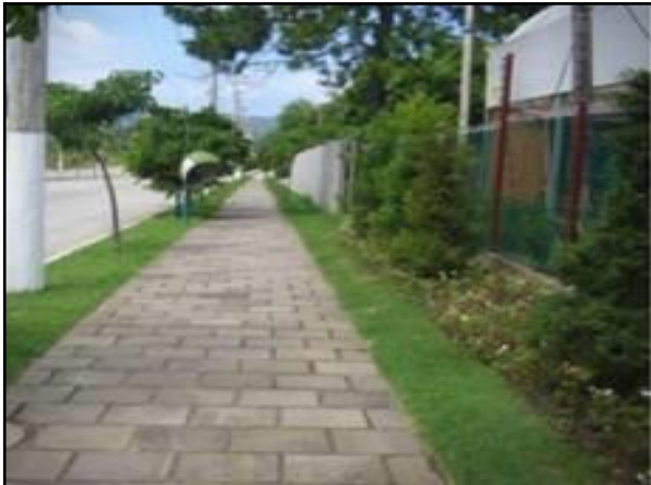
Figura 162. Vala de detenção ao longo da rua
