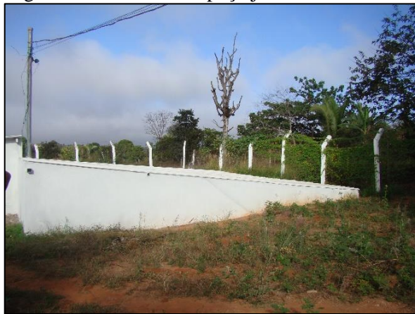
Figura 106. Cisterna do poço jorrante de Jarudore
