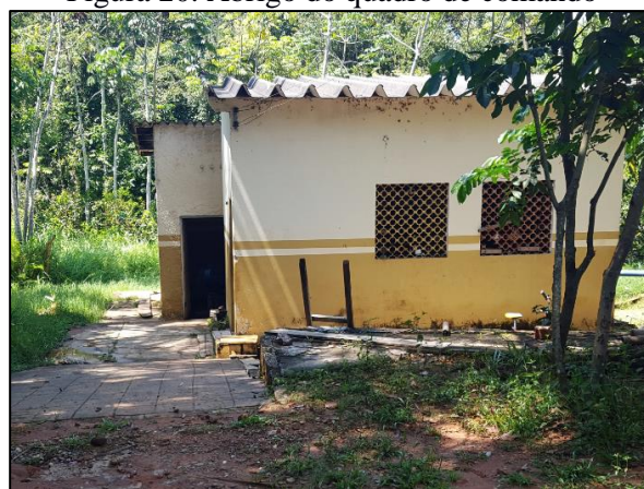
Figura 20. Abrigo do quadro de comando
