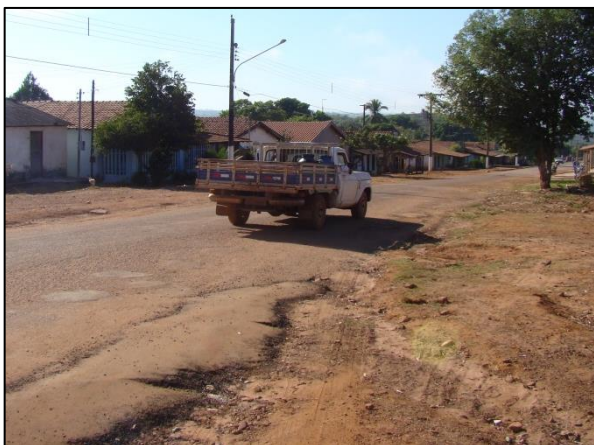
Figura 129. Processo erosivo na margem de uma via pavimentada desprovida de microdrenagem em Jarudore
