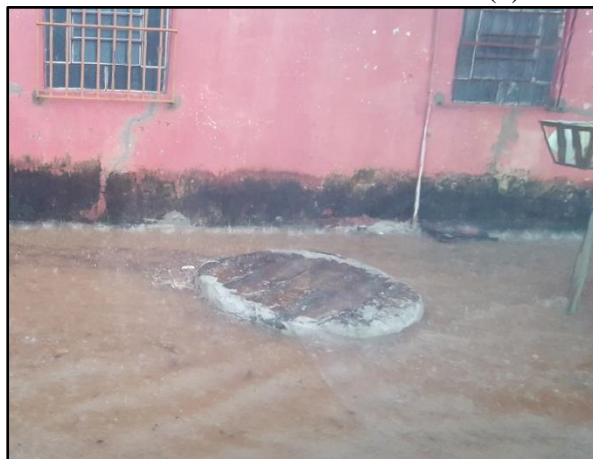
Figura 54. Residência alagada na Rua Minas Gerais no bairro Centro Histórico (4)
