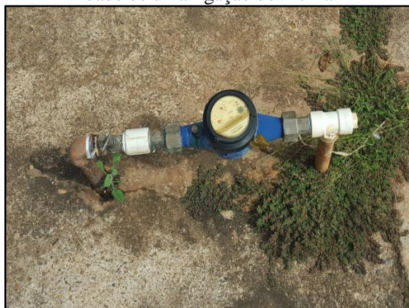
Figura 27. Hidrômetro com mais de 5 anos de idade de uma ligação domiciliar
