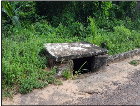
Figura 42. Boca de lobo com abertura de engolimento grande na Avenida Bandeirantes
