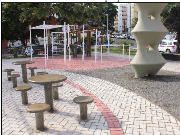
Figura 156. Pavimento poroso – piso intertravado instalado em praça
