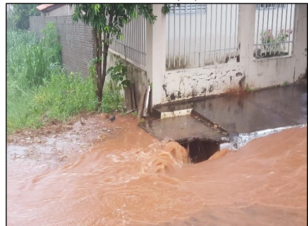
Figura 44. Boca de lobo com depressão mal executada na Rua Poconé no bairro Jd. das Américas (12)
