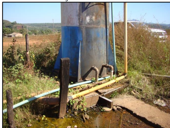
Figura 119. Vazamento na base e parede enferrujada do reservatório
