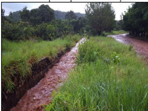
Figura 55. Volume de água pluviais no início do canal ocupando quase toda sua seção
