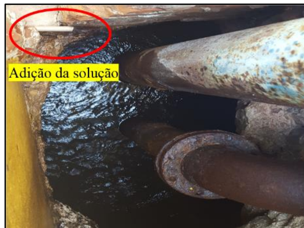
Figura 22. Dosagem do hipoclorito de cálcio no poço de sucção
