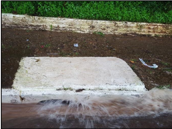
Figura 45. Boca de lobo com depressão mal executada na Av. Brasil no Centro (21)
