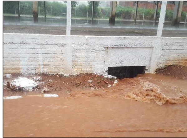
Figura 46. Boca de lobo sem depressão para captação na Av. Brasília no bairro Jd. Américas (13)
