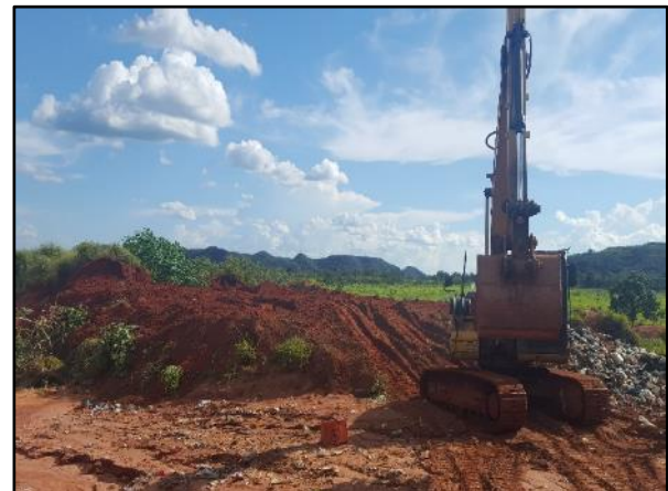
Figura 76. Escavadeira realizando o cobrimento com material inerte dos resíduos no lixão
