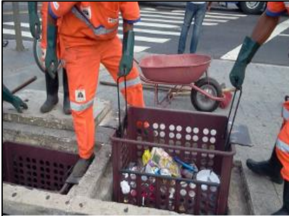
Figura 152. Cesta acoplada a boca do bueiro
