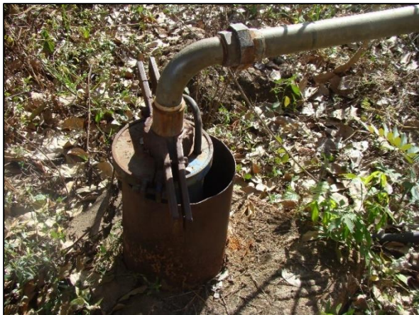
Figura 100. Barrilete do poço tubular (PT-01) do distrito Alto Coité – Sistema I
