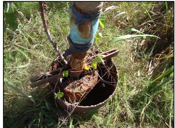
Figura 101. Barrilete do poço tubular (PT-02) do distrito Alto Coité – Sistema II
