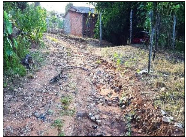
Figura 62. Processo erosivo na Rua Nabu no bairro Vila Cruzeiro (18)
