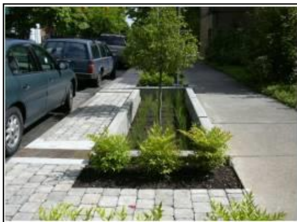
Figura 160. Trincheira de infiltração no passeio
