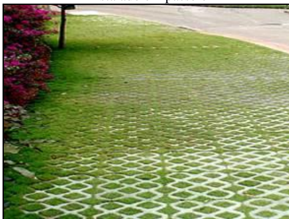
Figura 157. Pavimento poroso – concregrama instalado em passeio
