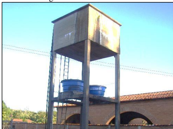
Figura 114. Reservatório da igreja que abastece as bicas d'água no distrito Paraíso do Leste
