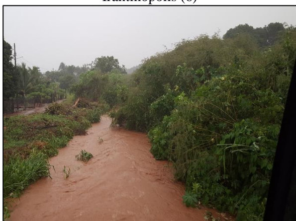
Figura 57. Escoamento superficial em um terreno próximo na Rua Dom Pedro II no bairro Irantinópolis (6)
