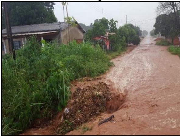
Figura 61. Processo erosivo na Rua Sobral Pinto no bairro Lagoa I (8)
