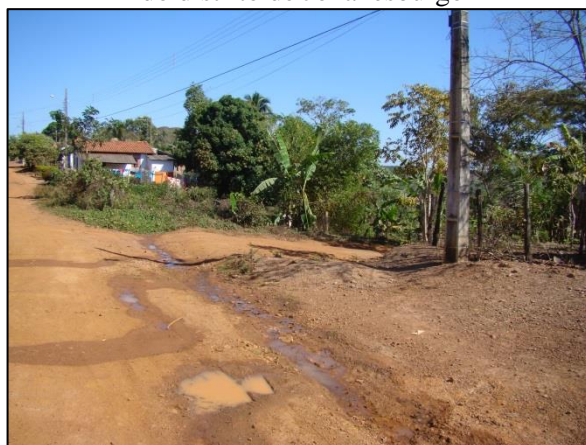
Figura 126. Esgoto escoando a céu aberto na via do distrito de Johannesburgo
