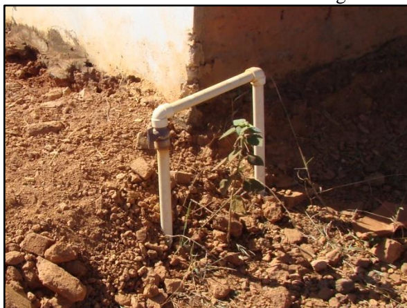
Figura 120. Ligação predial equipado com hidrômetro no distrito Johannesburgo
