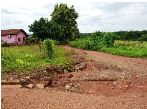
Figura 61 - Início de processo erosivo em ponto da cidade
