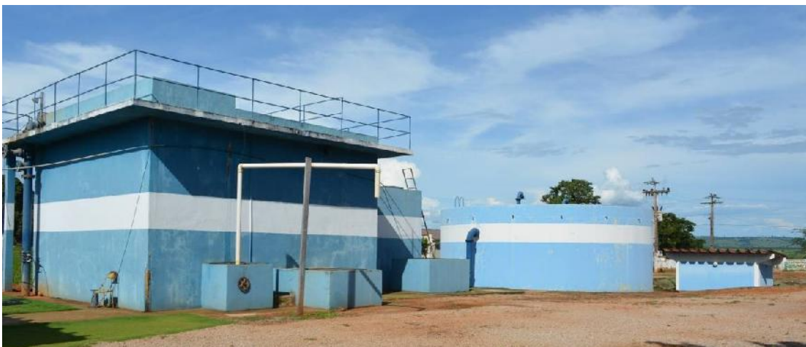
Figura 22 - Vista da E.T.A Convencional
