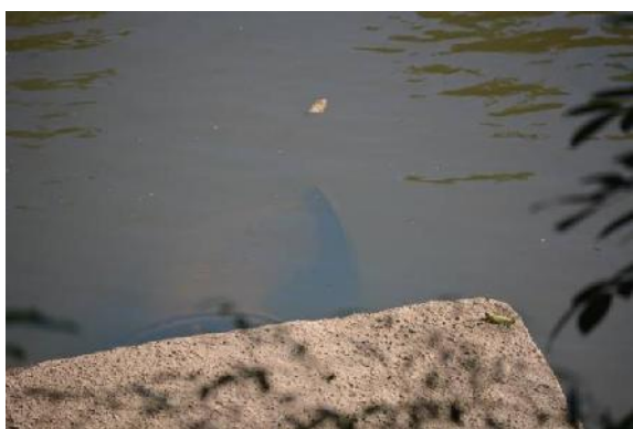
Figura 38 - Captação de Água Bruta Rio bracinho
