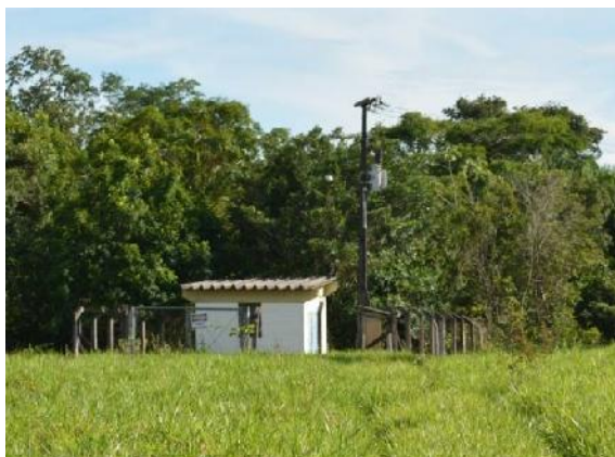
Figura 40 - Instalações de Apoio – captação
