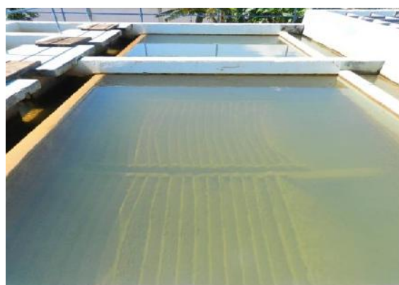
Figura 45-Decantador
