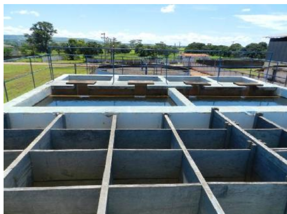
Figura 46 - Vista superior da ETA
