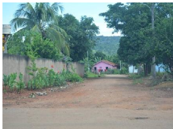
Figura 64 - vista de erosão em início de rua não pavimentada
