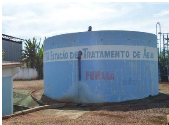
Figura 24 - Reservatório 300 m 3 , instalado na área da E.T.A
