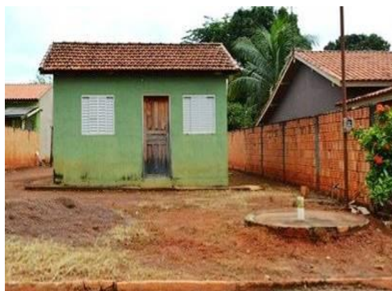
Figura 53- Fossa implantada em frente de casa
