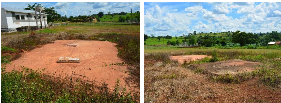
Figura 85 - Vista da fossa para Resíduos de Saúde
