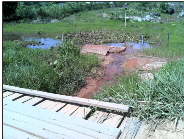
Figura 24. Ponto de deságue sem galeria e dissipador de energia
