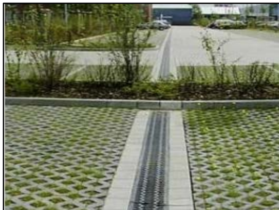
Figura 79. Trincheira de infiltração no estacionamento
