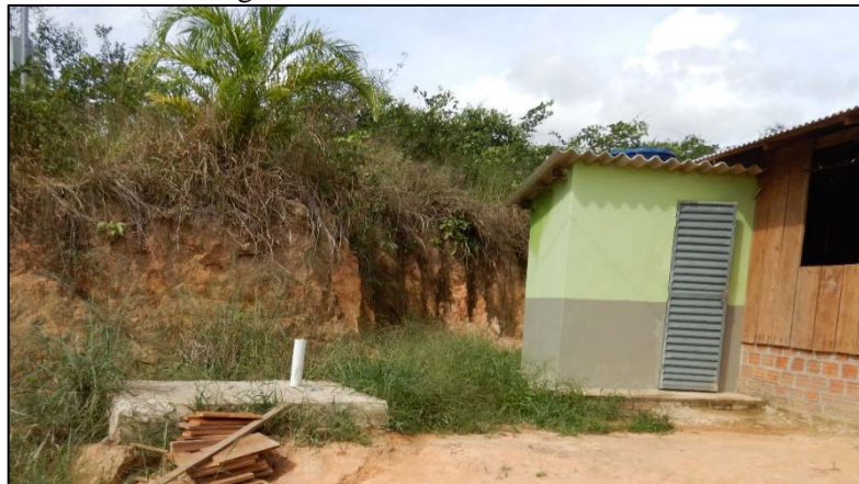
Figura 49. Módulo sanitário e fossa
