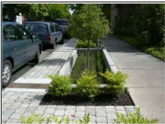
Figura 78. Trincheira de infiltração no passeio
