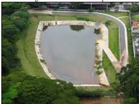
Figura 82. Bacia de detenção
