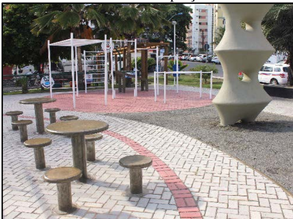
Figura 74. Pavimento poroso – piso intertravado instalado em praça
