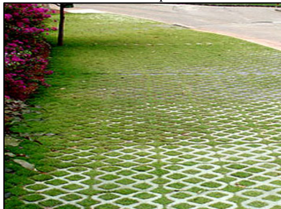
Figura 75. Pavimento poroso – concregrama instalado em passeio
