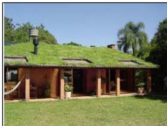
Figura 73. Telhado verde com plantas
