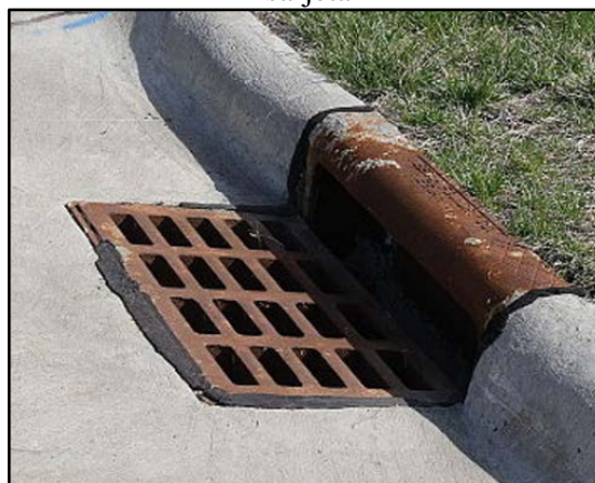
Figura 71. Boca de lobo com gradeamento na sarjeta
