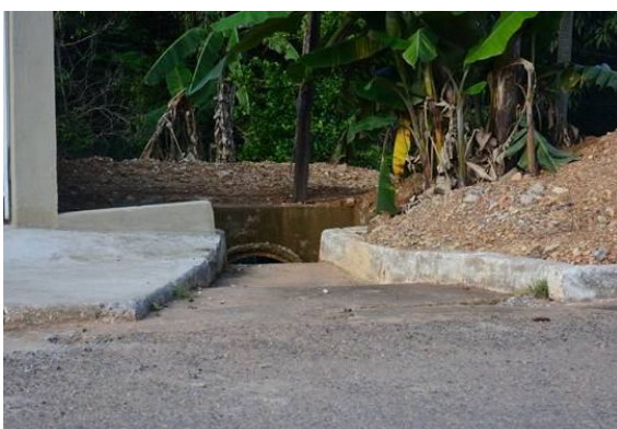
Figura 70– Saída d'água seguida de bueiro celular
