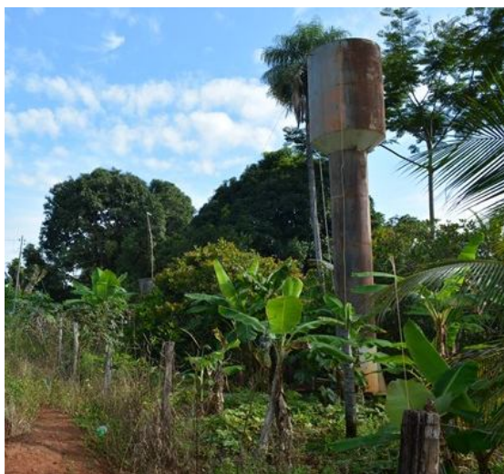
Figura 28 - Reservatório que abastece a Vila São Jorge
