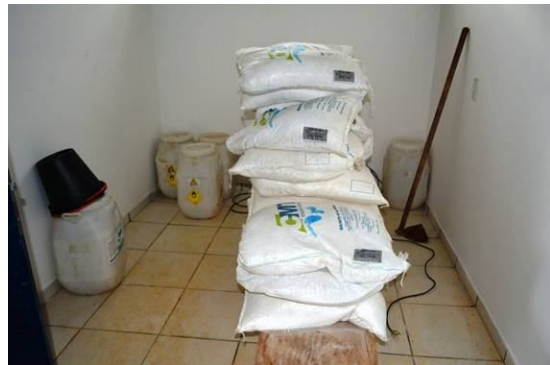
Figura 49– Casa de química estocagem de produto químico
