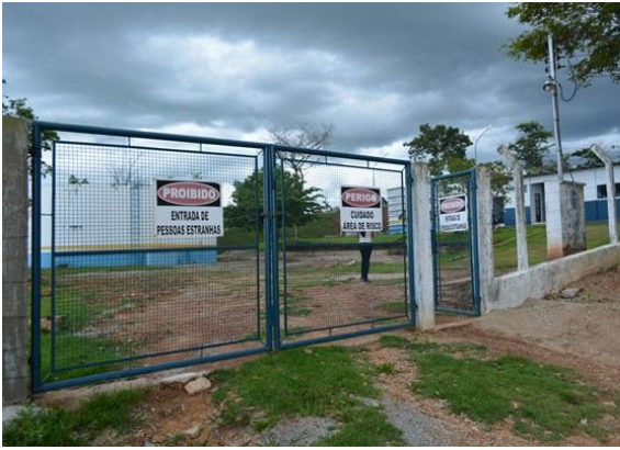
Figura 40– Departamento de Água e Esgoto do município
