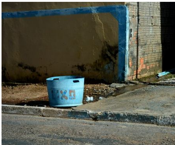
Figura 76– tambor de 200l adaptado como lixeira para acondicionamento dos RSD
