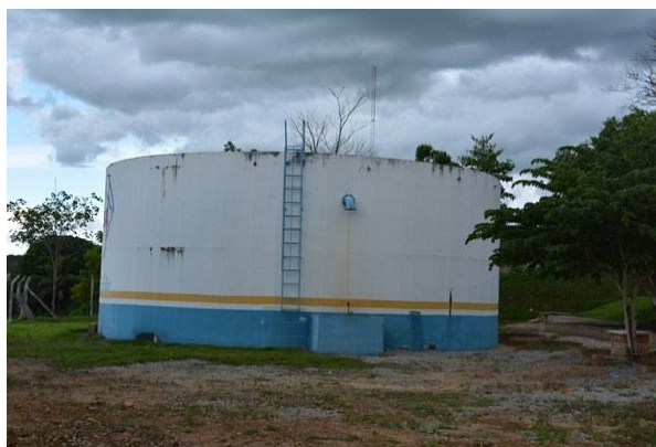
Figura 51 – Reservatório em concreto armado
