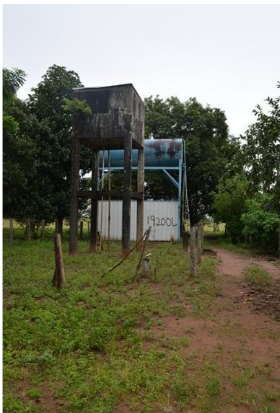
Figura 22 – reservatório de 0,65m 3 e 19,2m 3 respectivamente
