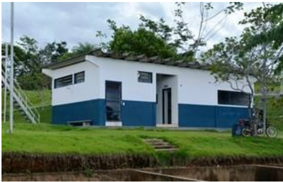
Figura 48– Casa de química e laboratório
