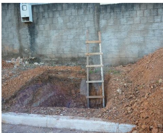
Figura 56– construção de fossa na calçada
