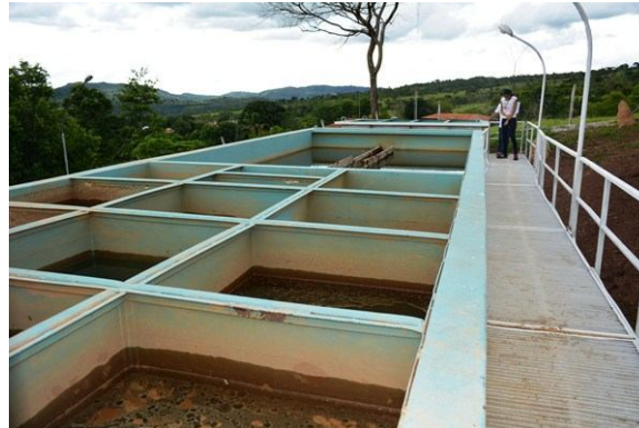
Figura 43– Floculador tipo chicanas
