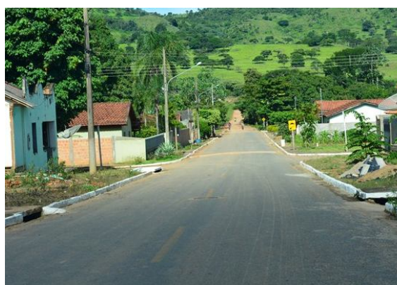
Figura 65 – Via com sistema de drenagem em ótimo estado de conservação
