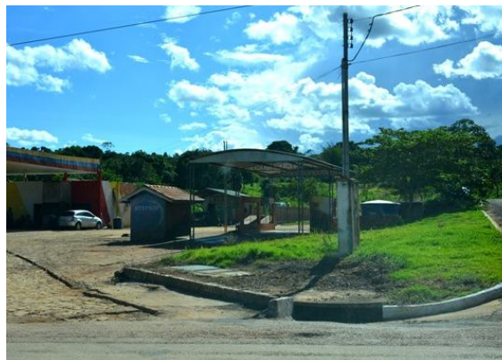
Figura 63 – Boca de lobo na entrada do posto de gasolina
