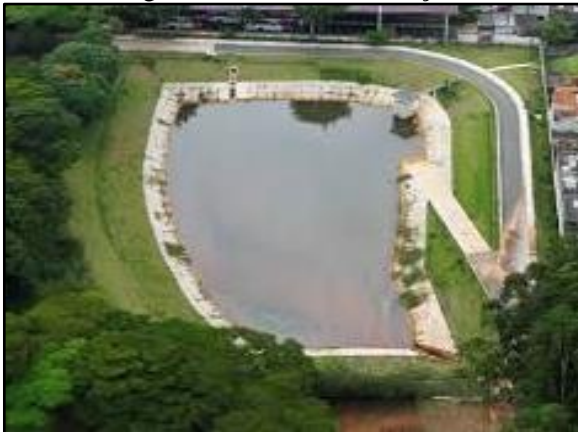
Figura 61. Bacia de detenção
