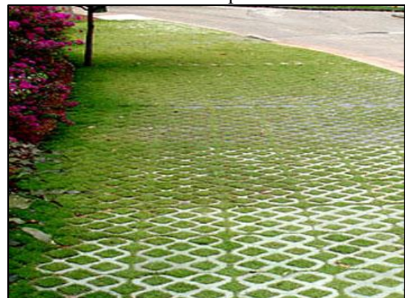
Figura 56. Pavimento poroso – concregrama instalado em passeio
