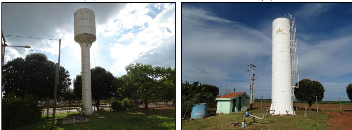
Figura 10. (A) Reservatório 01 (B) Reservatório 02 (A) (B)
