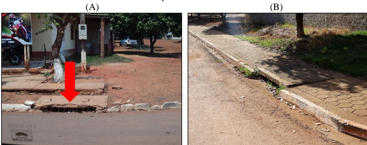
Figura 17. Boca de lobo (A) danificada (B) em bom estado de conservação (C) Drenagem em via não-pavimentada
