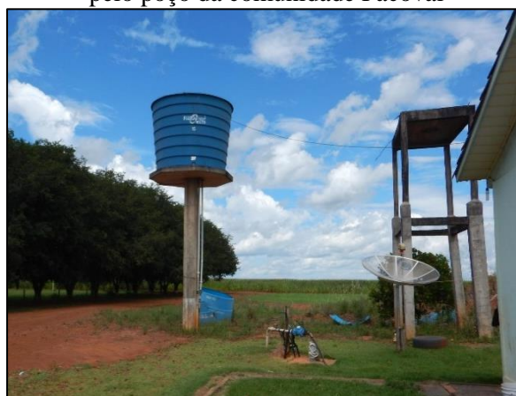
Figura 29. Reservatório elevado de fibra de vidro responsável pelo armazenamento das águas captadas pelo poço da comunidade Pacoval
