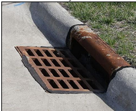
Figura 53. Boca de lobo com gradeamento na sarjeta
