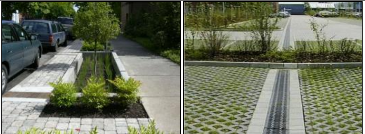
Figura 59. Trincheira de infiltração (A) no passeio (B) estacionamento (A) (B)
