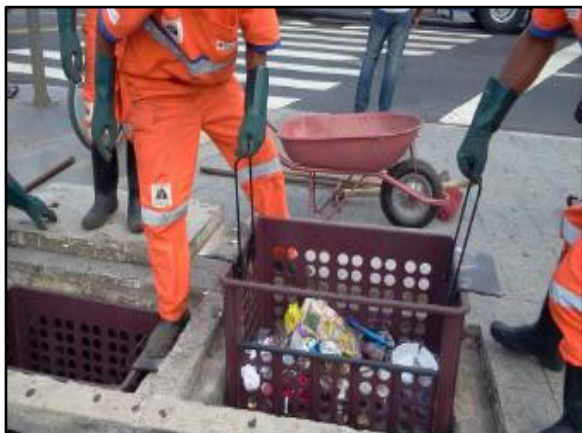
Figura 52. Cesta acoplada à boca do bueiro
