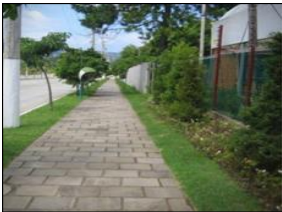
Figura 117. Vala de detenção ao longo da rua
