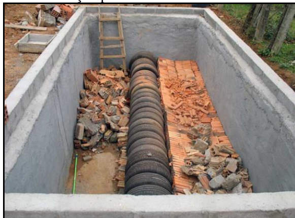
Figura 103. Método do círculo de bananeiras em execução para tratamento individual
