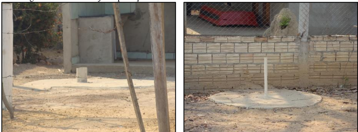
Figura 66. Vista da laje de proteção de fossas rudimentares na comunidade Antônio Rosa
