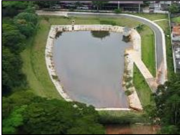
Figura 119. Bacia de detenção
