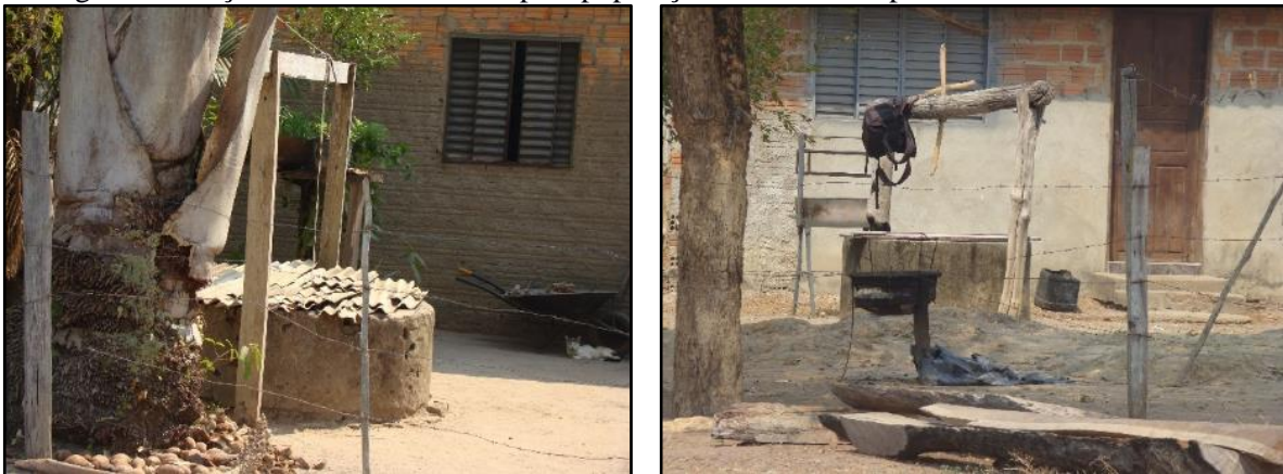
Figura 65. Poços-cacimba utilizados pela população não atendida pelo abastecimento coletivo
