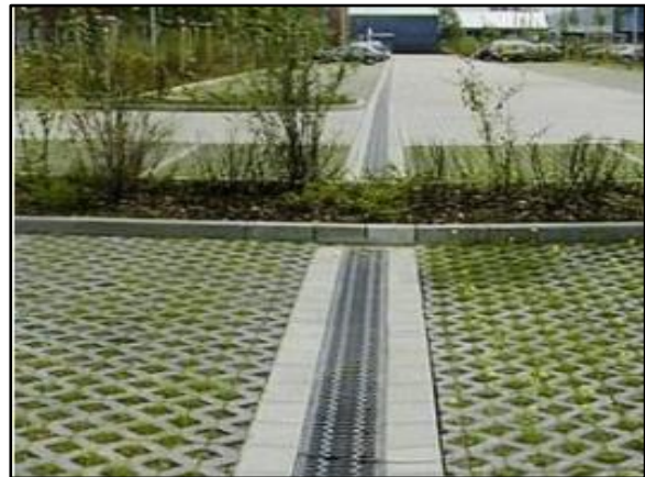
Figura 116. Trincheira de infiltração no estacionamento
