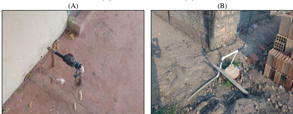
Figura 21. Ligações domiciliares observadas no núcleo urbano de Santa Terezinha, com hidrômetro (A) e somente com cavalete (B)
