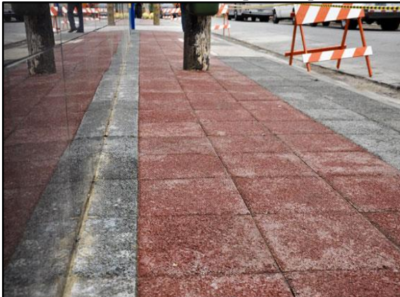
Figura 113. Pavimento poroso – piso intertravado instalado em passeio público
