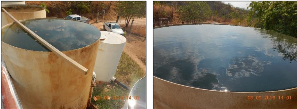
Figura 15. Filtros da ETA
