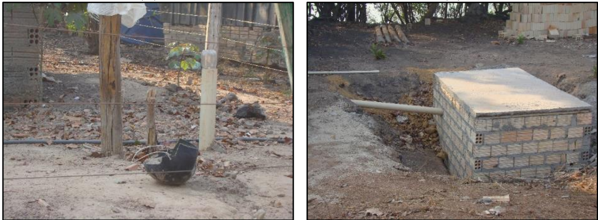
Figura 72. Vista do suspiro de uma fossa (A), e construção de fossa rudimentar (B)
