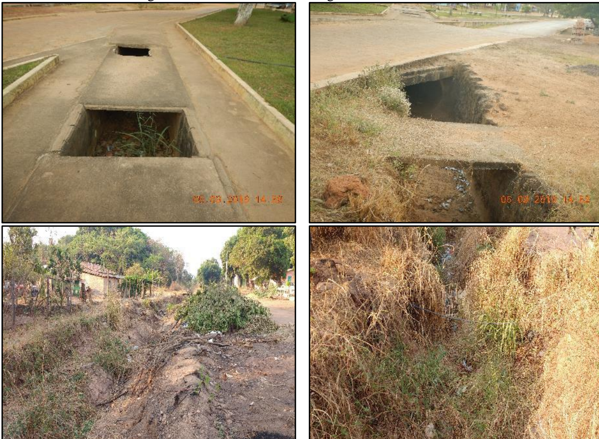
Figura 33. Canal de macrodrenagem de Santa Terezinha
