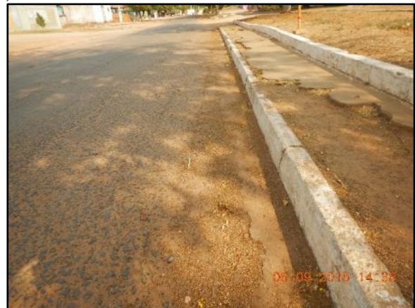
Figura 35. Microdrenagem – meio-fio e sarjeta (A), bocas de lobo (B), poço de visita (C)
