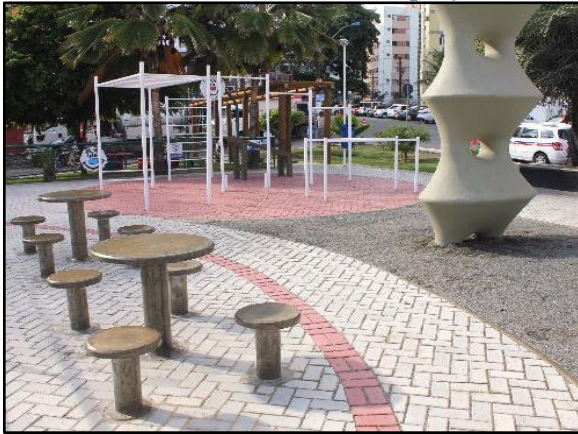
Figura 111. Pavimento poroso – piso intertravado instalado em praça
