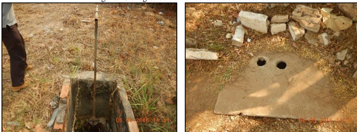
Figura 20. Registros de manobra dos dois setores
