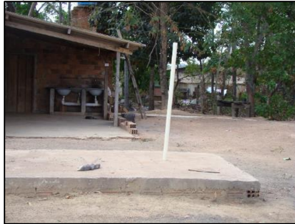
Figura 79. Vista da laje de proteção e suspiro de uma fossa rudimentar na comunidade
