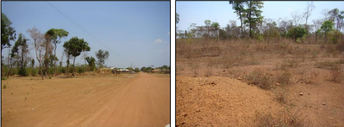
Figura 87. Vias não pavimentadas na comunidade Porto Velho
