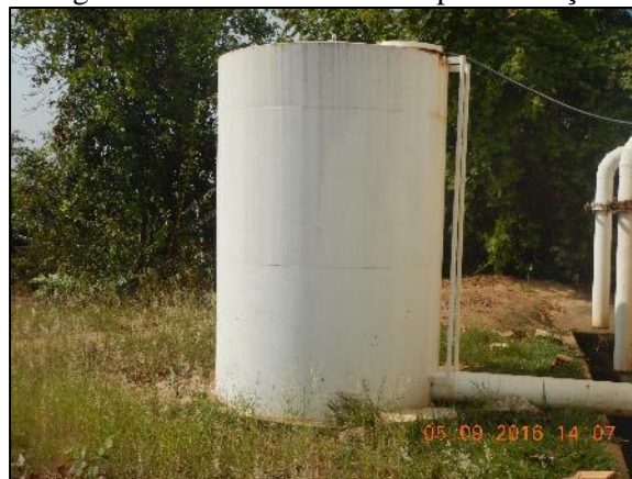
Figura 16. Câmara de contato para cloração
