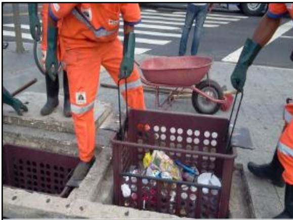
Figura 107. Cesta acoplada a boca do bueiro
