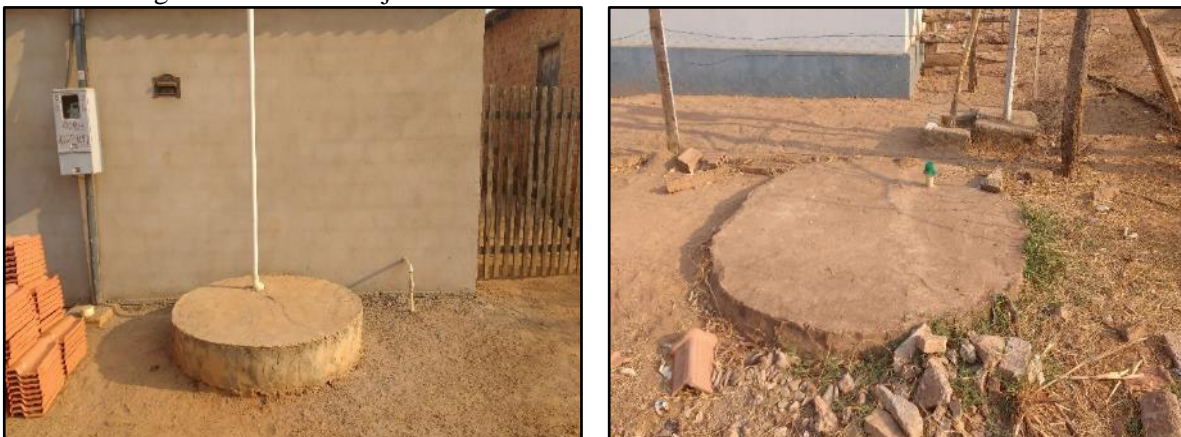
Figura 29. Vista da laje de fossa existente no núcleo urbano de Santa Terezinha
