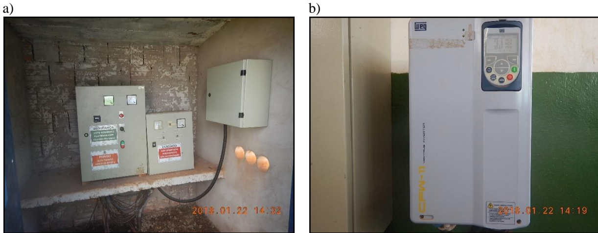
Figura 11. a) Modelo de painel de controle dos poços tubulares b) Painel de telemetria das elevatórias de água tratada
