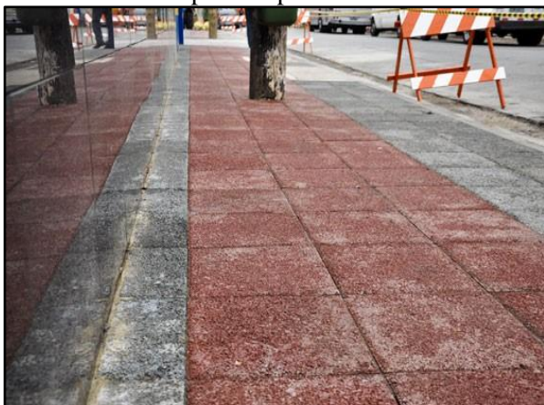
Figura 64. Pavimento poroso – instalado em passeio público
