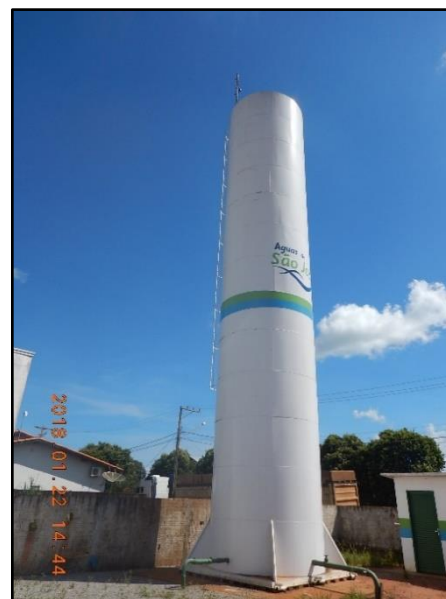
Figura 12. a) RAP-01, capacidade de 150 m 3 ; b) RAP-02, capacidade de 150m 3 ; c) RAP-03, capacidade de 150m 3 ; d) Reservatório metálico apoiado de 500 m 3 - RAP-04
