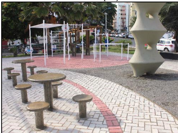
Figura 62. Pavimento poroso – piso intertravado instalado em praça
