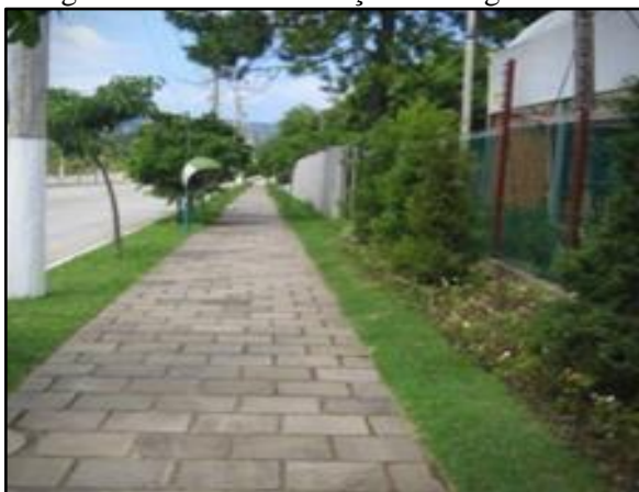
Figura 68. Vala de retenção ao longo da rua
