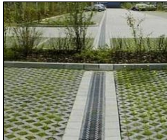
Figura 67. Trincheira de infiltração no estacionamento
