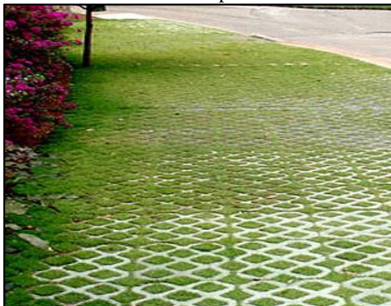
Figura 63. Pavimento poroso – concregrama instalado em passeio
