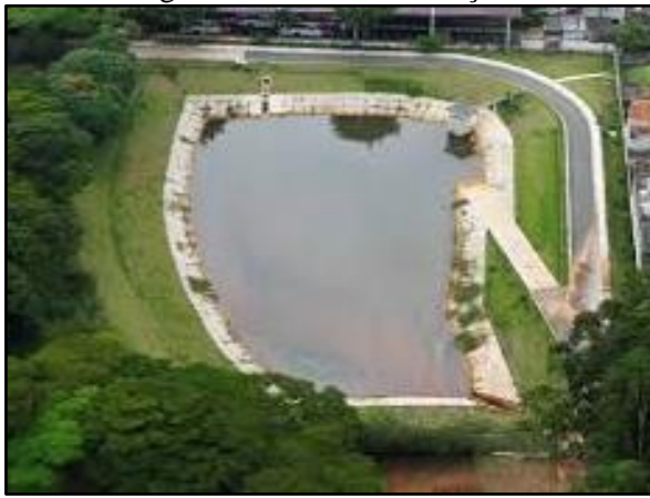
Figura 70. Bacia de detenção
