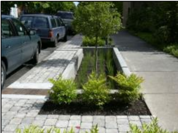
Figura 66. Trincheira de infiltração no passeio
