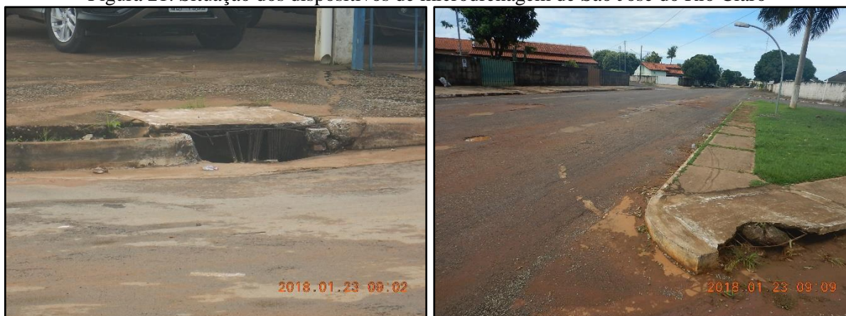
Figura 21. Situação dos dispositivos de microdrenagem de São José do Rio Claro
