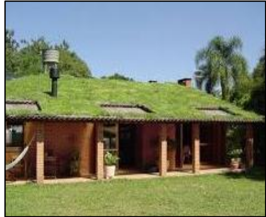
Figura 61. Telhado verde com plantas
