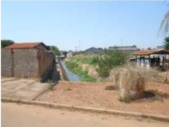
Figura 56– Canalização em seção aberta do Córrego Queixada.
