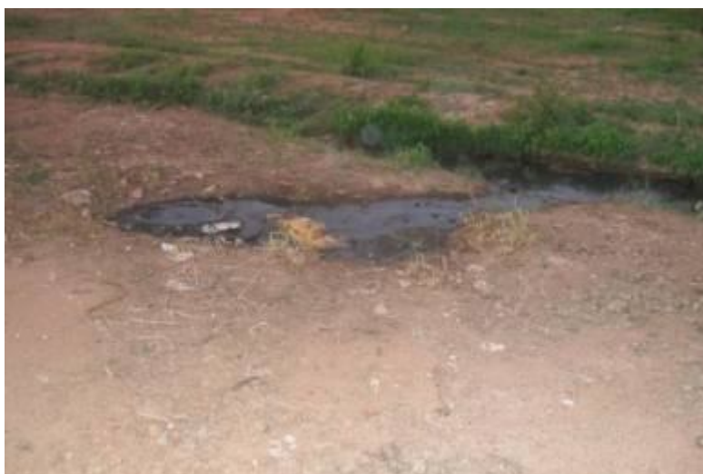
Figura 50 – Afloramento de esgoto - Estação Elevatória II
