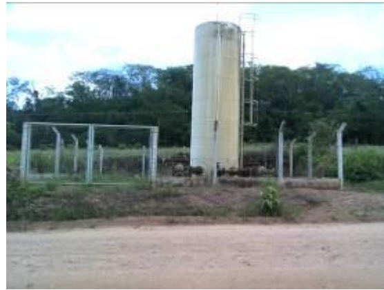
Figura 37 – Elevat. de Água Bruta 02.
