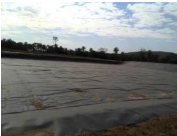
Figura 76 – Vala impermeabilizada do aterro sanitário consorciado.
