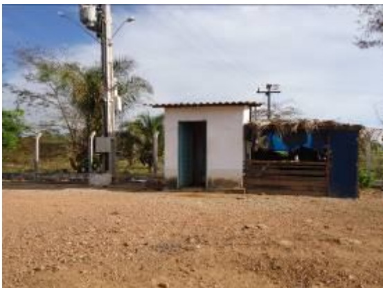
Figura 33 – Instalações de apoio.
