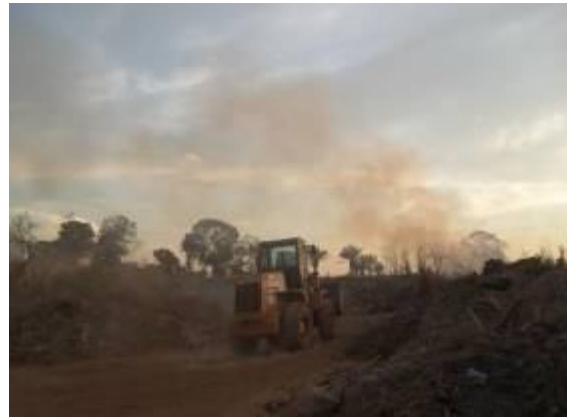
Figura 81 – RCD e resíduos de poda pegando fogo.
