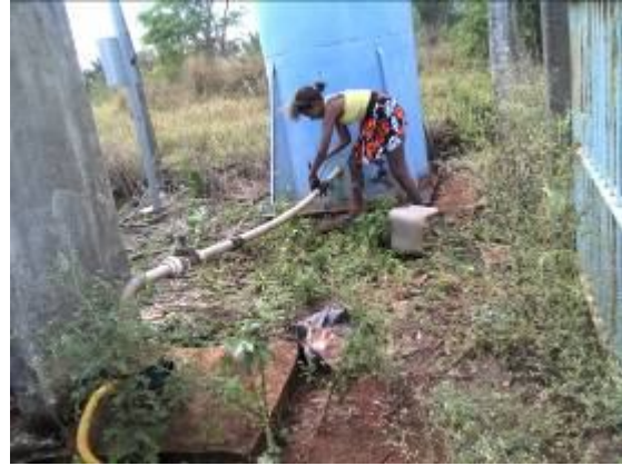
Figura 28 – Moradora fazendo reparo.
