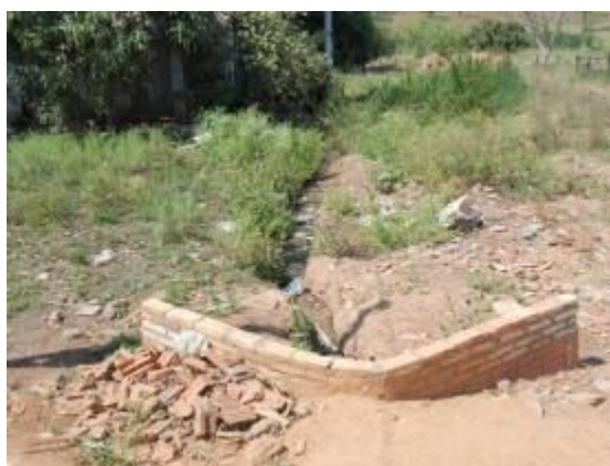
Figura 63 - Erosão em terreno causada pelo lançamento de águas pluviais sem a dissipação de energia.
