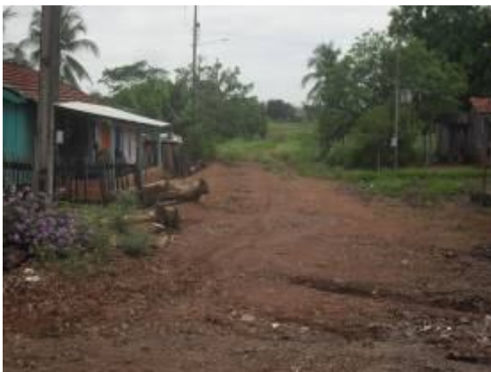
Figura 58 - Via em Ap. Bela, receptora das águas da Rodovia MT 339.
