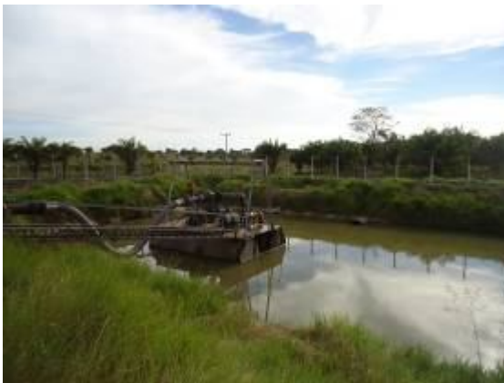
Figura 29 – Captação no Corgão.
