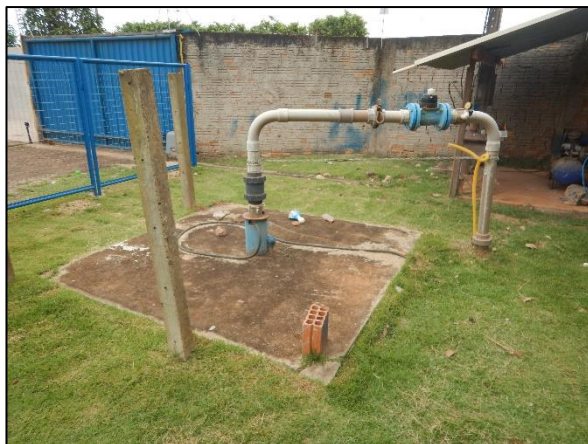
Figura 9. Poços tubulares profundos utilizados para abastecimento público em Sapezal
