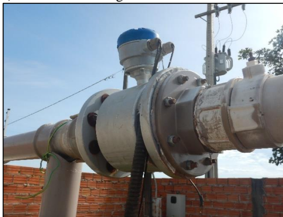
Figura 8. Tipos de macromedidores de vazão utilizados em Sapezal
