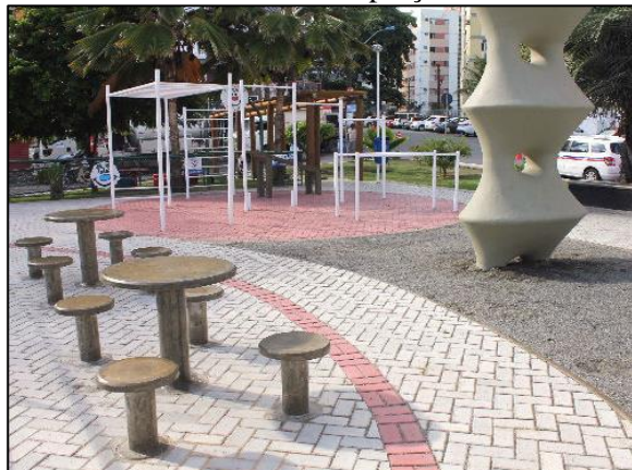
Figura 66. Pavimento poroso – piso intertravado instalado em praça
