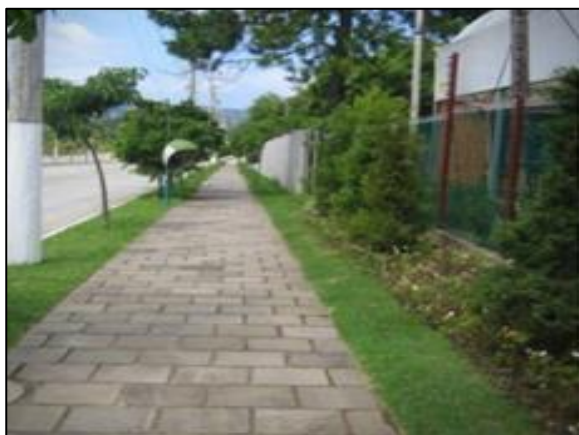
Figura 72. Vala de retenção ao longo da rua
