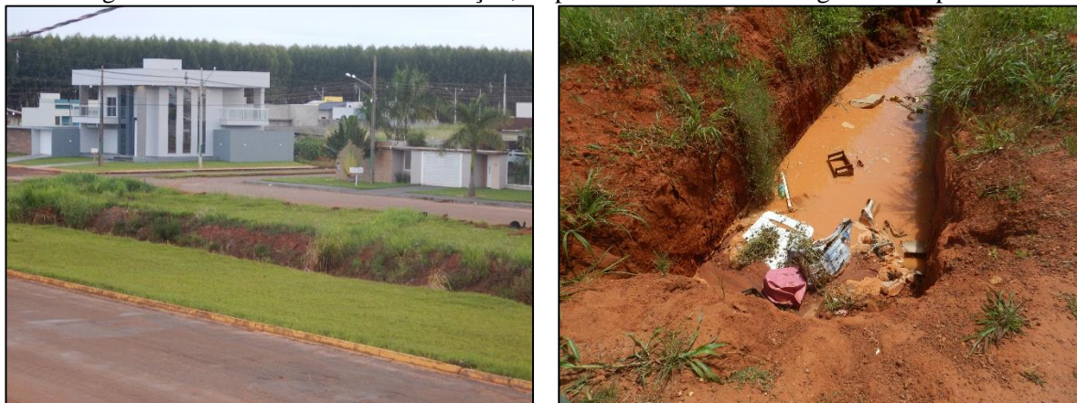
Figura 24. Vista dos valos de infiltração, dispositivos de macrodrenagem em Sapezal
