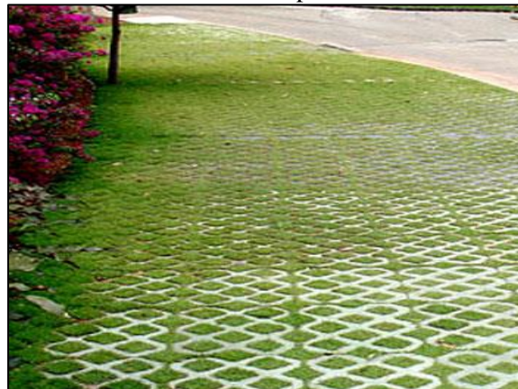
Figura 67. Pavimento poroso – concregrama instalado em passeio
