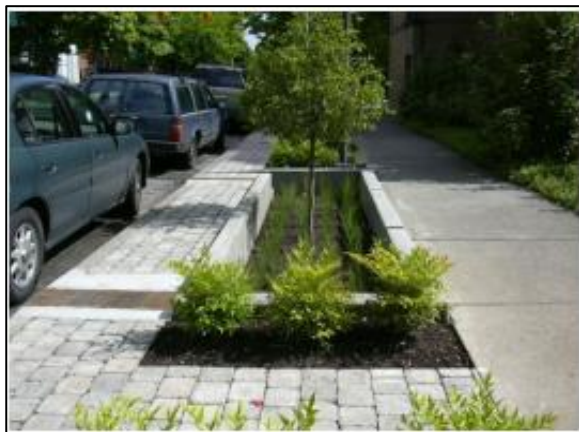
Figura 70. Trincheira de infiltração no passeio
