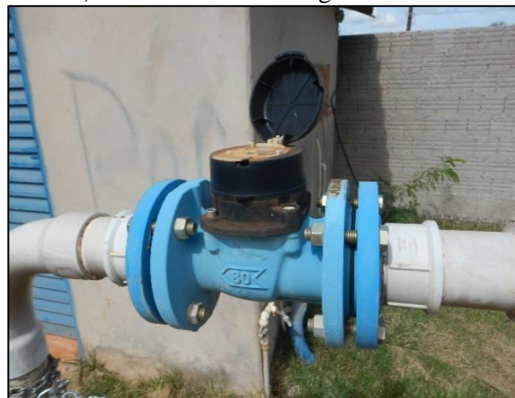
Figura 8. Tipos de macromedidores de vazão utilizados em Sapezal
