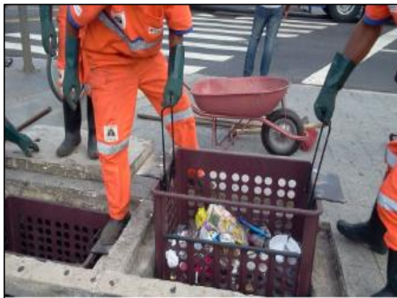
Figura 62. Cesta acoplada à boca do bueiro
