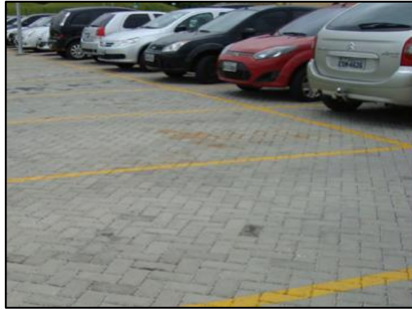
Figura 60. Pavimento poroso instalado em estacionamento
