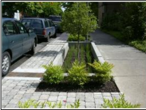
Figura 61. Trincheira de infiltração no passeio
