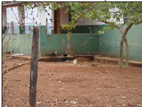
Figura 32. Vista da fossa, com suspiro
