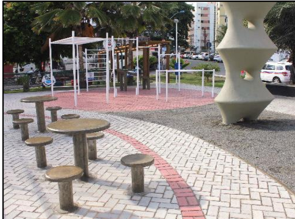
Figura 57. Pavimento poroso – piso intertravado instalado em praça
