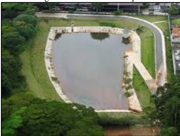
Figura 65. Bacia de retenção
