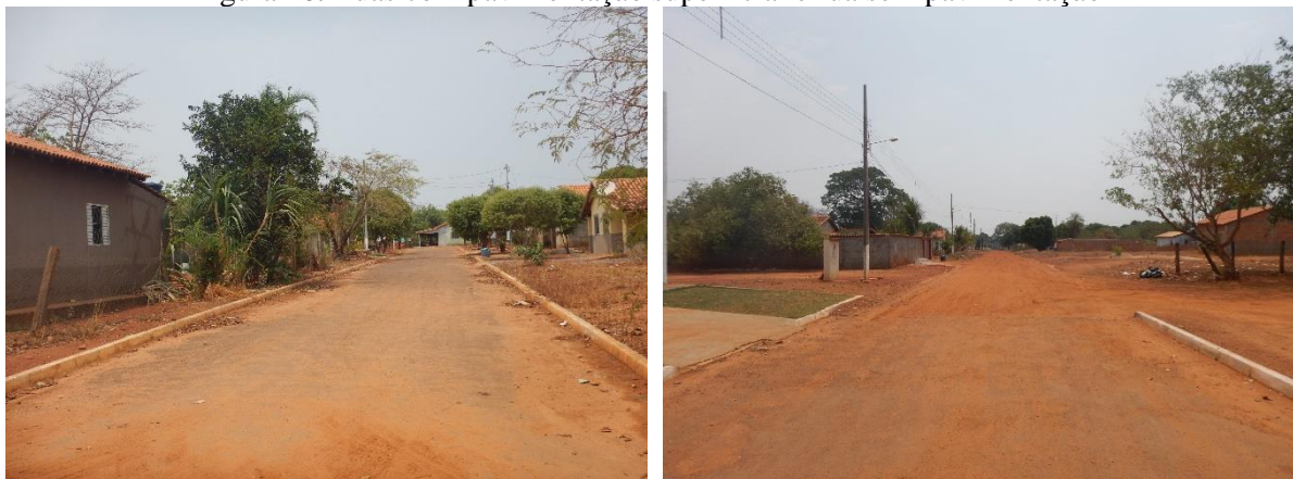
Figura 16. Ruas com pavimentação superficial e rua sem pavimentação
