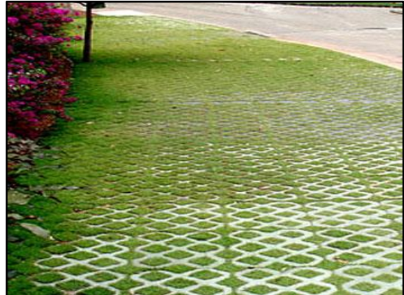
Figura 58. Pavimento poroso – concregrama instalado em passeio
