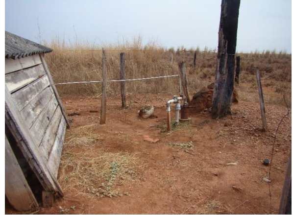
Figura 31. (A) Superfície do poço tubular com encamisamento de ferro (B) Área de proteção do poço (C) Compressor utilizado para o recalque (D) Estrutura improvisada para abrigar o compressor (E) Reservatórios instalados no PDS
