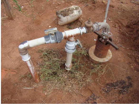
Figura 31. (A) Superfície do poço tubular com encamisamento de ferro (B) Área de proteção do poço (C) Compressor utilizado para o recalque (D) Estrutura improvisada para abrigar o compressor (E) Reservatórios instalados no PDS
