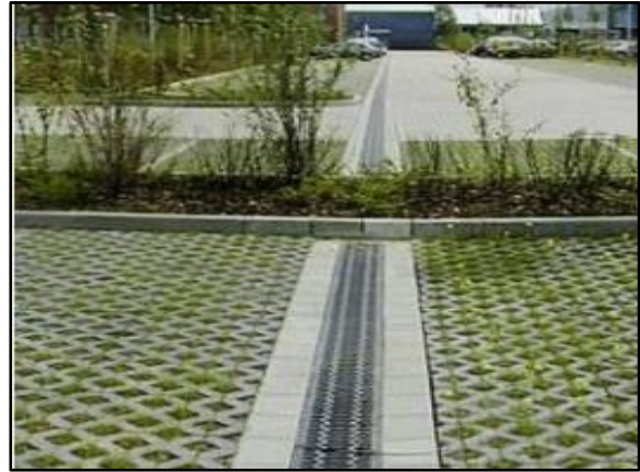
Figura 62. Trincheira de infiltração no estacionamento
