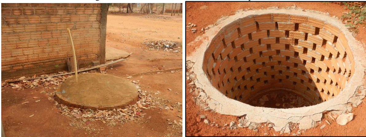
Figura 14. Sistema de tratamento individual por fossa
