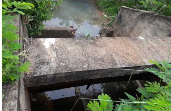
Figura 96. Dissipador de energia
