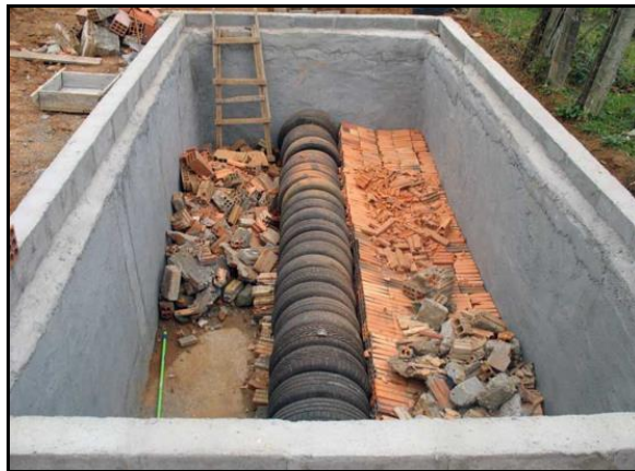
Figura 230. Método do círculo de bananeiras em execução para tratamento individual
