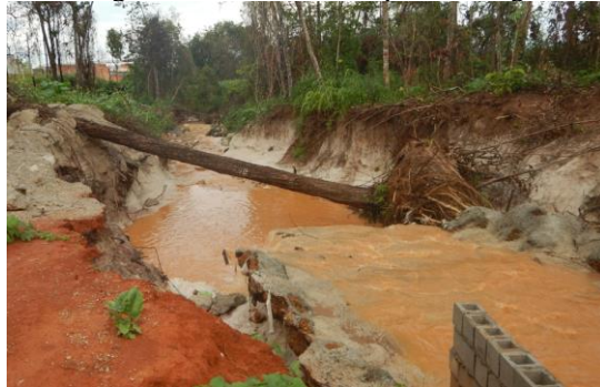
Figura 89. Erosão no rio pós-descarga
