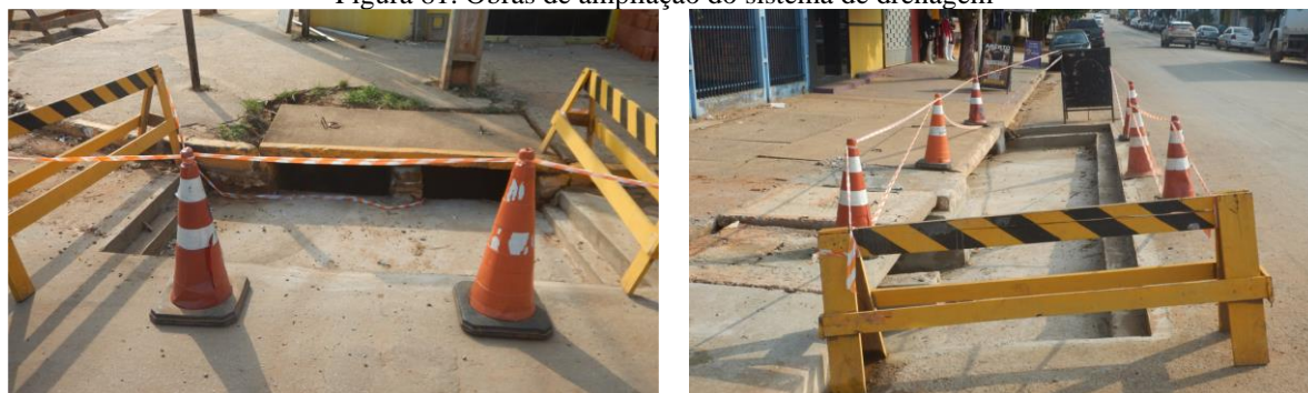
Figura 81. Obras de ampliação do sistema de drenagem
