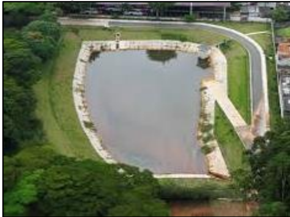
Figura 246. Bacia de detenção
