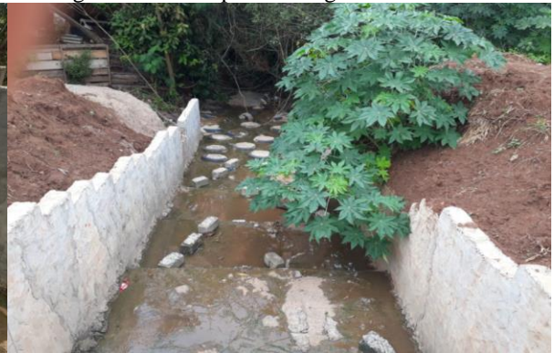
Figura 101. Dissipador energia Lot. Taiamã
