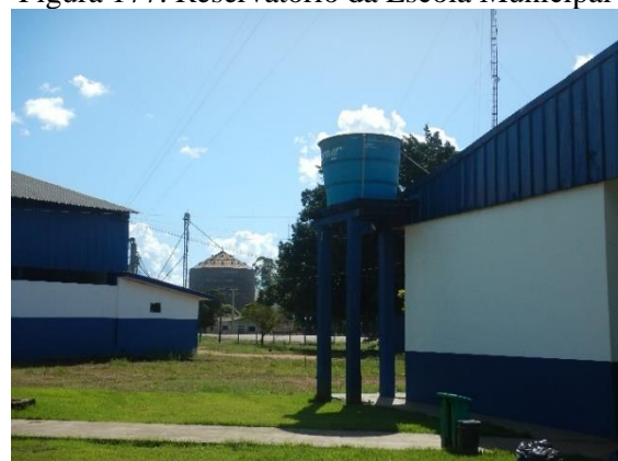
Figura 177. Reservatório da Escola Municipal
