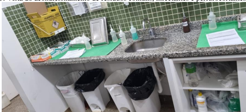
Figura 135. Vista do acondicionamento de resíduos comuns, infectantes e perfurocortantes - UPA 24h
