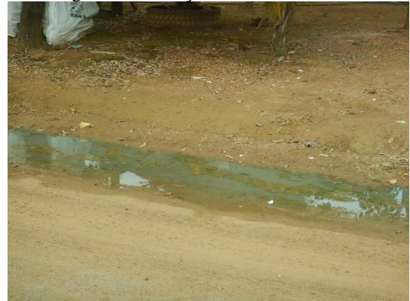
Figura 196. Lançamento à céu aberto
