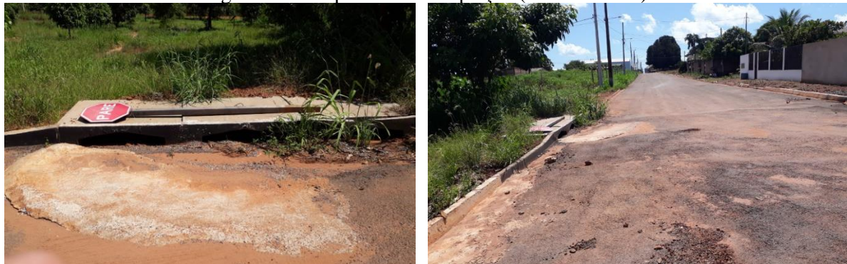
Figura 170. Dispositivos de captação (bocas de lobo)
