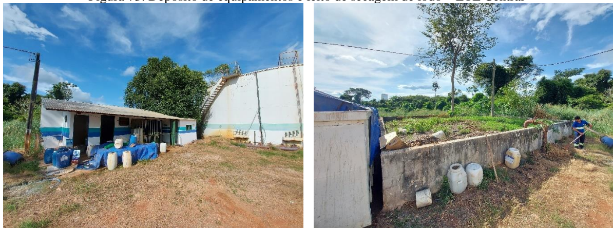
Figura 73. Depósito de equipamentos e leito de secagem de lodo – ETE Central
