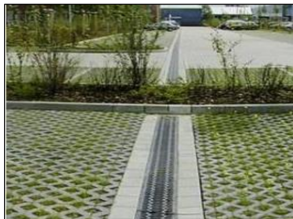
Figura 243. Trincheira de infiltração no estacionamento
