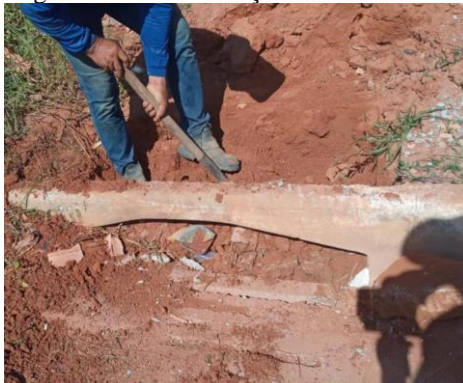
Figura 109. Desobstrução da boca de lobo
