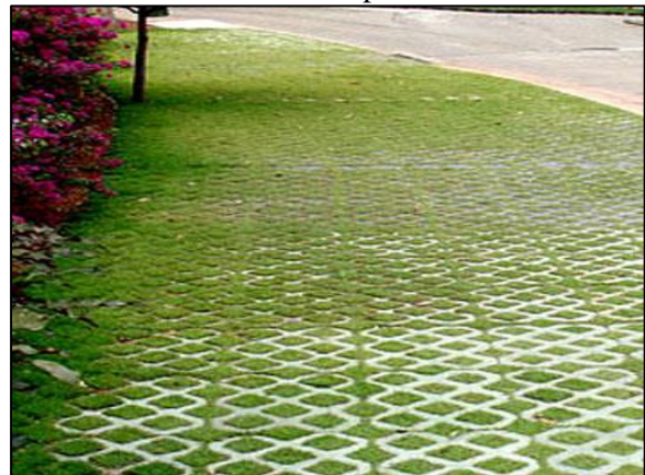
Figura 239. Pavimento poroso – concregrama instalado em passeio
