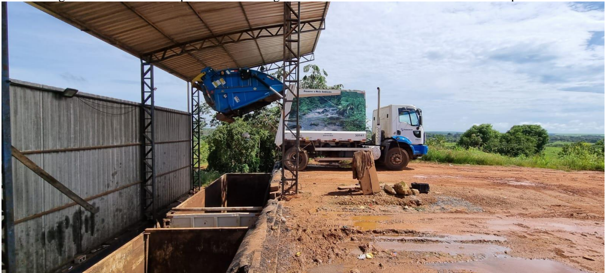
Figura 128. Veículo compactador descarregando os resíduos em containers de maior capacidade
