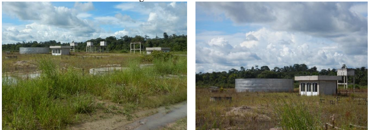
Figura 78. ETE Teles Pires
