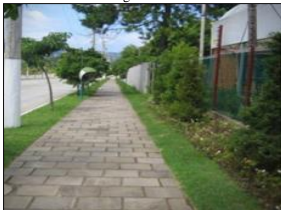
Figura 244. Vala de detenção ao longo da rua
