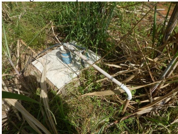
Figura 207. Poço da Escola Municipal
