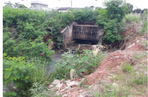
Figura 97. Dissipador de energia e entornos
