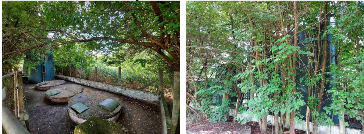
Figura 74. ETE São Francisco
