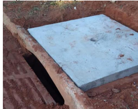
Figura 110. recuperação da boca de lobo
