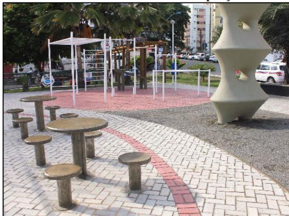
Figura 238. Pavimento poroso – piso intertravado instalado em praça
