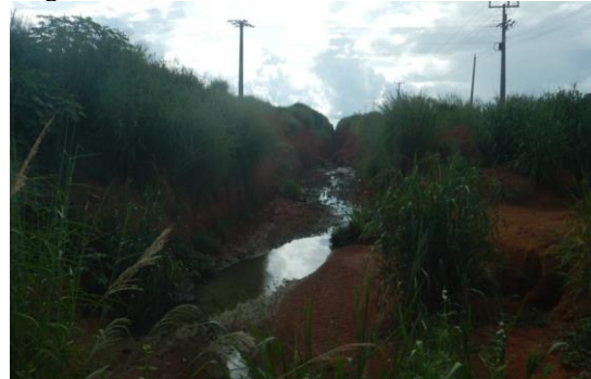
Figura 90. Trecho final do canal em terra MT-242
