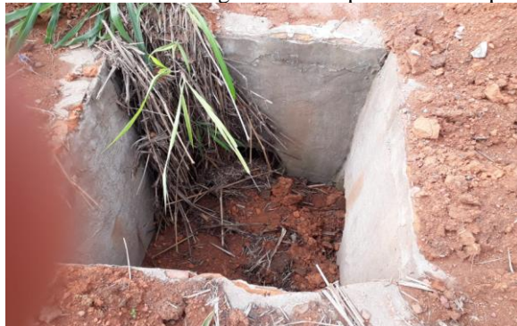
Figura 200. Dispositivos de captação com necessidade de manutenção
