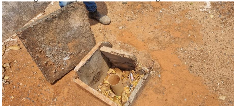
Figura 133. Poço de monitoramento de águas subterrâneas
