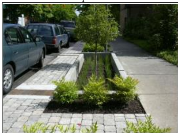
Figura 242. Trincheira de infiltração no passeio
