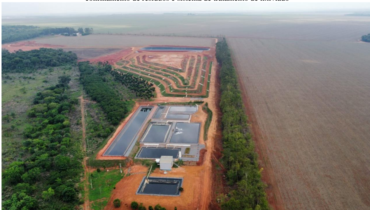
Figura 131. Imagem panorâmica da área do aterro sanitário da Sanorte-Unidade Sorriso, com vista do maciço de confinamento de resíduos e sistema de tratamento de lixiviado
