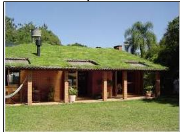
Figura 237. Telhado verde com plantas
