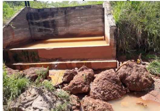
Figura 168. Dissipador de energia
