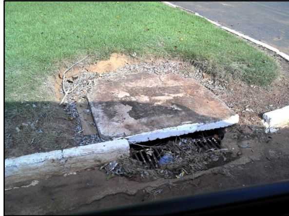
Figura 39. Boca de lobo comprometida devido ao acúmulo de sedimentos na Av. Zé Paraná, Tabaporã-MT
