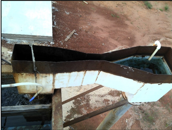
Figura 19. Calha Parshall antes da reforma da ETA 1, Tabaporã-MT
