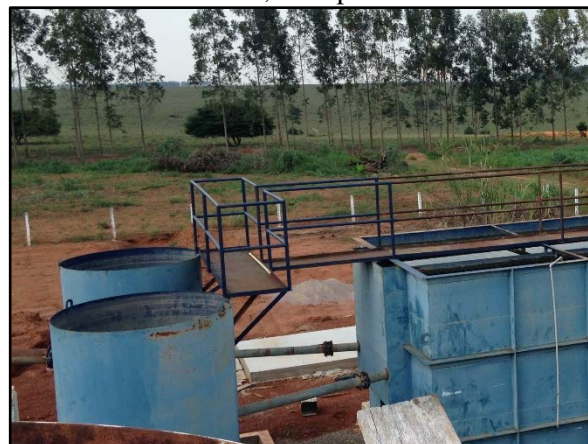
Figura 23. Filtros após o decantador, da ETA 1 metálica, Tabaporã-MT
