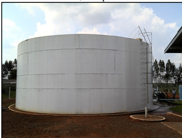
Figura 30. Reservatório R2 de 500,0 m 3 na área da ETA, Tabaporã-MT
