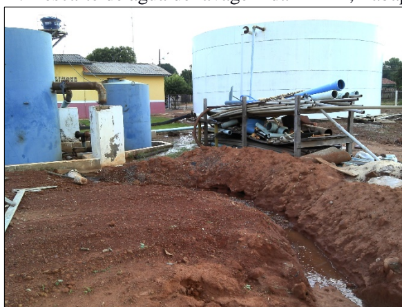
Figura 24. Descarte de água de lavagem da ETA 1, Tabaporã-MT
