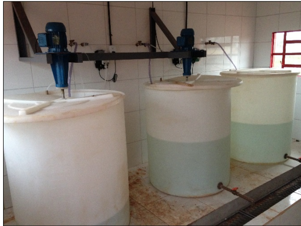
Figura 20. Tanques de diluição do SAE, Tabaporã-MT
