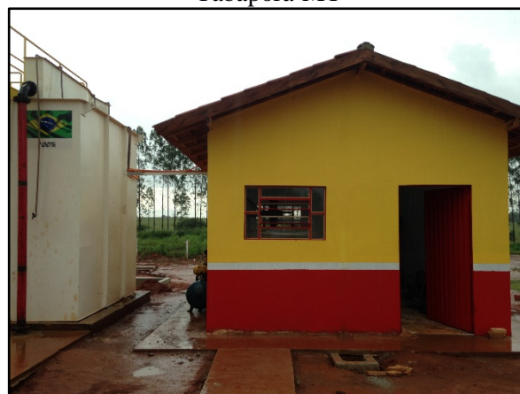
Figura 28. Casa de química no SAE de Tabaporã-MT
