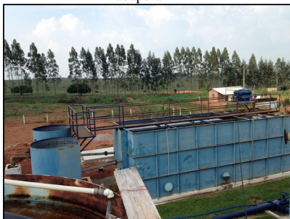
Figura 17. ETA 1 metálica antes da reforma, Tabaporã-MT
