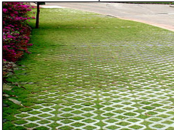
Figura 94. Pavimento poroso – concregrama instalado em passeio
