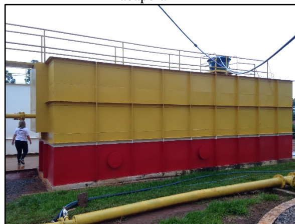
Figura 18. ETA 1 metálica em reforma, Tabaporã-MT
