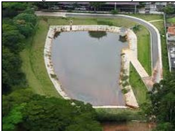
Figura 101. Bacia de detenção
