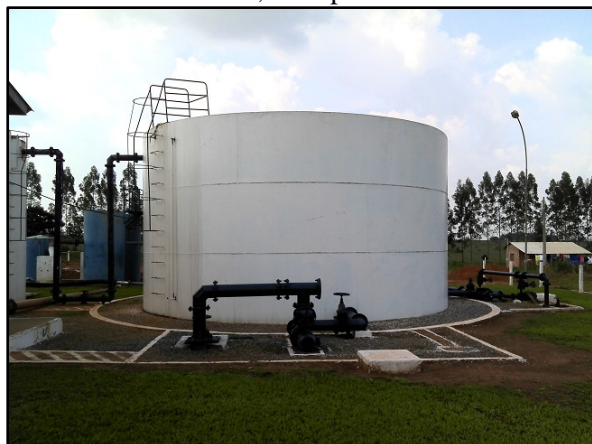
Figura 29. Reservatório R1 de 200,0 m 3 na área da ETA, Tabaporã-MT
