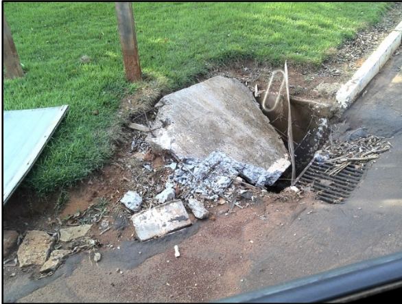
Figura 38. Boca de lobo deteriorada apresentando risco de acidente aos pedestres na Av. Zé Paraná, Tabaporã-MT
