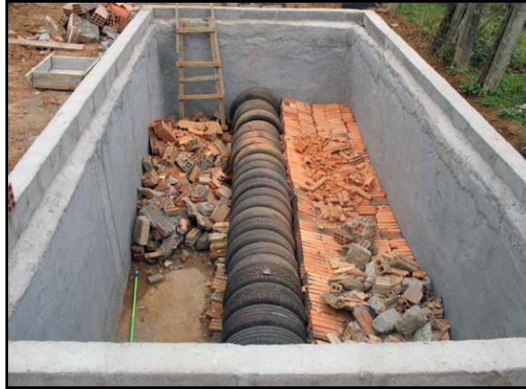
Figura 85. Método do círculo de bananeiras em execução para tratamento individual
