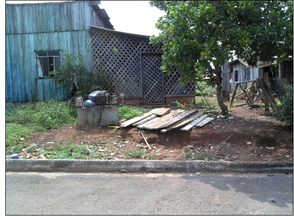
Figura 35. Fossa rudimentar locada na calçada da residência sem laje de cobertura, coberta com tábuas improvisadas
