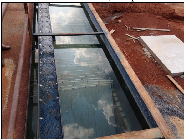
Figura 22. Vista das placas do decantador de alta taxa da ETA 1 metálica, Tabaporã-MT
