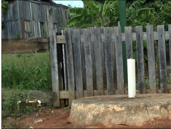
Figura 34. Fossa rudimentar ao lado da ligação de água em Tabaporã - MT
