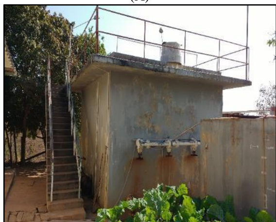
Figura 12. ETA compacta de concreto (A), metálica (B) de Torixoréu (A) (B)
