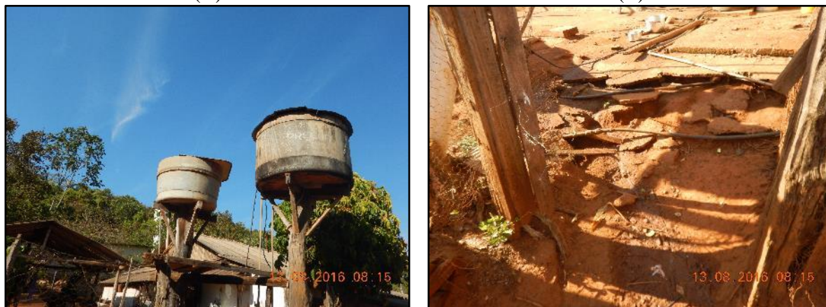
Figura 77. Caixas d'água residenciais (A), rede de distribuição por mangueiras (B)
