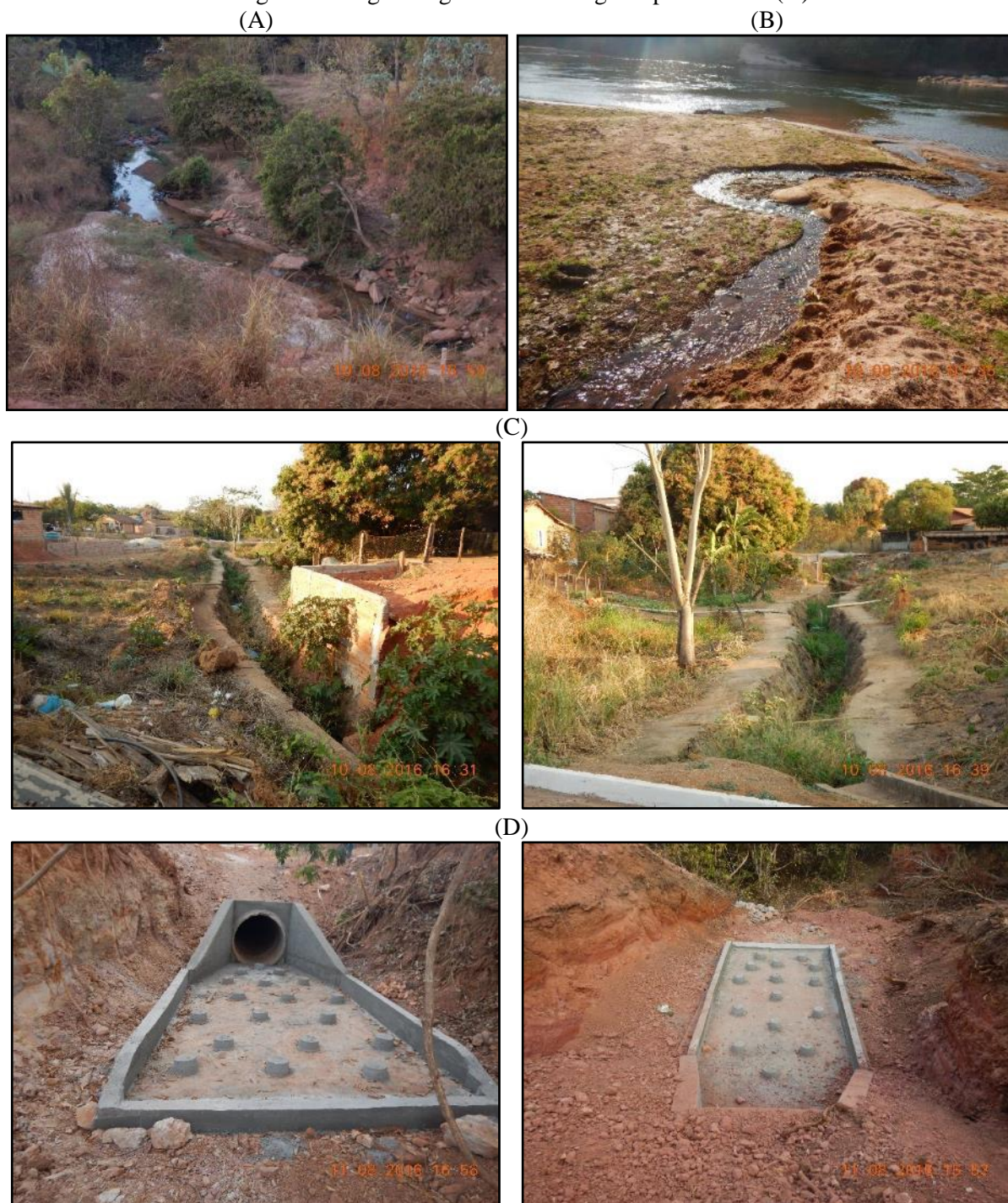
Figura 41. Córrego Capim Branco (A), córrego do Boi (B), canal existente (C), dissipadores de energia no deságue da galeria no córrego Capim Branco (D)
