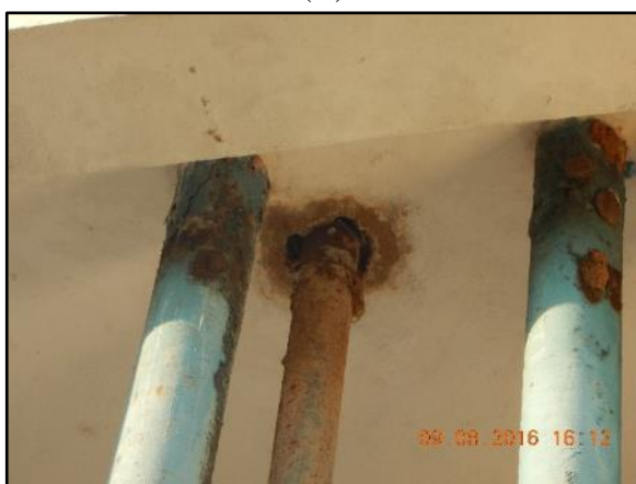
Figura 22. Corrosão nas tubulações do REL - 01 (A) e corrosão na tampa do RAP - 02 (B)
