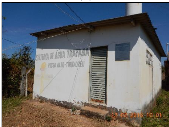
Figura 85. Abrigo para cloração desativado (A), tanque para cloração inoperante (B)
