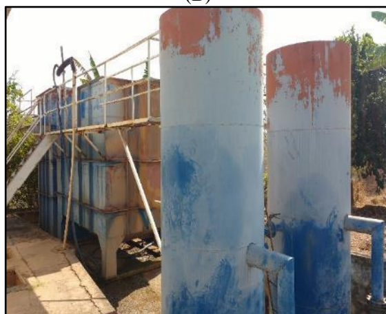
Figura 12. ETA compacta de concreto (A), metálica (B) de Torixoréu (A) (B)
