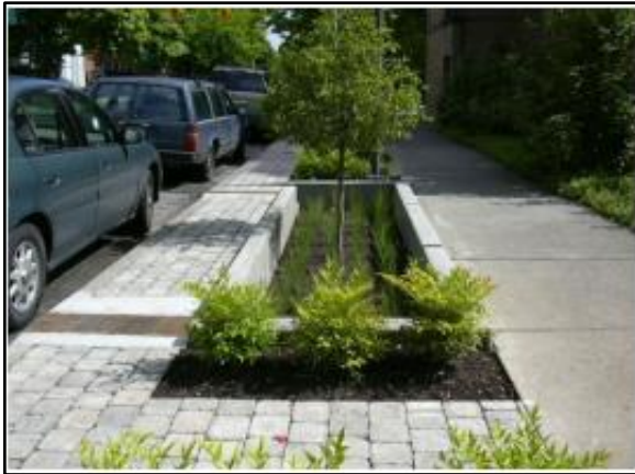
Figura 114. Trincheira de infiltração no passeio
