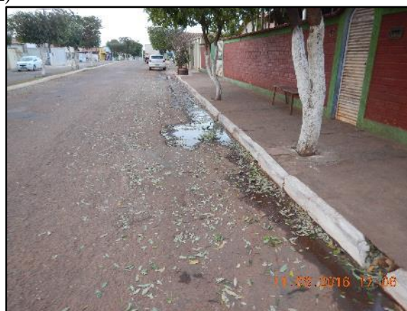
Figura 43. Microdrenagem – meio-fio e sarjeta (A), bocas de lobo e grelha (B), poço de visita (C) (A)
