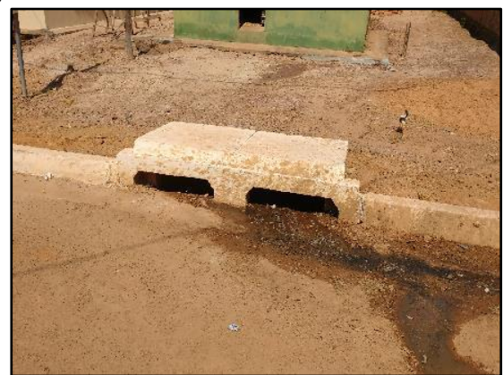
Figura 36. Esgotos in natura lançados nas sarjetas (A), esgotos in natura lançados nas grotas urbanas (B), ligações clandestinas de esgoto no canal de água pluvial (C)
