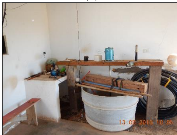
Figura 85. Abrigo para cloração desativado (A), tanque para cloração inoperante (B)
