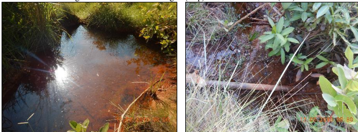
Figura 74. Vista da mina d'água (esq.) e trecho da adutora (dir.)
