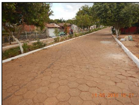
Figura 43. Microdrenagem – meio-fio e sarjeta (A), bocas de lobo e grelha (B), poço de visita (C) (A)
