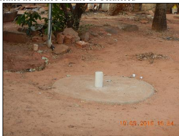
Figura 37. Vista da laje de fossas existentes no núcleo urbano de Torixoréu
