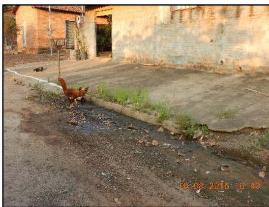
Figura 36. Esgotos in natura lançados nas sarjetas (A), esgotos in natura lançados nas grotas urbanas (B), ligações clandestinas de esgoto no canal de água pluvial (C)
