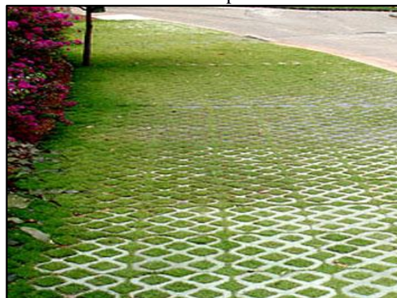
Figura 111. Pavimento poroso – concregrama instalado em passeio
