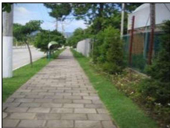
Figura 116. Vala de detenção ao longo da rua
