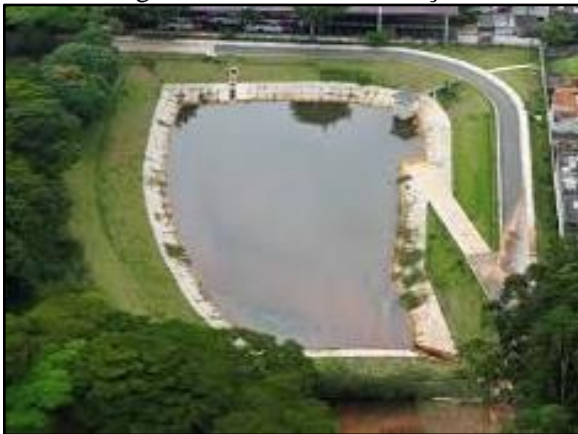
Figura 118. Bacia de detenção
