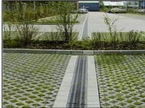
Figura 115. Trincheira de infiltração no estacionamento
