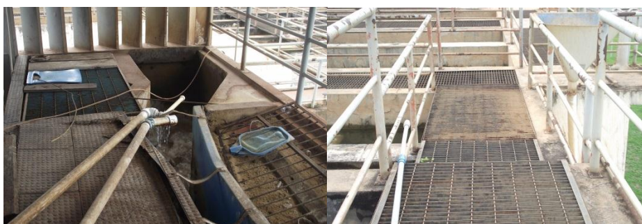
Figura 18 - Calha Parshall e Infraestrutura - Corrimões
