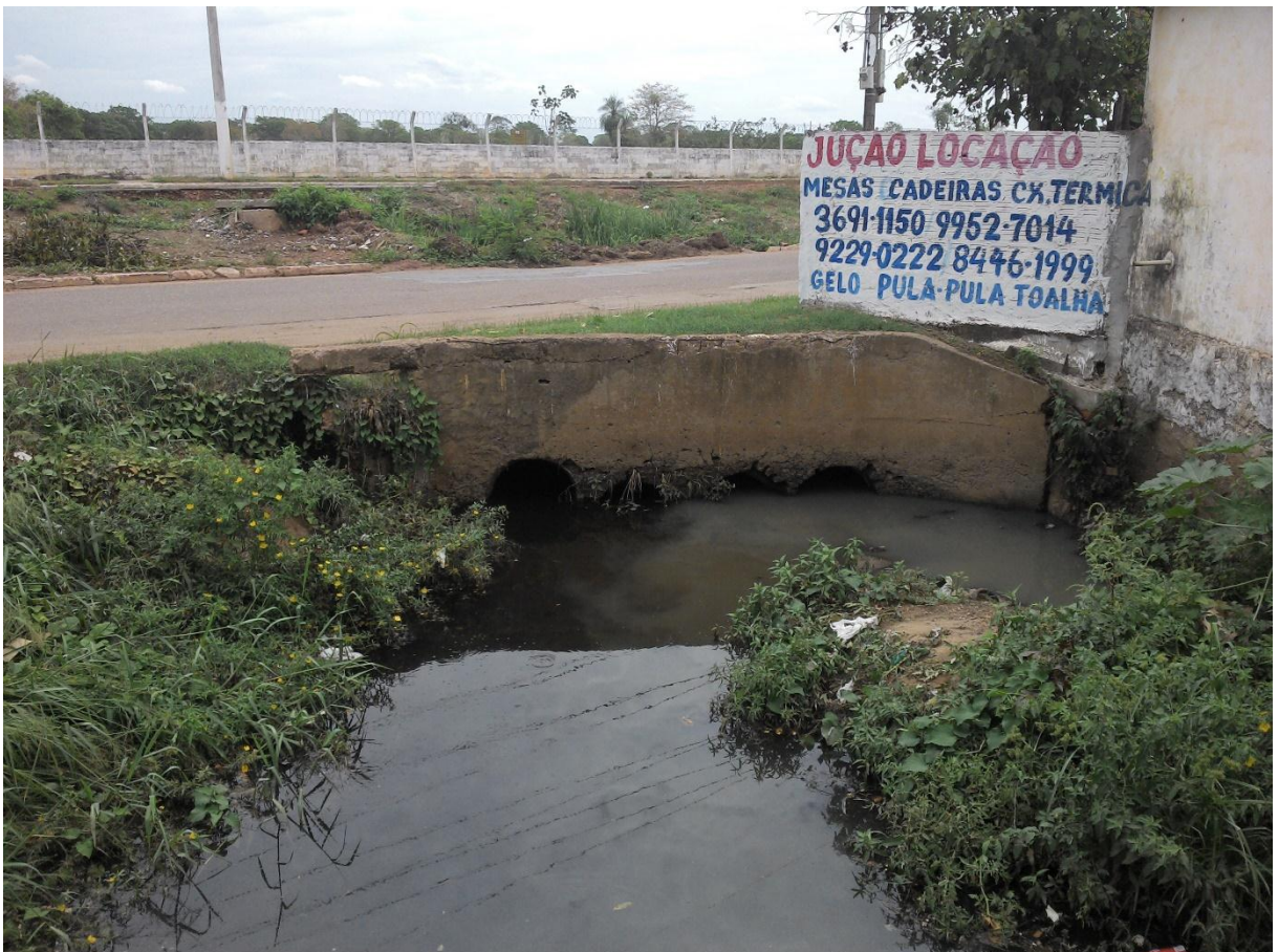
Figura 5 - Bueiro Sob Rua São Gonçalo - Coord. UTM 8266779N, 596797L
