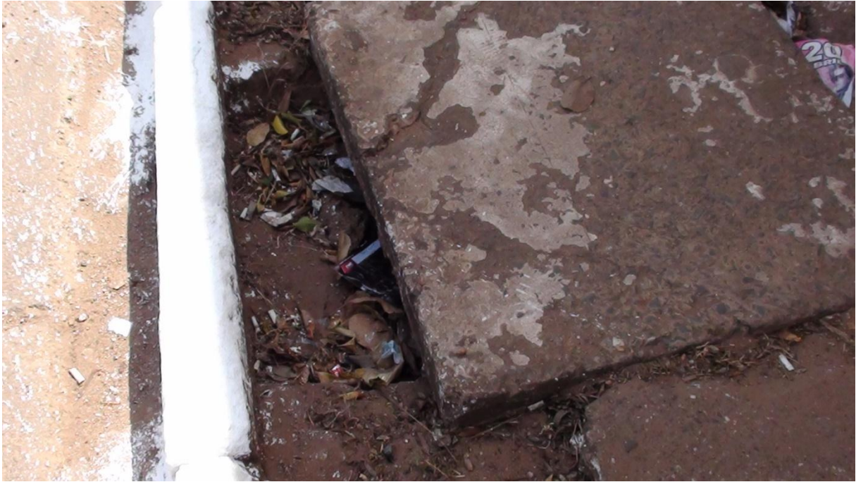
Figura 2 - Boca de Lobo com Reduzida Seção de Entrada de Água (Av. Alzira Santana) - Coord. UTM 8267697N, 592909L
