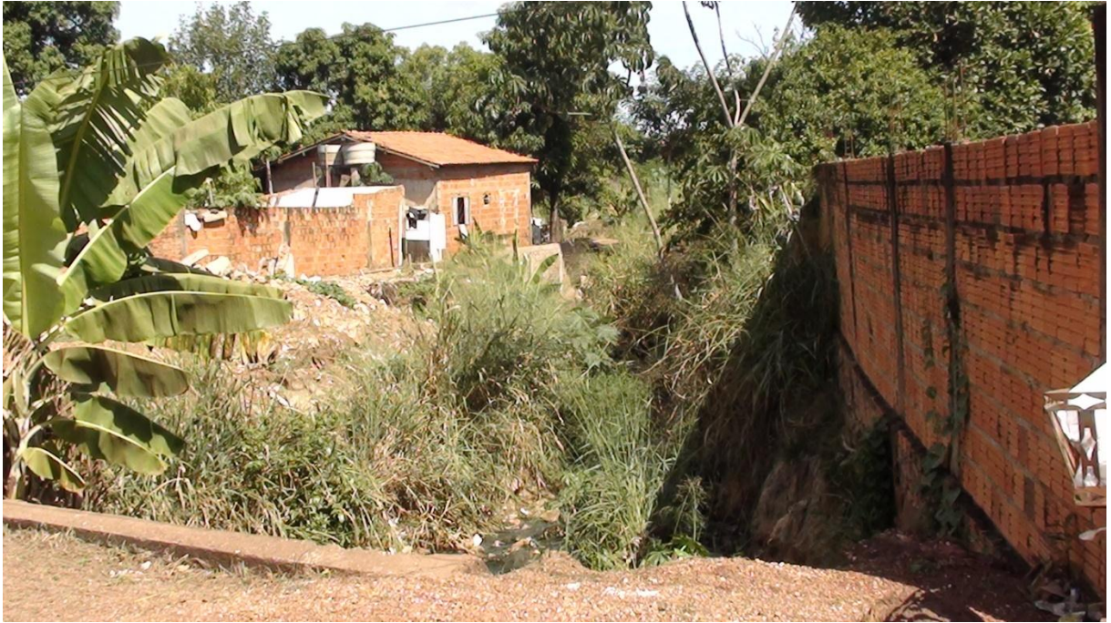
Figura 10 - Residências Próximas de Curso D'água – Coord. UTM 8268974N, 591264L
