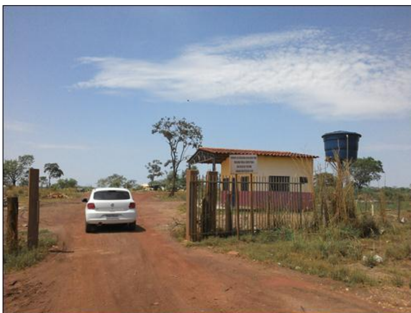
Figura 7 - Guarita do Aterro Controlado sem Controle de Acesso
