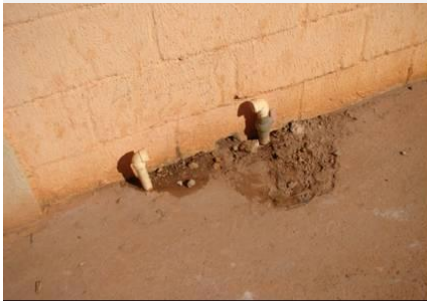
Figura 3 - Residência com ligação cortada e em uso.
