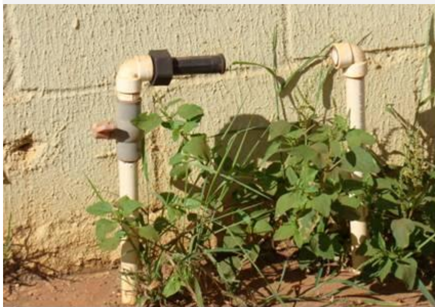
Figura 4 - Ligação predial cortada e em uso.
