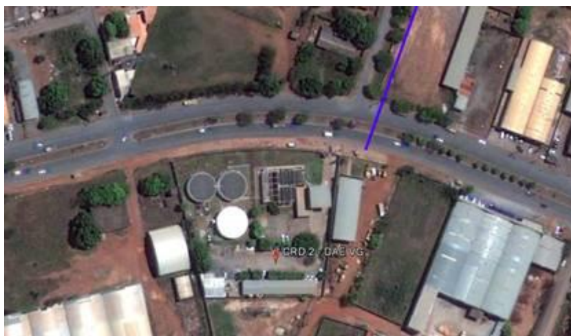
Figura 14 - localização da ETA 2 e chegada da adutora existente
