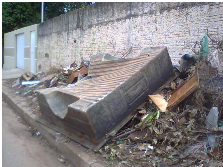
Figura 5 - Resíduos de demolição civil dispostos sobre passeio
