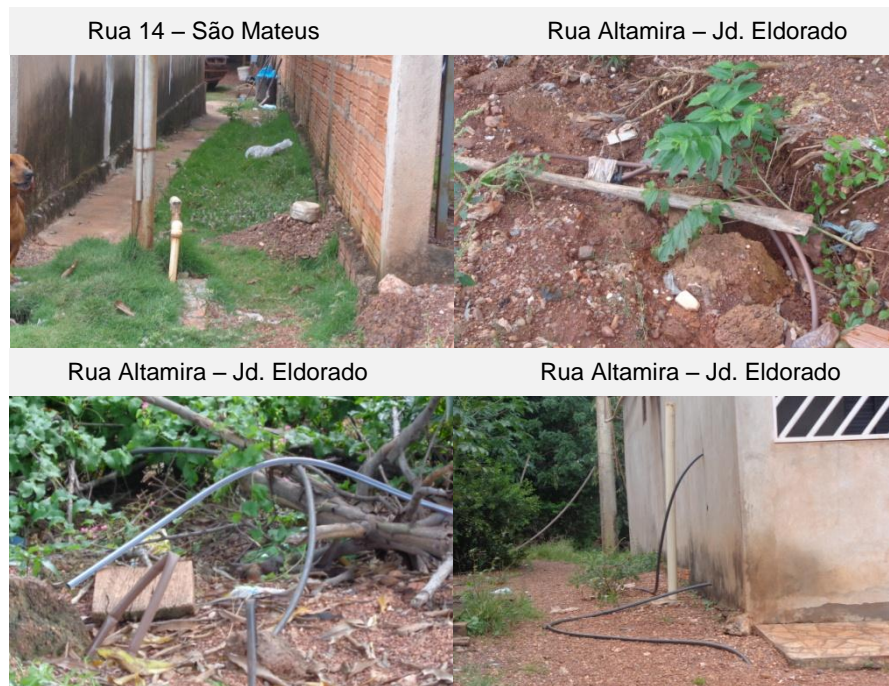
Figura 25 - Exemplos de ligações de unidades habitacionais ao sistema de abastecimento de água na região oeste.
