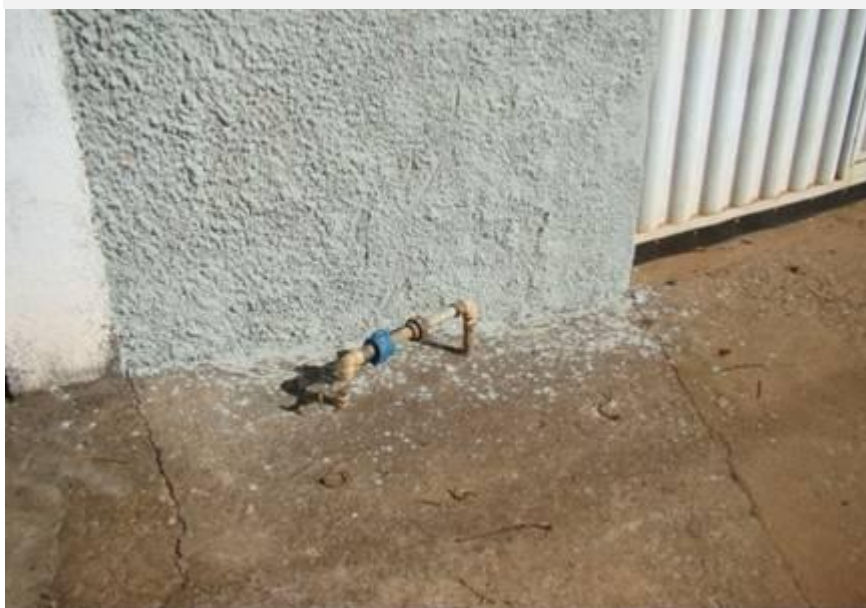
Figura 6 – Ligação predial sem hidrômetro
