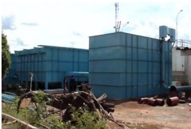
Figura 19 – ETA Compacta
