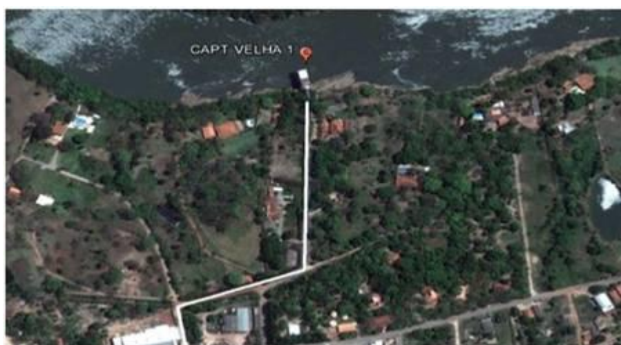
Figura 8 - Captação ETA 1 e adutora 2Ø500mm
