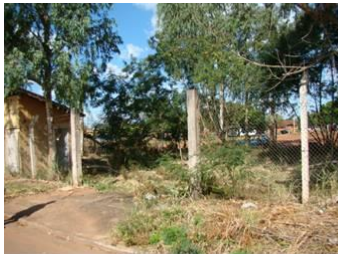
Figura 16 - Núcleo Habitacional Ataíde Monteiro – Sub-bacia 02 - Sistema fossa/filtro desativado.
