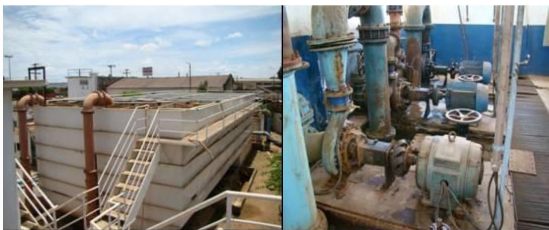
Figura 11 - Vista da ETA 1 – parte compacta e casa de bombas
