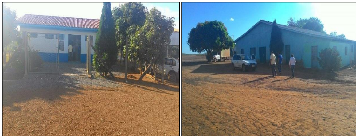
Figura 28 - Posto de Saúde do Assentamento Califórnia.
