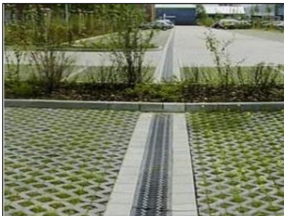
Figura 119. Trincheira de infiltração no estacionamento
