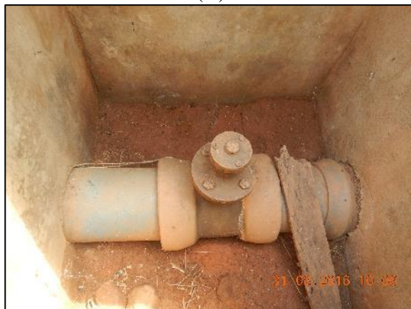
Figura 15. Ventosa (A), registro e válvula de retenção (B)
