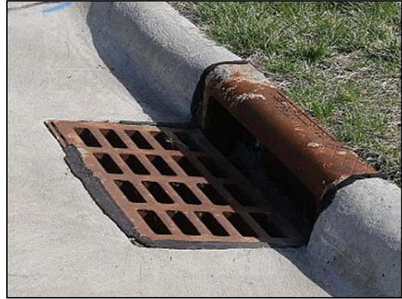
Figura 111. Boca de lobo com gradeamento na sarjeta
