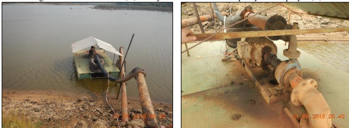
Figura 11. Balsa flutuante (A) e conjunto motobomba em operação na captação (B)
