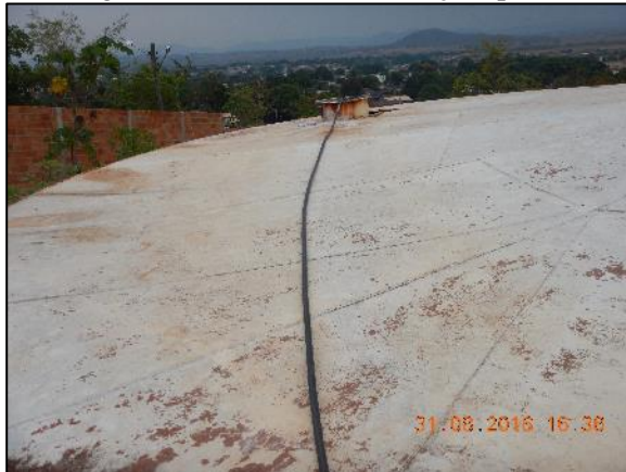
Figura 21. Detalhe da tubulação que encaminha a solução de hipoclorito até o reservatório
