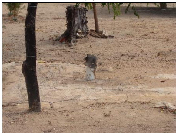
Figura 97. Vista da laje de proteção da fossa, com suspiro, na comunidade São José (A), vista de suspiro de uma fossa negra, na comunidade Vila da Paz (B)
