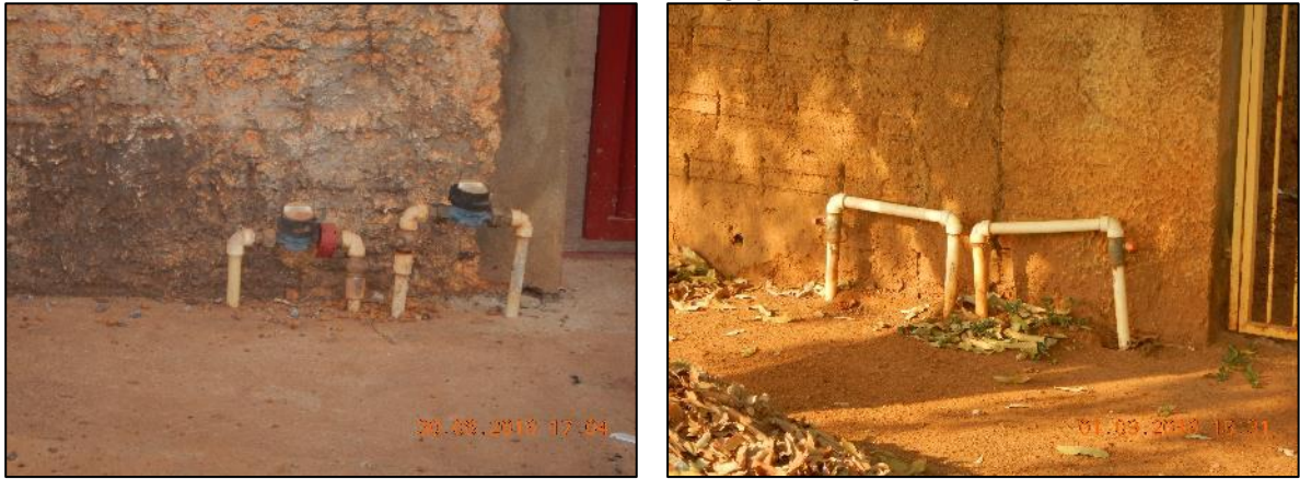
Figura 26. Ligações domiciliares observadas no núcleo urbano de Vila Rica, com hidrômetro (A), somente com cavalete (B) e ligação irregular (C)
