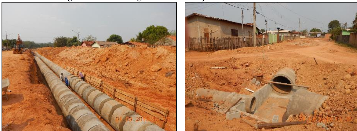
Figura 46. Trecho de galerias em execução no bairro Cidade Jardim
