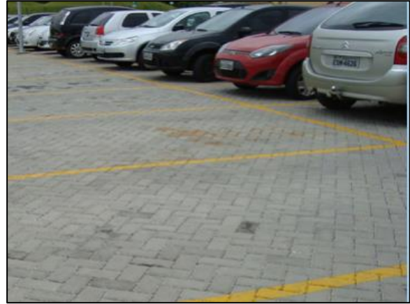
Figura 117. Pavimento poroso instalado em estacionamento
