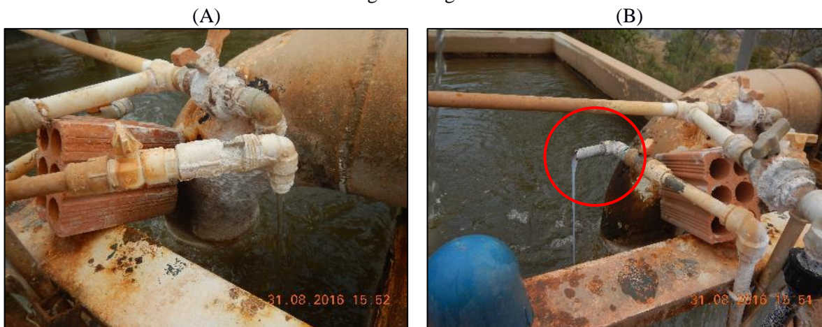
Figura 18. Aplicação da solução de sulfato de alumínio (A) e aplicação do polímero (B) no floculador na chegada da água bruta
