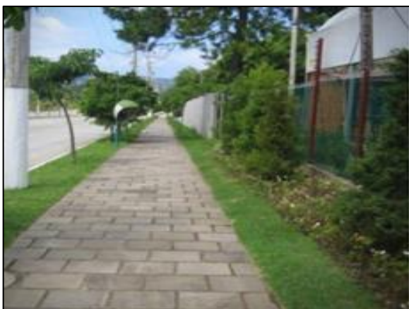
Figura 120. Vala de retenção ao longo da rua
