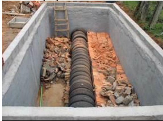
Figura 106. Método do círculo de bananeiras em execução para tratamento individual
