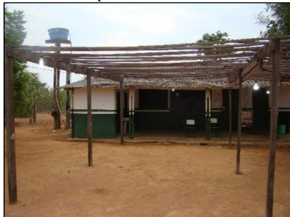
Figura 86. Escola municipal na comunidade Vila da Paz - Vila Rica
