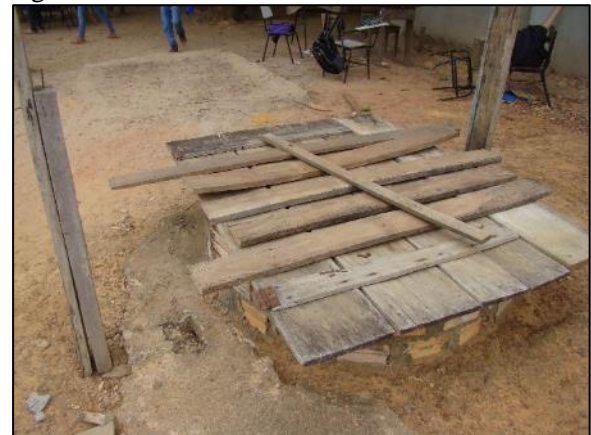
Figura 96. Poços-cacimba para abastecimento de água na comunidade Carmelita, Vila Rica-MT
