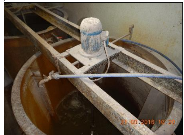
Figura 22. Tanques de preparo das soluções de sulfato de alumínio e detalhe dos agitadores (A), bomba centrífuga (B), tanque do polímero (C) e tanque do hipoclorito de cálcio (D)
