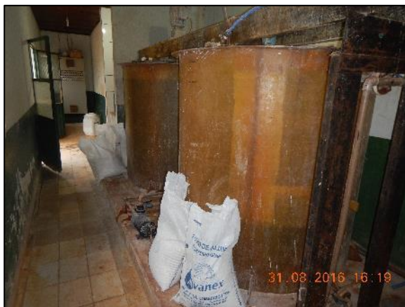
Figura 22. Tanques de preparo das soluções de sulfato de alumínio e detalhe dos agitadores (A), bomba centrífuga (B), tanque do polímero (C) e tanque do hipoclorito de cálcio (D)
