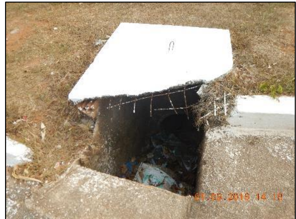
Figura 53. Bocas de lobo com resíduos (A) e bocas de lobo danificadas (B) (A)
