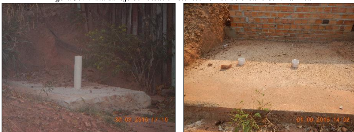
Figura 37. Vista da laje de fossas existentes no núcleo urbano de Vila Rica
