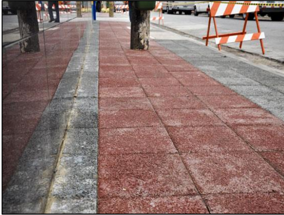
Figura 116. Pavimento poroso – piso intertravado instalado em passeio público
