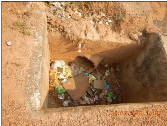
Figura 53. Bocas de lobo com resíduos (A) e bocas de lobo danificadas (B) (A)
