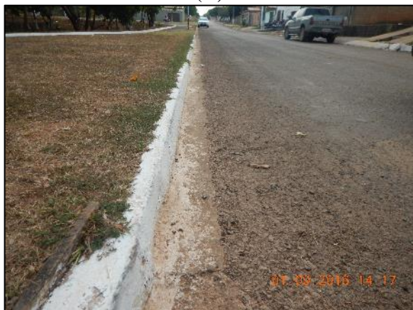
Figura 45. Dispositivos de microdrenagem existente no núcleo urbano de Vila Rica, meio fio e sarjeta (A), boca de lobo (B), poço de visita (C) e dissipador de energia bairro Cidade Jardim
