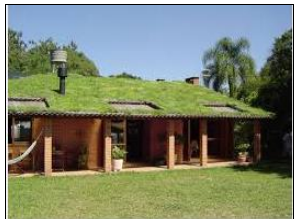
Figura 113. Telhado verde com plantas
