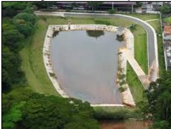
Figura 122. Bacia de detenção
