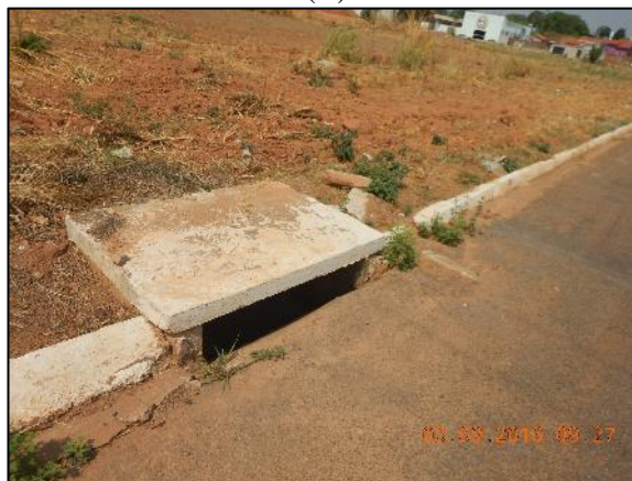
Figura 45. Dispositivos de microdrenagem existente no núcleo urbano de Vila Rica, meio fio e sarjeta (A), boca de lobo (B), poço de visita (C) e dissipador de energia bairro Cidade Jardim
