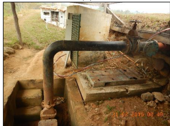
Figura 15. Ventosa (A), registro e válvula de retenção (B)
