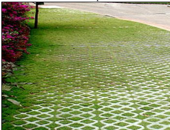
Figura 115. Pavimento poroso – concregrama instalado em passeio
