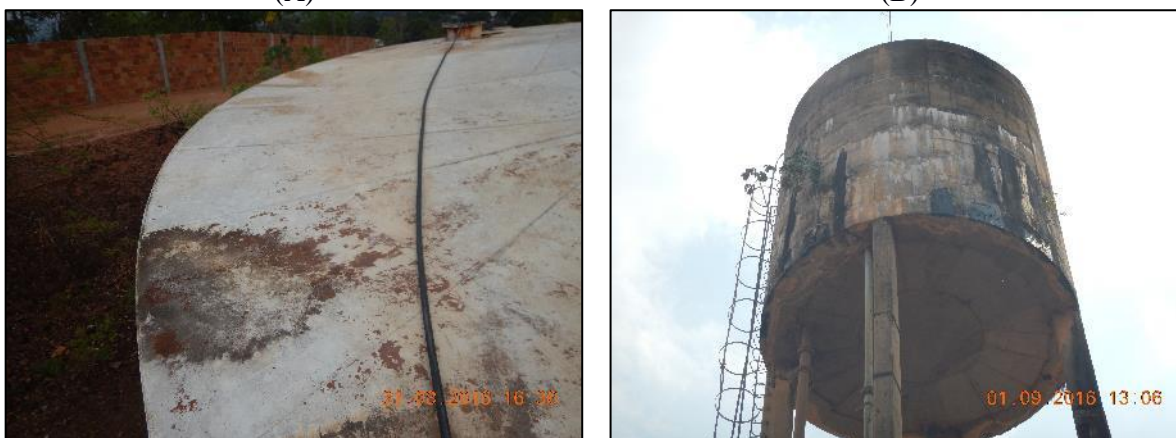
Figura 24. Problemas observados nos reservatórios RAP-01 (A) e REL-01 (B) (A) (B)
