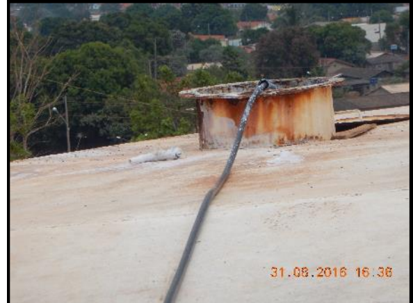
Figura 21. Detalhe da tubulação que encaminha a solução de hipoclorito até o reservatório
