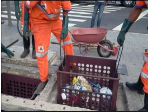
Figura 110. Cesta acoplada à boca do bueiro
