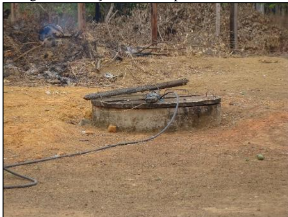
Figura 96. Poços-cacimba para abastecimento de água na comunidade Carmelita, Vila Rica-MT
