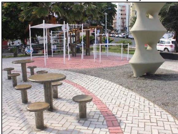
Figura 114. Pavimento poroso – piso intertravado instalado em praça
