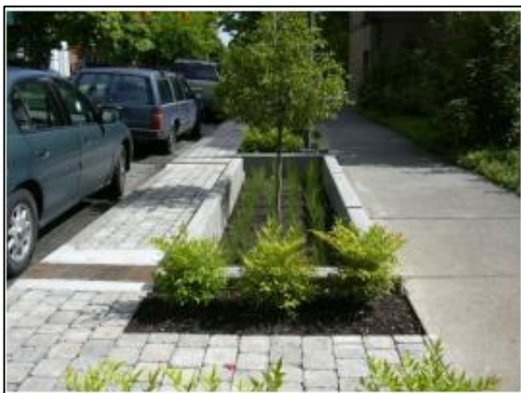
Figura 118. Trincheira de infiltração no passeio
