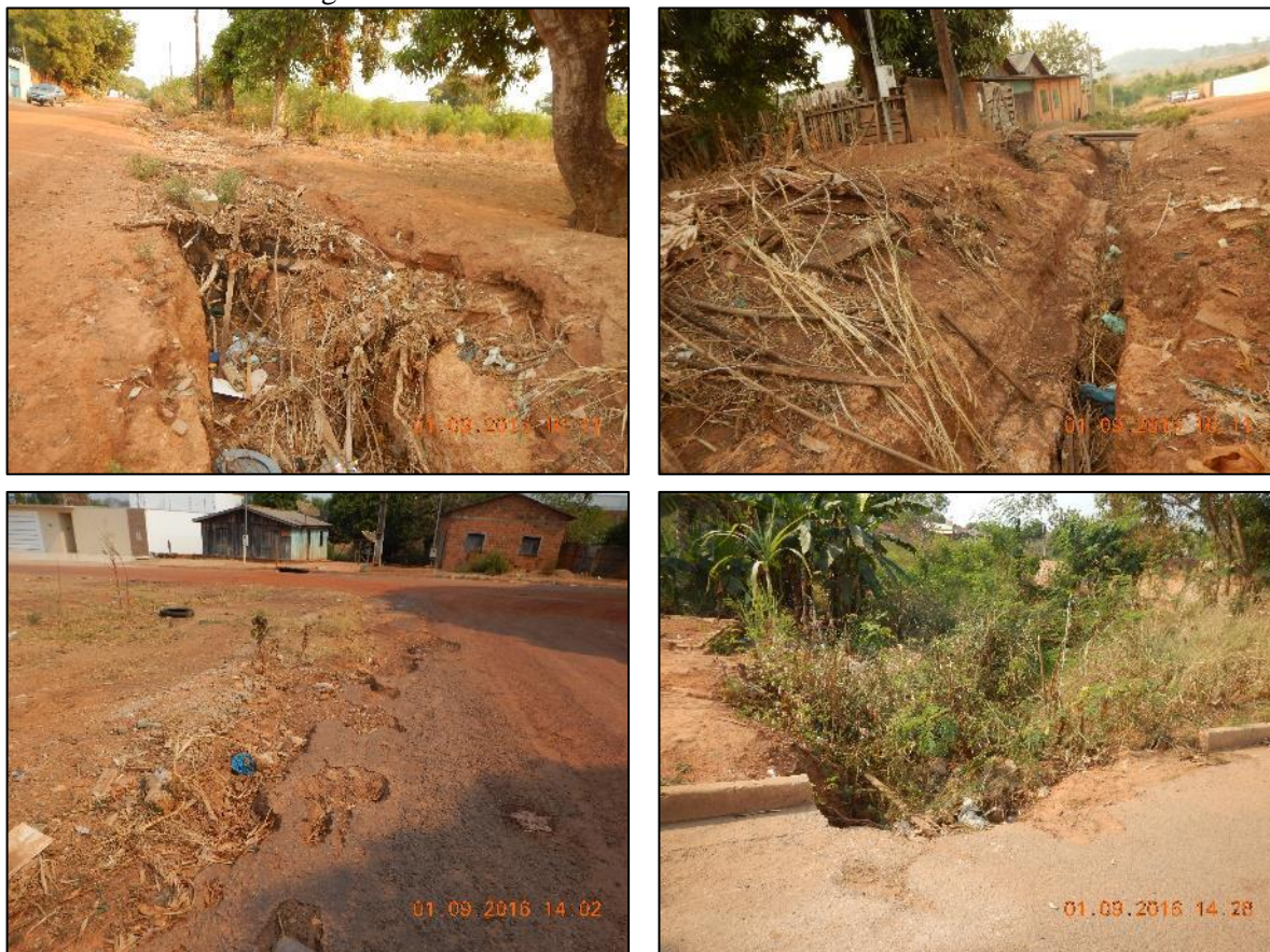
Figura 54. Vias com erosões decorrentes de enxurradas
