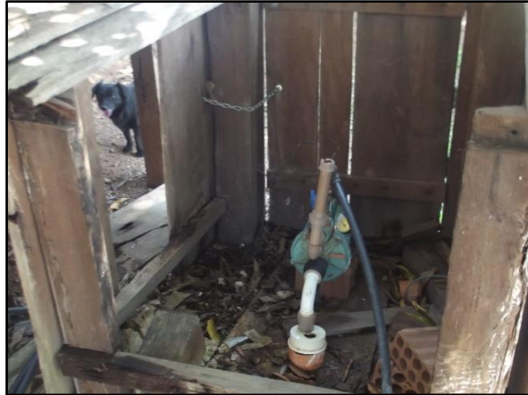
Figura 97. Vista da boca do poço tubular e da bomba de eixo horizontal, Iracema 1, Juína-MT
