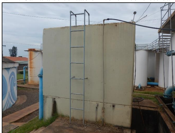
Figura 14. Câmara de contato e nível em concreto da ETA I
