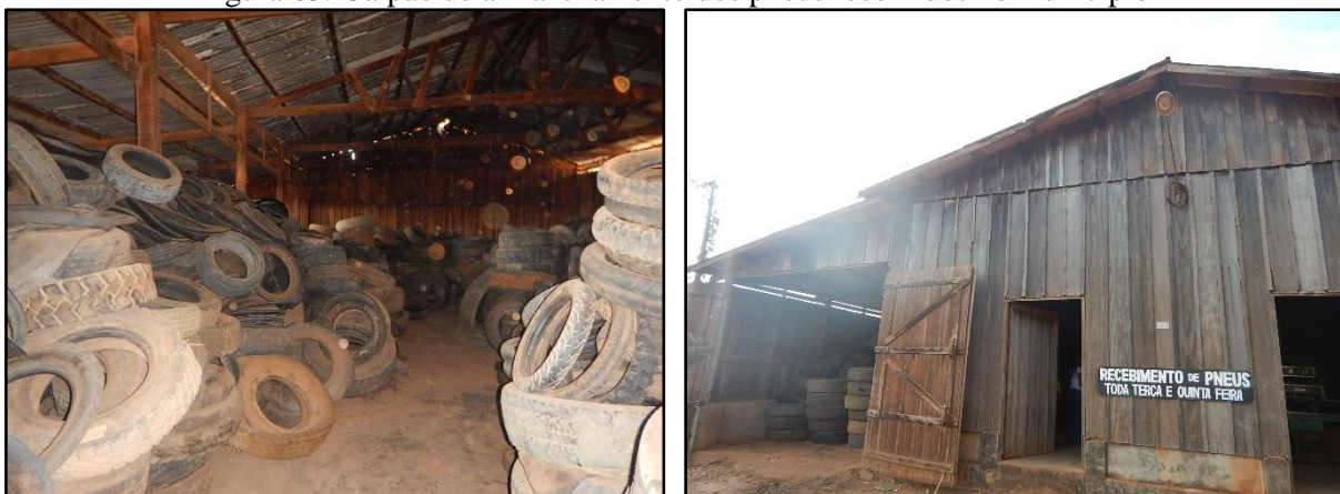
Figura 65. Galpão de armazenamento dos pneus recolhidos no município
