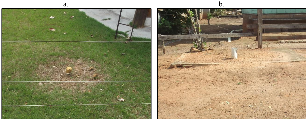
Figura 75. Vista exterior de fossa coberta com suspiro (a e b), Fontanillas, Juína-MT
