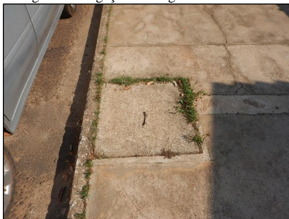
Figura 32. Ligações de esgoto em Juína-MT
