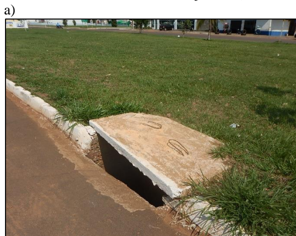
Figura 45 Componentes do sistema de drenagem: a) boca de lobo b) boca de lobo com grelha c) sarjetões d) boca de lobo meio-fio e sarjeta
