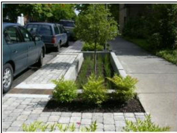
Figura 140. Trincheira de infiltração no passeio
