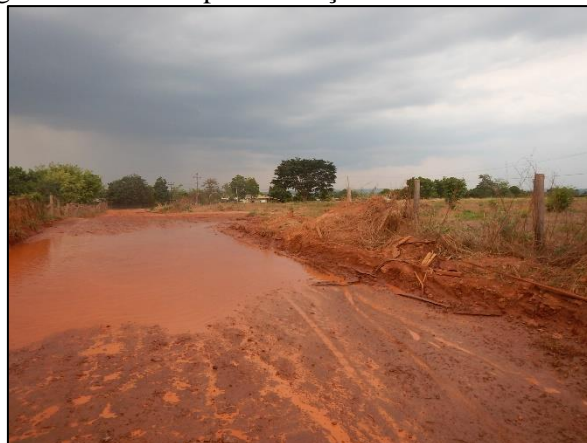
Figura 49. Via sem pavimentação com acúmulo de água
