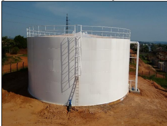
Figura 25. Reservatório metálico apoiado de 2.000 m 3
