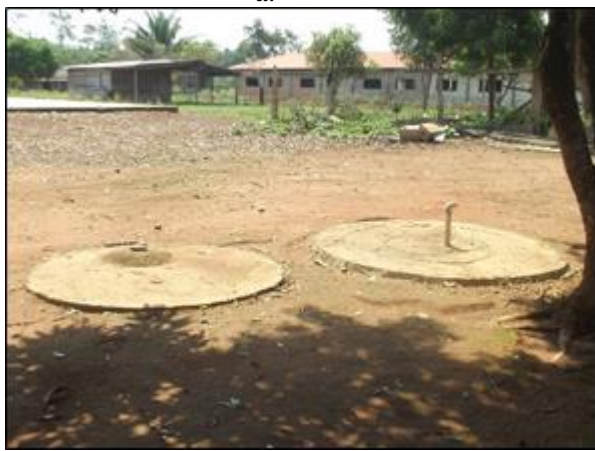
Figura 83. Vista exterior de fossa e sumidouro (a) e fossa com suspiro (b), Filadélfia, Juína-MT
