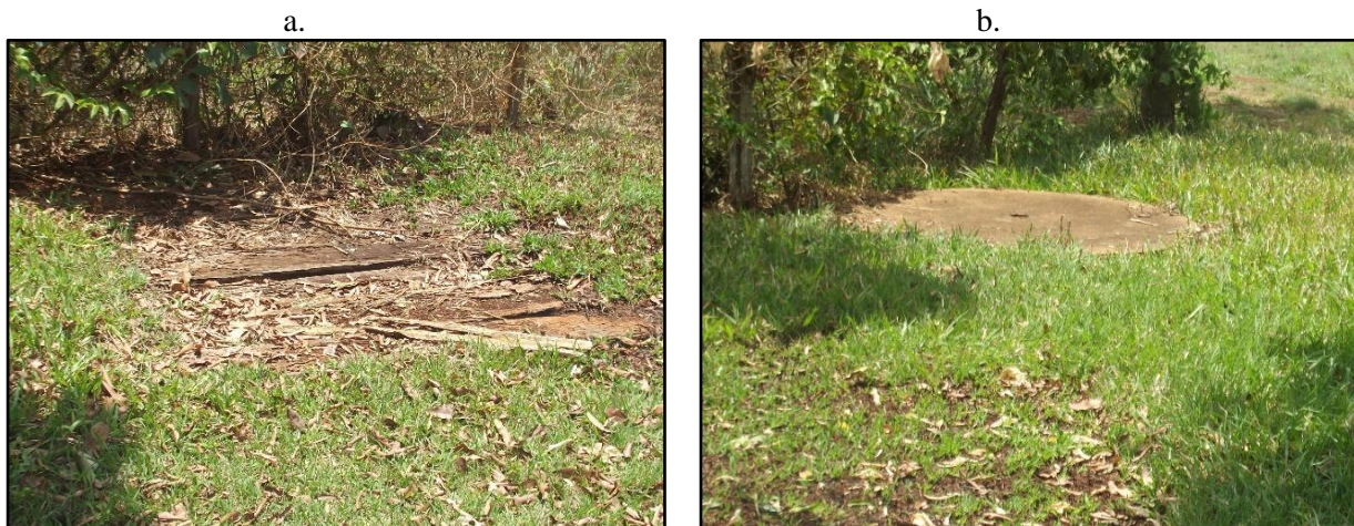
Figura 91. Vista exterior de fossa com cobertura de madeira (a) e fossa sem suspiro (b), Terra Roxa, Juína-MT
