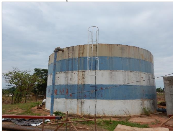
Figura 24. Reservatório apoiado em concreto armado de 350 m 3
