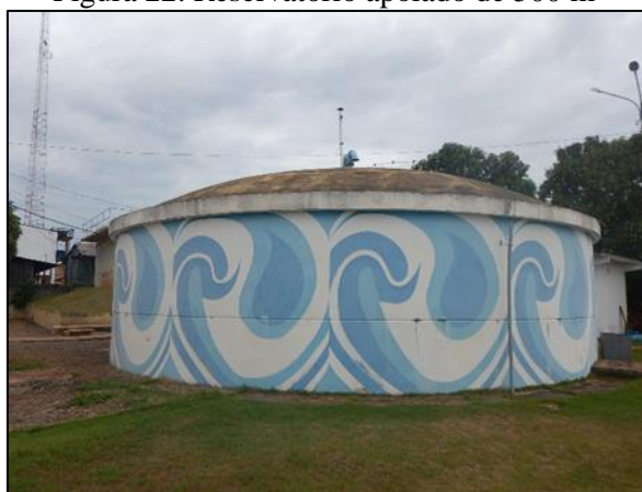
Figura 22. Reservatório apoiado de 500 m 3
