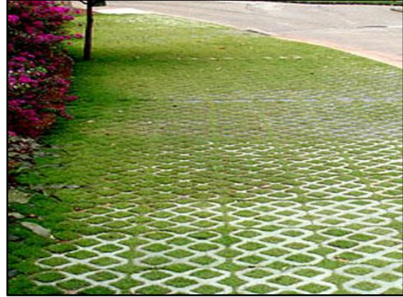
Figura 137. Pavimento poroso – concregrama instalado em passeio
