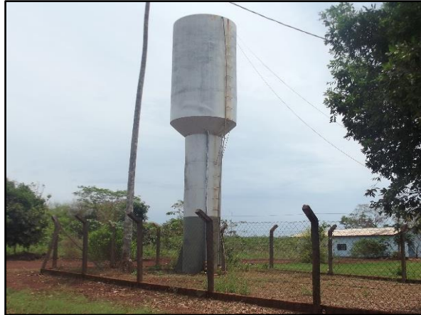
Figura 89. Reservatório elevado, Terra Roxa, Juína-MT
