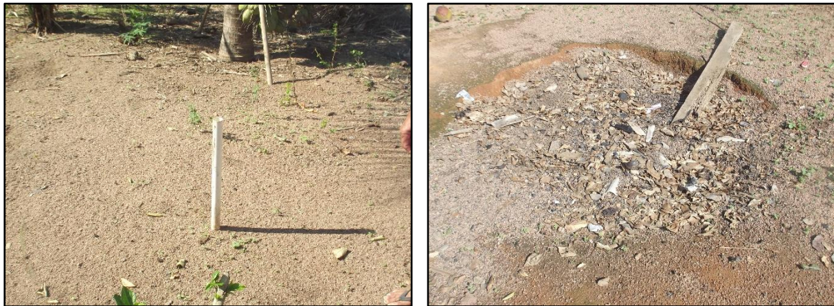
Figura 105. Vista exterior de fossa com suspiro (a) e fossa cobertura de terra (b), Iracema 2, Juína-MT
