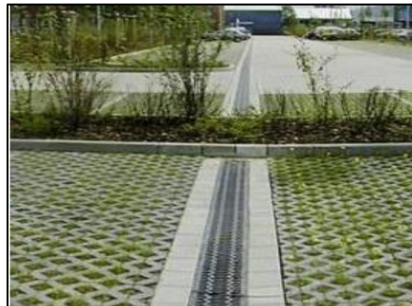
Figura 141. Trincheira de infiltração no estacionamento
