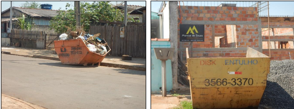
Figura 59. Contêineres contratados para acondicionamento dos RCD
