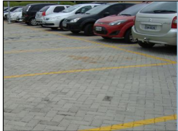
Figura 139. Pavimento poroso instalado em estacionamento
