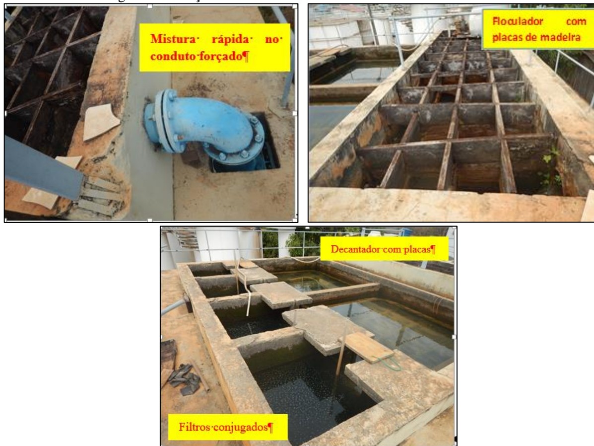
Figura 13. Estação de tratamento em concreto armado aberta – ETA I
