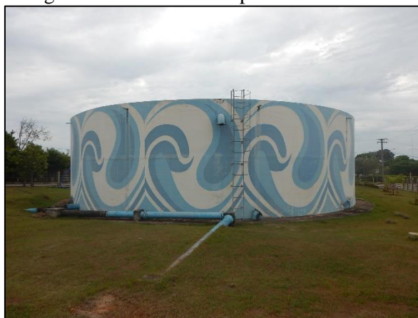
Figura 23. Reservatório apoiado de 1.000 m 3
