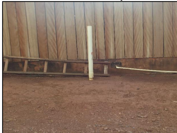
Figura 111. Vista exterior de fossa com suspiro, Iracema 3, Juína-MT
