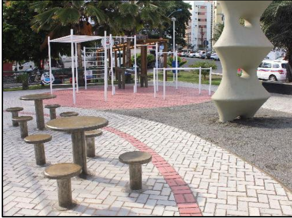
Figura 136. Pavimento poroso – piso intertravado instalado em praça
