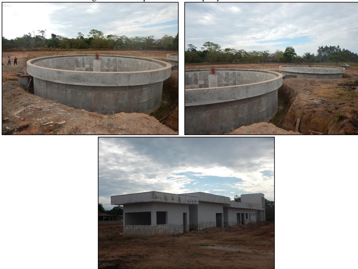
Figura 41. Obra paralisada de ampliação do SES de Juína
