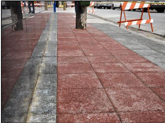
Figura 138. Pavimento poroso – piso intertravado instalado em passeio público
