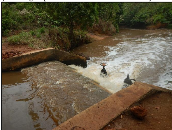
Figura 9. Captação de água por tomada indireta com elevação de nível, Juína-MT
