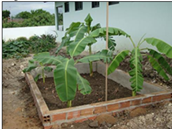
Figura 117. Fossa bananeira em funcionamento
