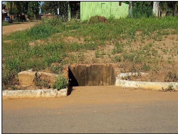
Figura 45. Boca de lobo sem tampa na Rua Juscelino Kubistchek (2)
