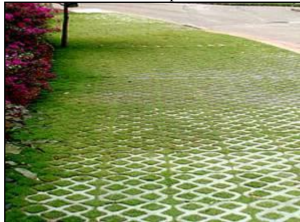
Figura 125. Pavimento poroso – concregrama instalado em passeio
