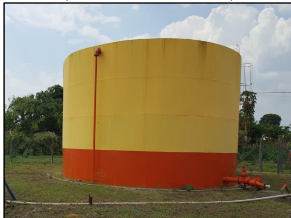
Figura 24. Reservatório inativo no Setor Centro (bairro Recanto dos Pássaros)
