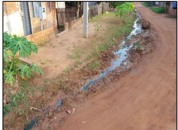
Figura 33. Esgoto sanitário a céu aberto na Av. Curitiba (Setor Boa Esperança)
