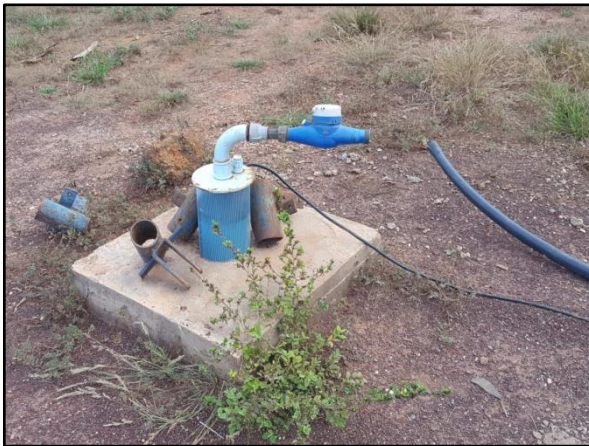
Figura 92. Poço tubular profundo construído na comunidade de Gavião, em Denise-MT
