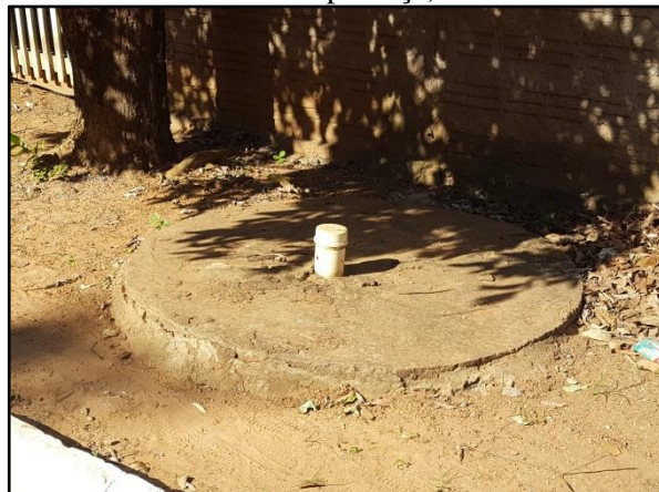
Figura 29. Fossa absorvente no passeio de uma residência localizada na Rua Seis de Maio (Setor Boa Esperança)
