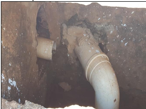
Figura 40. Ligação de esgoto no sistema de águas pluviais na Av. Mato Grosso
