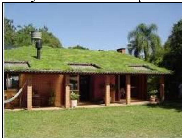
Figura 123. Telhado verde com plantas
