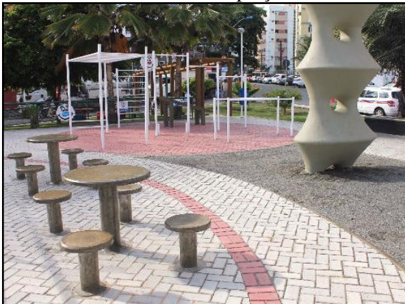
Figura 124. Pavimento poroso – piso intertravado instalado em praça
