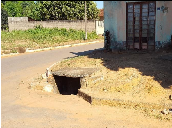
Figura 49. Boca de lobo com engolimento muito grande localizada na rua Juscelino Kubistchek
