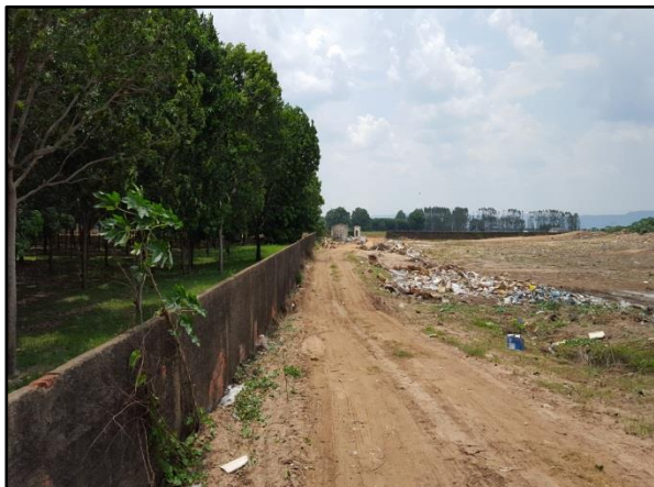
Figura 66. Muro de alvenaria no perímetro da área do lixão de Denise
