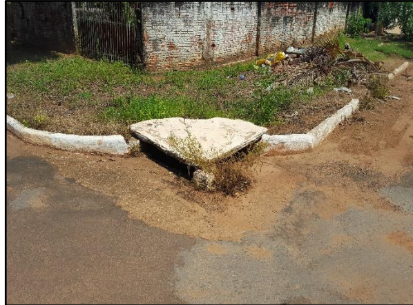
Figura 50. Boca de lobo localizada de forma inadequada na esquina da Rua Antônio Alves Teixeira com a Rua Juscelino Kubistchek
