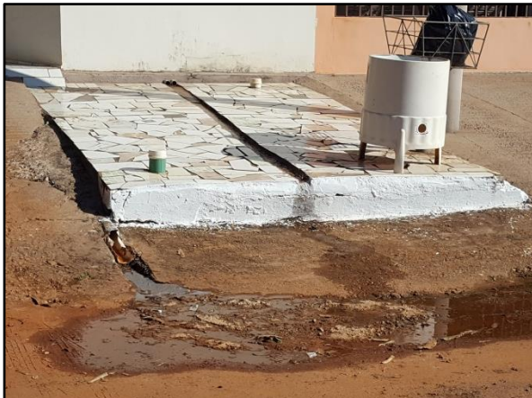
Figura 32. Lançamento de águas servidas na via pública de uma residência localizada na Rua Juscelino Kubitschek
