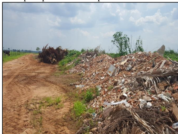
Figura 84. RCD depositado juntamente com resíduos da limpeza pública na área para resíduos inertes
