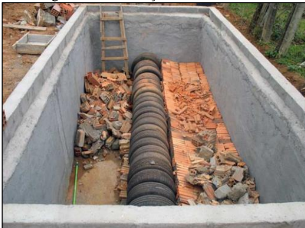
Figura 116. Execução fossa bananeira
