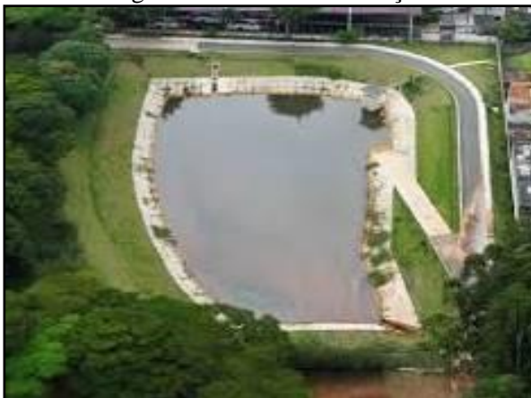
Figura 132. Bacia de detenção
