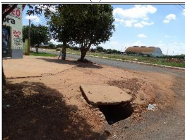
Figura 36. Bocas de lobo do bairro Jardim das Palmeiras (A) Dispositivo com abertura inadequada (B) Dispositivo entupido
