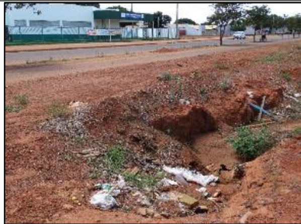
Figura 37. (A) Intensa erosão ocasionando acúmulo de água no bairro Jardim das Palmeiras (B) Resíduos acumulados nas erosões
