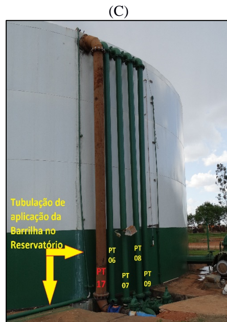
Figura 23. Aplicação de solução de cloro no reservatório para desinfecção
