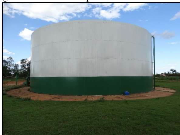
Figura 26. Reservatório apoiado metálico de 1.000 m 3
