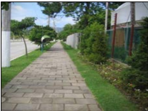
Figura 117. Vala de retenção ao longo da rua
