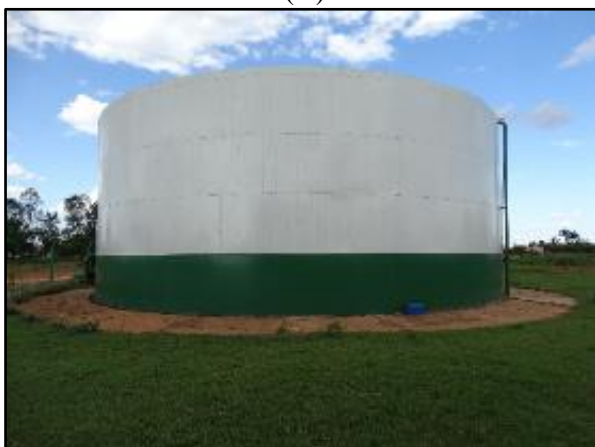
Figura 22. (A) Reservatório de 1.000m 3 da ETA (B) Detalhe da tubulação de entrada dos PT 17, PT 06, PT 07, PT 08 e PT 09 respectivamente (C) Aplicação de barrilha no reservatório para correção do pH
