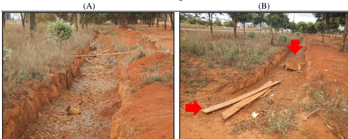
Figura 81. (A) Canal de drenagem para escoamento das águas (B) Resíduos observados no canal de drenagem
