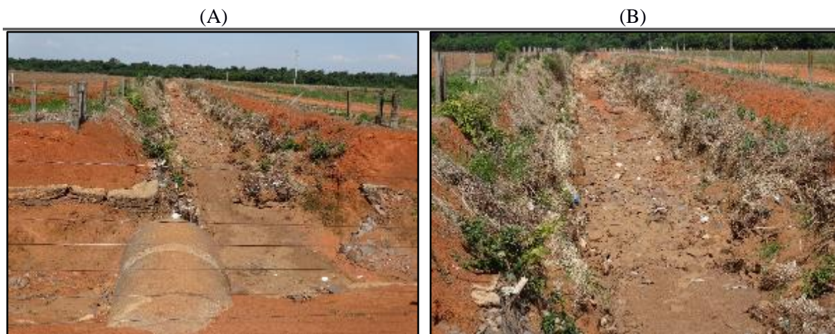
Figura 44. (A) Local de cruzamento da bacia de contenção paralela à Rua Sucupira, com a bacia de contenção direcionada ao Rio Membeça (B) Detalhes do cruzamento (C) Gabiões danificados com o acúmulo de resíduos
