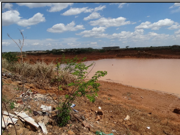
Figura 34. (A) Bacias de infiltração localizadas no bairro Jardim das Palmeiras (B) Resíduos dispostos nas margens da bacia de infiltração
