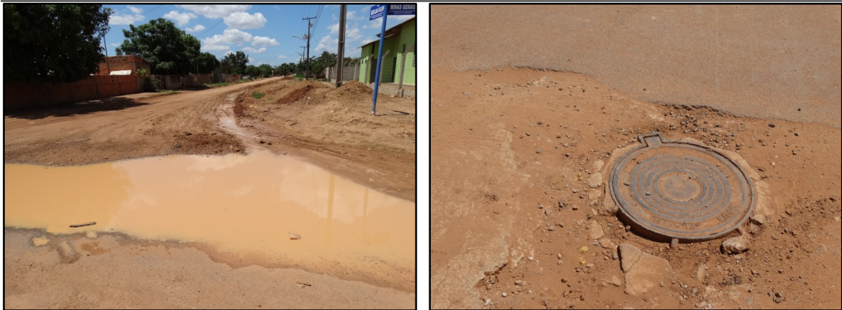
Figura 49. Processos erosivos registrados no bairro Jardim das Palmeiras (A) Acúmulo de água nos processos erosivos (B) Erosão do pavimento no entorno da caixa de inspeção
