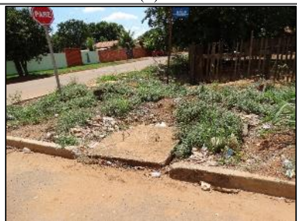
Figura 36. Bocas de lobo do bairro Jardim das Palmeiras (A) Dispositivo com abertura inadequada (B) Dispositivo entupido
