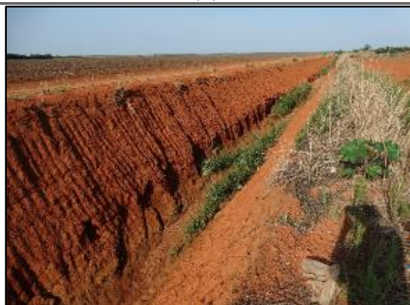
Figura 38. (A) Bacia de infiltração localizada no final do Palmeiras (B) Extenso canal de drenagem direcionando as águas pluviais para a bacia de infiltração do bairro Palmeiras
