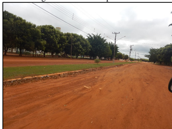
Figura 80. Ruas sem pavimento
