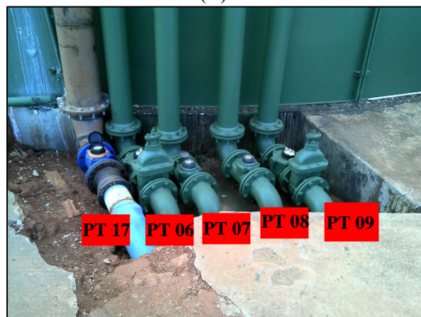
Figura 22. (A) Reservatório de 1.000m 3 da ETA (B) Detalhe da tubulação de entrada dos PT 17, PT 06, PT 07, PT 08 e PT 09 respectivamente (C) Aplicação de barrilha no reservatório para correção do pH
