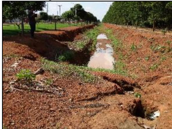
Figura 42. Visão geral da obra executada na Rua Sucupira
