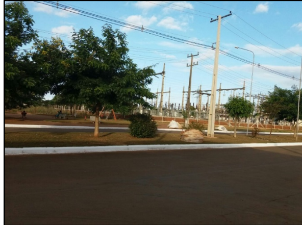
Figura 61. Pintura de meio-fio no bairro Boa Esperança
