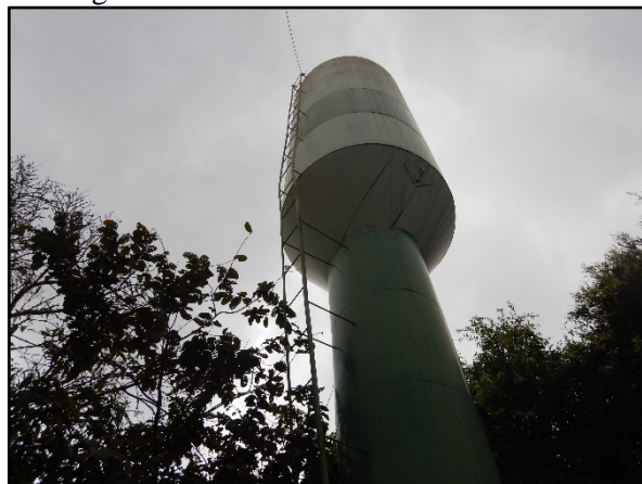
Figura 78. Reservatório elevado de 45 m 3
