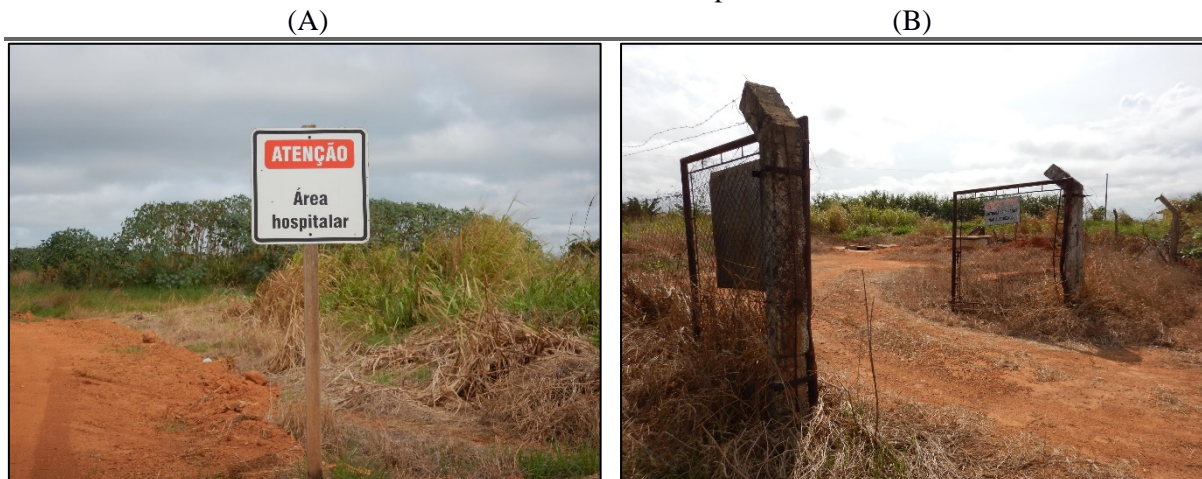
Figura 67. (A) Placas indicativas no lixão municipal (B) Cerca de proteção da área de destinação dos RSS no lixão municipal
