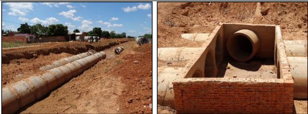
Figura 39. Obras de drenagem sendo executadas no bairro Palmeiras (A) Assentamento das tubulações de concreto (B) Caixa de passagem em construção
