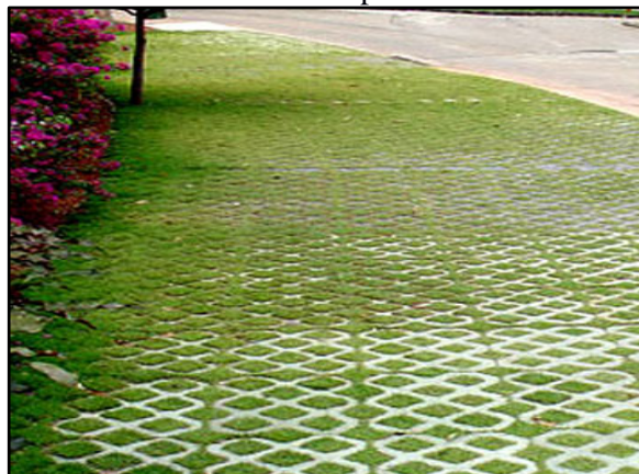
Figura 112. Pavimento poroso – concregrama instalado em passeio
