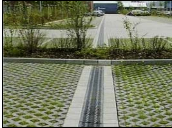
Figura 116. Trincheira de infiltração no estacionamento
