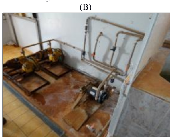
Figura 20. (A) Tanques de preparação das soluções de cloro e barrilha (B) Sistema de bombeamento das soluções para o reservatório de água bruta
