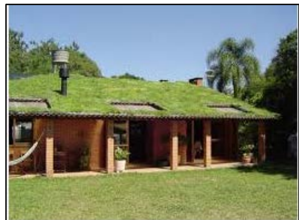
Figura 110. Telhado verde com plantas
