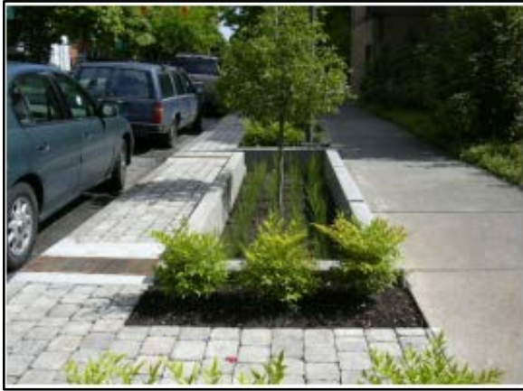
Figura 115. Trincheira de infiltração no passeio
