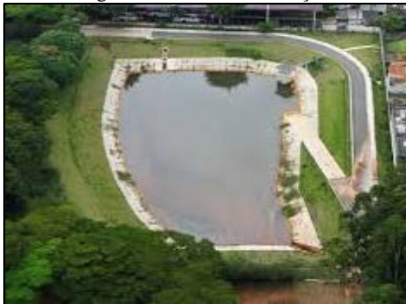
Figura 119. Bacia de detenção
