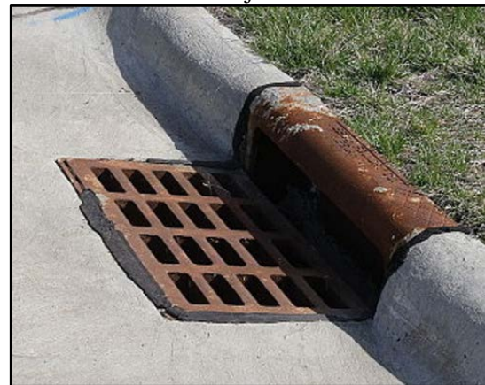
Figura 108. Boca de lobo com gradeamento na sarjeta
