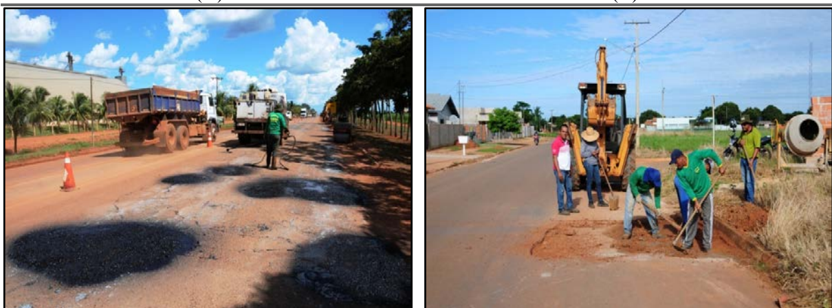
Figura 50. Operação “Tapa Buracos” em Campo Novo do Parecis (A) Visão geral da rua após o conserto dos buracos (B) Funcionários nivelando os buracos para serem consertados
