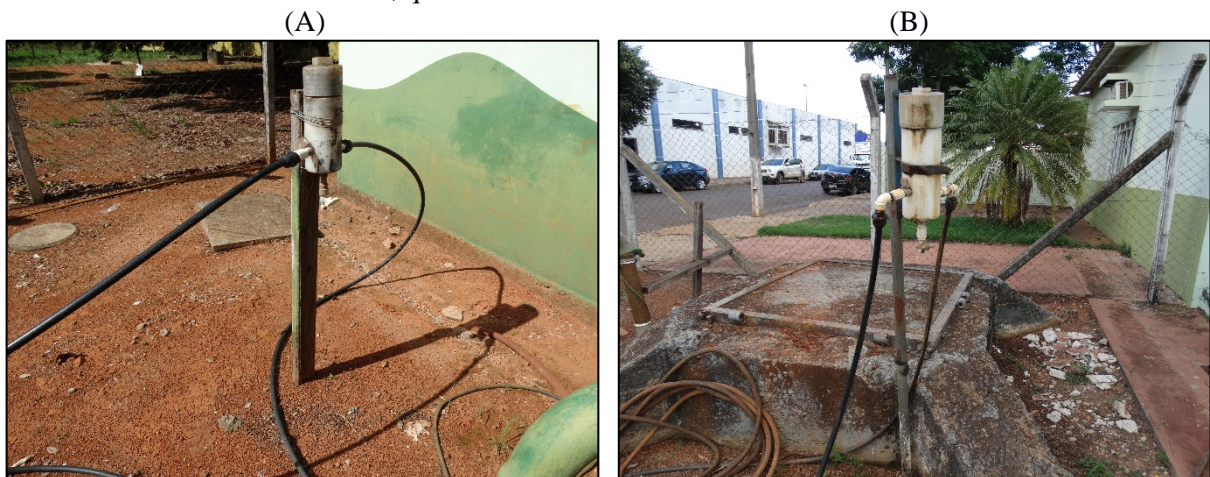
Figura 16. Dispositivo de cloração por pastilha (A) do PT 03, que se encontra desativado (B) do PT 05, que se também se encontra desativado
