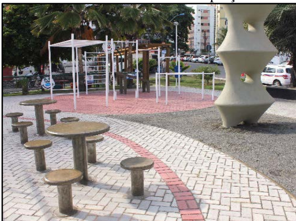
Figura 111. Pavimento poroso – piso intertravado instalado em praça
